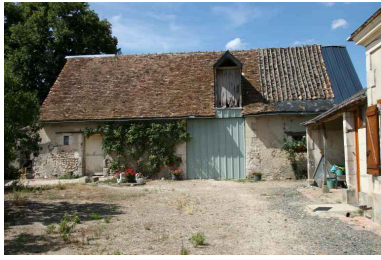
L'étable : façade sur cour. Phot. Jean-Baptiste Darrasse IVR52_20067206605NUCA
