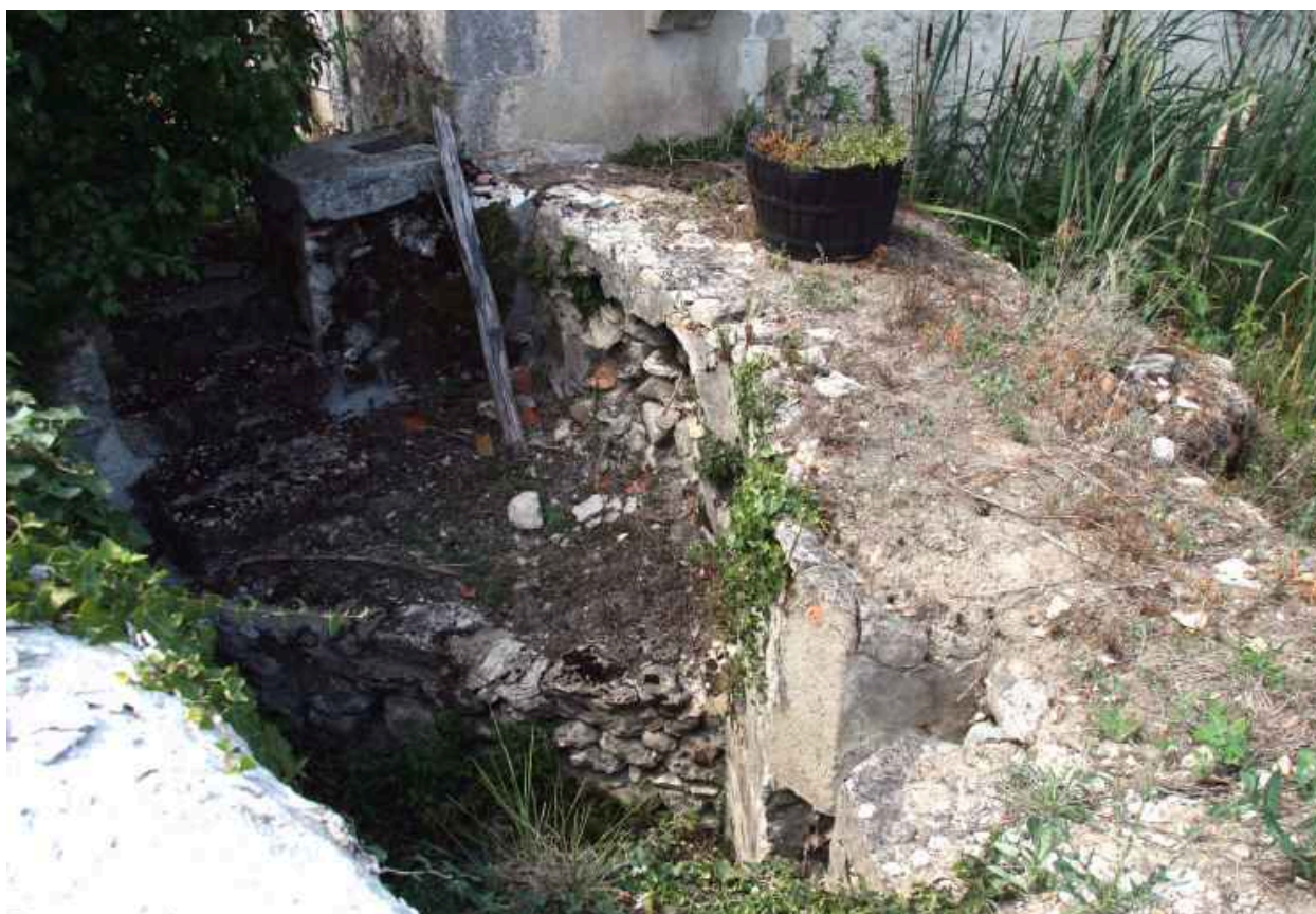
Vue du bief.
