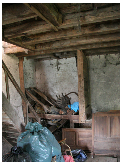
Le moulin : vestiges de l'organisation intérieure. Phot. Jean-Baptiste Darrasse IVR52_20077200891NUCA
