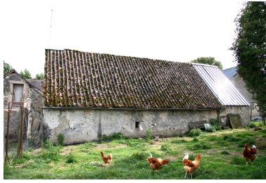
L'étable, façade postérieure : couverture de tuiles courbes. Phot. Jean-Baptiste Darrasse IVR52_20077200889NUCA
