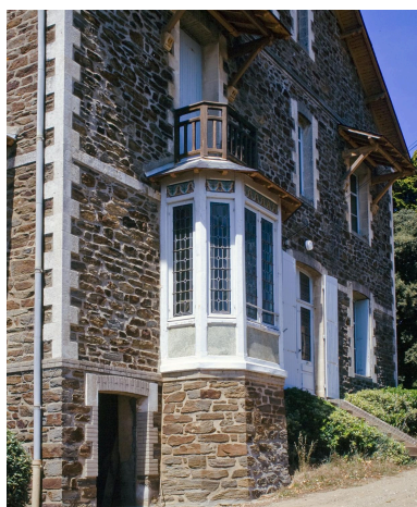
Elévation sud-est de la villa. Phot. Denis Pillet IVR52_19954400670XA
