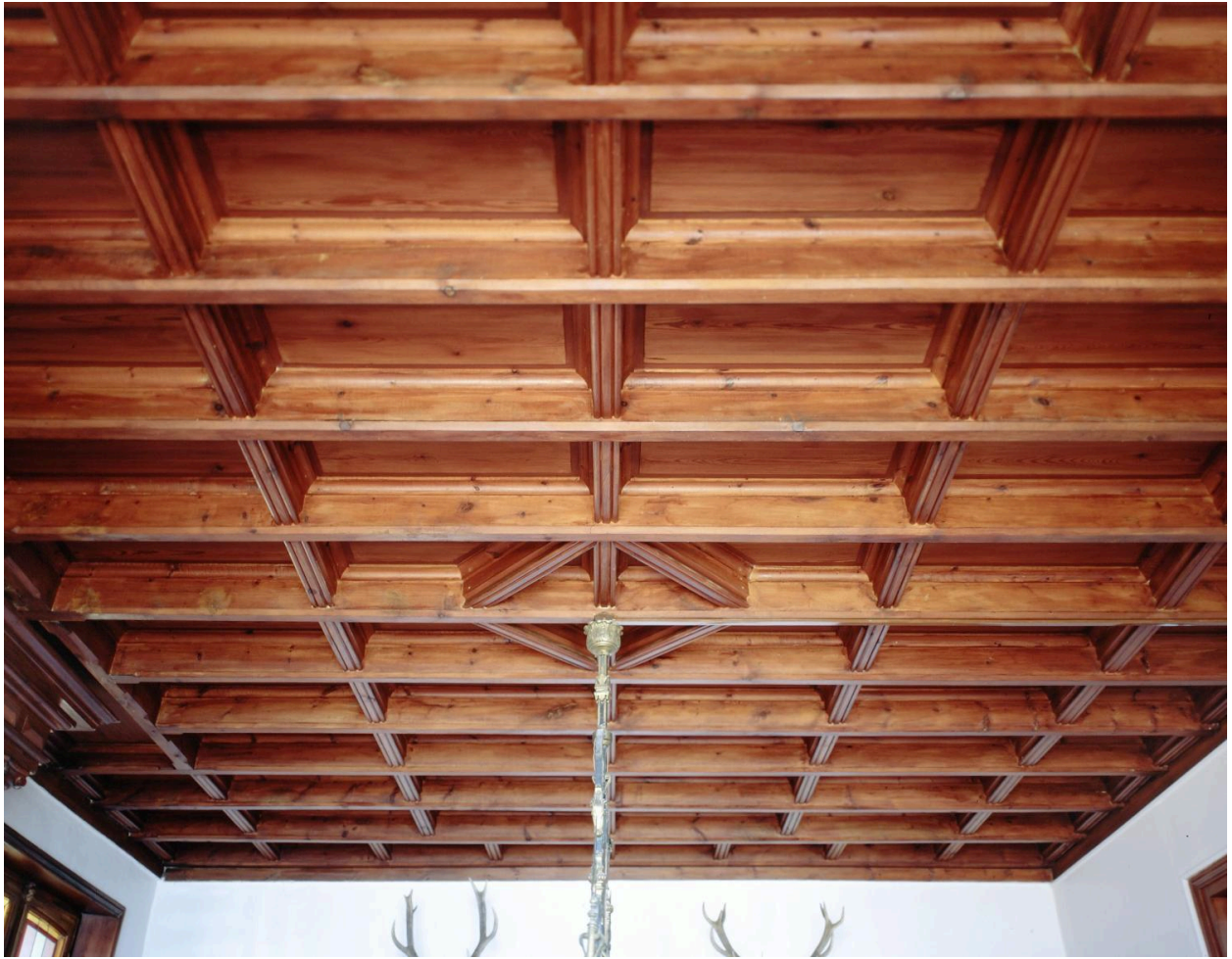
Plafond à caissons de la pièce du rez-de-chaussée, côté nord ouest.
