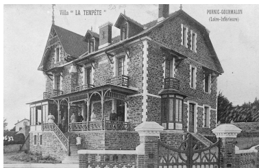
Villa La Tempête, élévations antérieure et latérale ; carte postale, début 20e siècle. (Collection particulière). Repro. Denis Pillet IVR52_19944400448X
