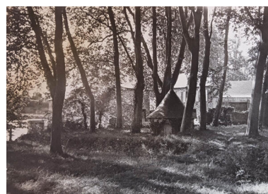
L'édicule abritant le bélier avant destruction, photographie du milieu du XXe siècle. Repro. Pierrick Barreau IVR52_20225301076NUCA
