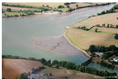
Vue aérienne partielle depuis le sud-est du barrage et de l'étang de retenue, prise lors de la vidange d'octobre 2005. Phot. Dominique Vernier IVR52_20065300830NUCA
