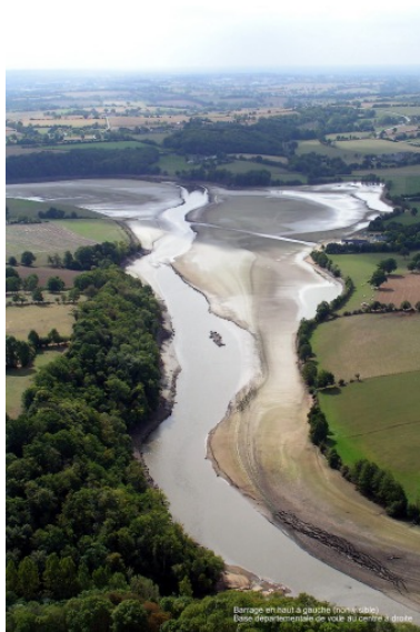
Vue aérienne d'ensemble depuis le nord de l'étang de retenue, prise lors de la vidange d'octobre 2005. Phot. Dominique Vernier IVR52_20065300828NUCA
