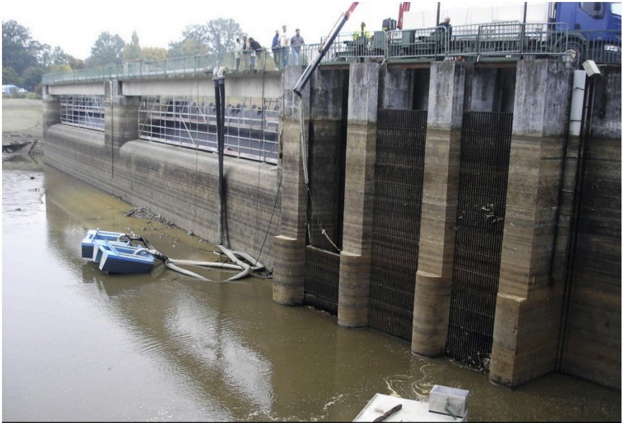
Vue partielle du barrage vue depuis l'aval à l'ouest, lors de la vidange d'octobre 2005.
