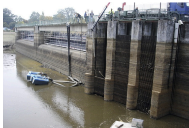
Vue partielle du barrage vue depuis l'aval à l'ouest, lors de la vidange d'octobre 2005. Phot. Dominique Vernier IVR52_20065300831NUCA
