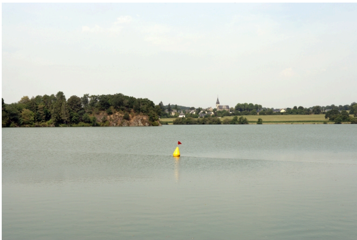
Vue partielle de l'étang de retenue depuis l'est. Au fond le bourg de la Haie-Traversaine.
