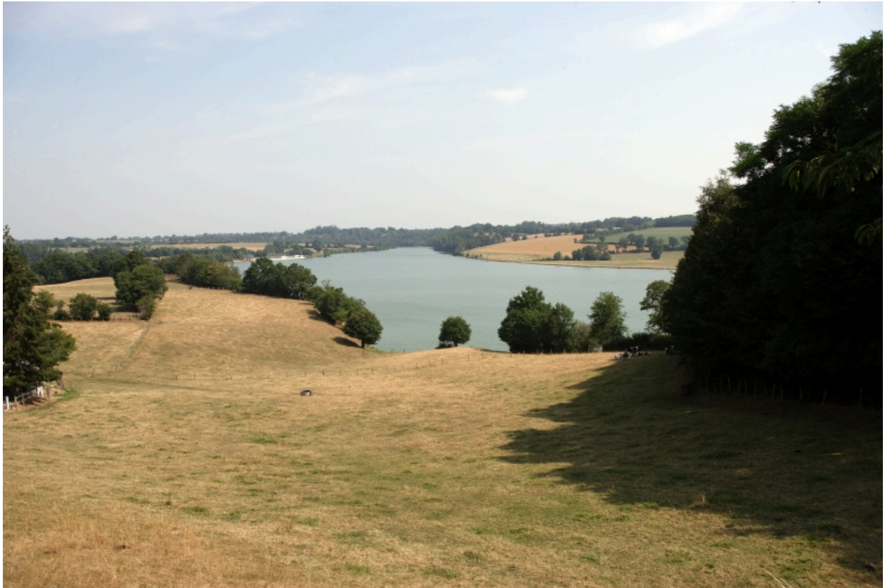
Vue d'ensemble de l'étang de retenue depuis le sud.
