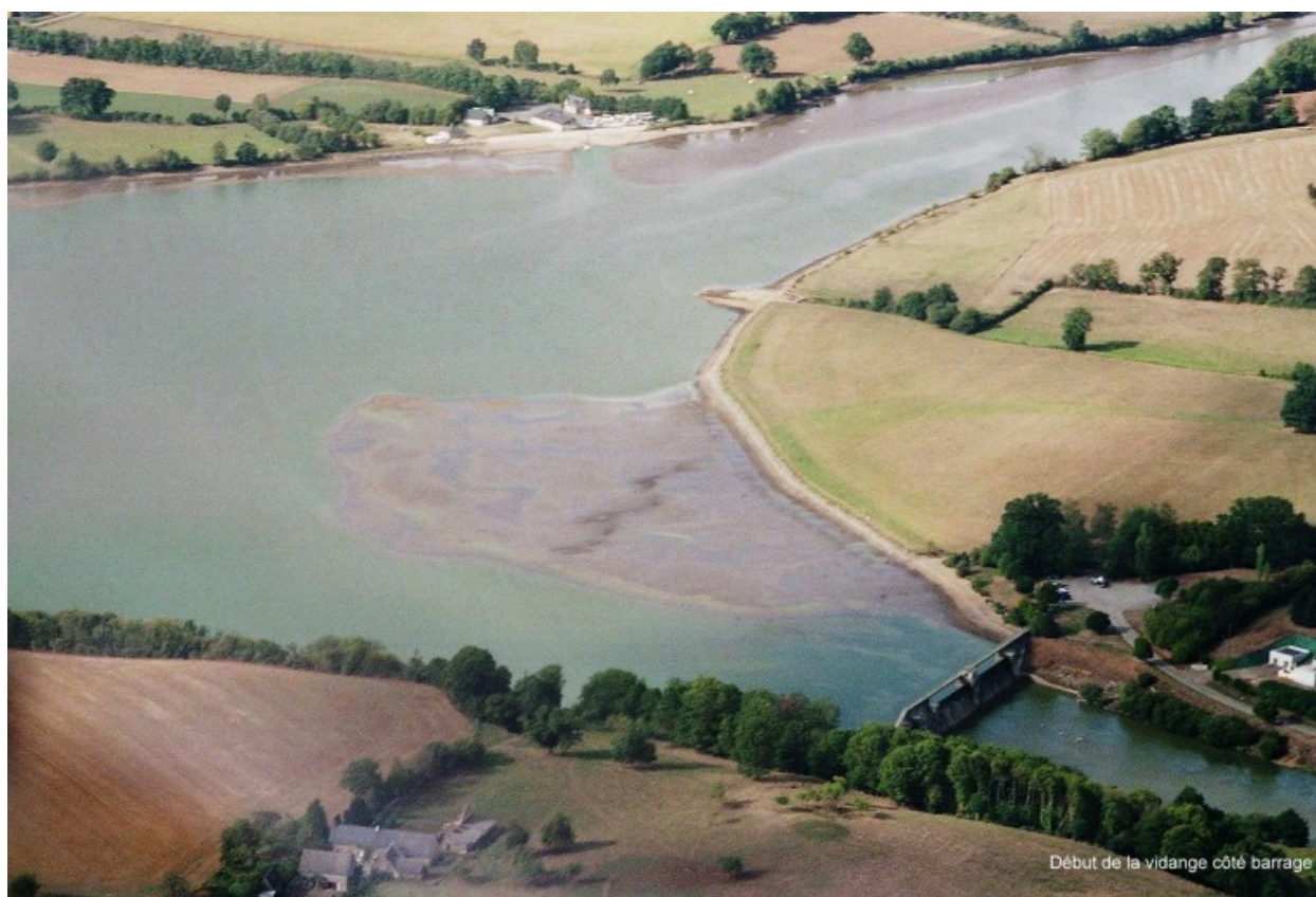
Vue aérienne partielle depuis le sud-est du barrage et de l'étang de retenue, prise lors de la vidange d'octobre 2005.
