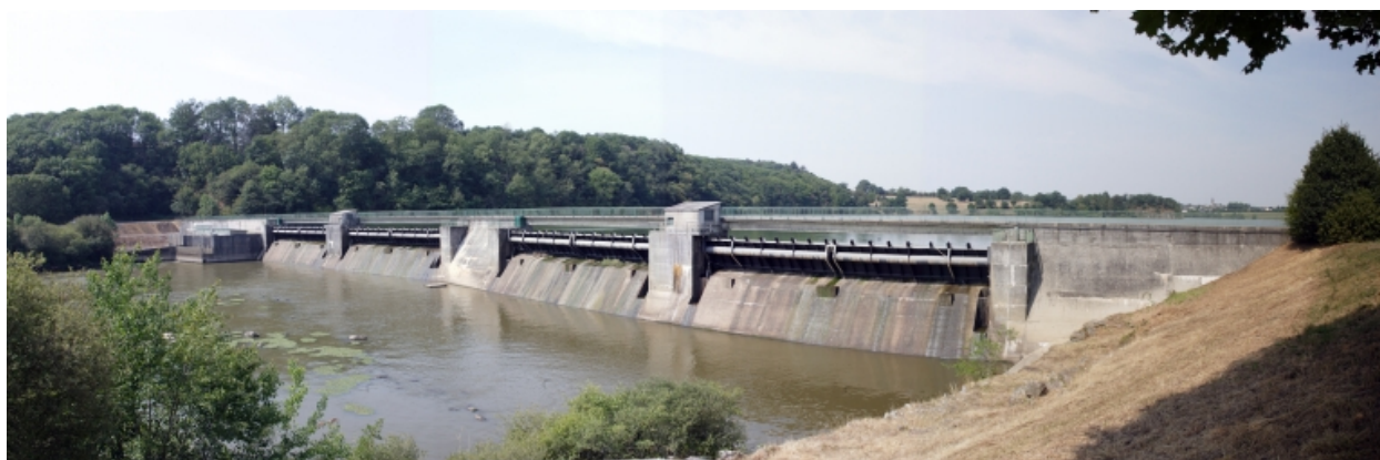
Vue d'ensemble du barrage depuis l'aval au nord-est.
