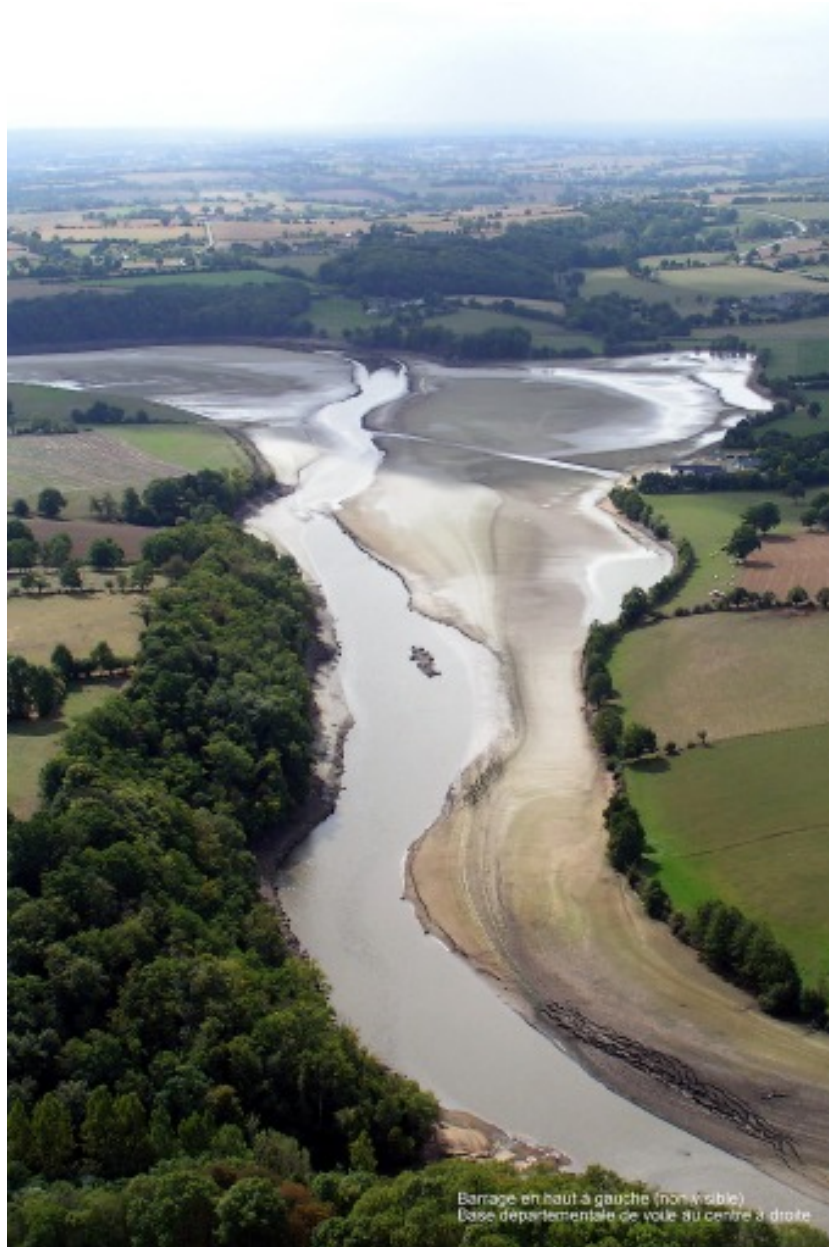
Vue aérienne d'ensemble depuis le nord de l'étang de retenue, prise lors de la vidange d'octobre 2005.
