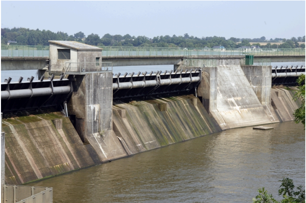
Vue partielle du barrage depuis l'aval au sud-est.
