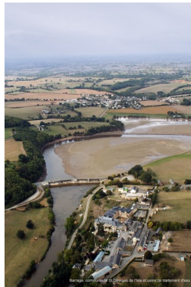
Vue aérienne d'ensemble depuis l'est du barrage et de l'étang de retenue, prise lors de la vidange d'octobre 2005. Au premier plan, la maison de retraite Saint-Georges-de-l'Isle ; au fond, le bourg de la Haie-Traversaine. Phot. Dominique Vernier IVR52_20065300829NUCA
