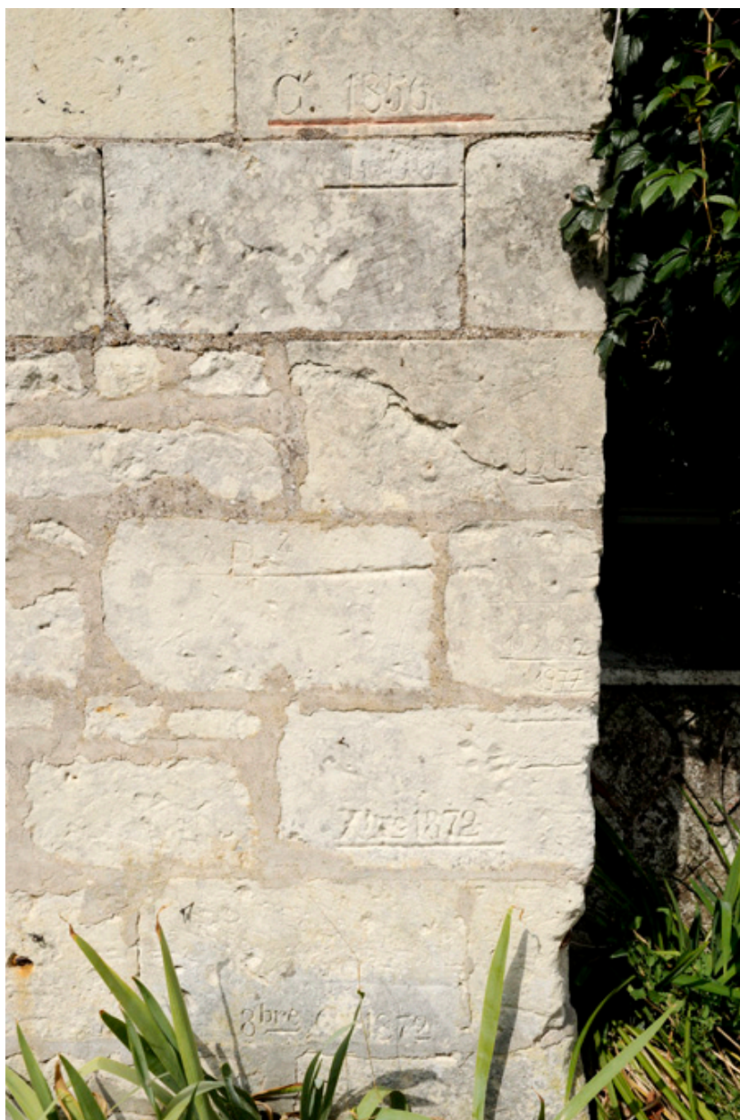
Maison du 35, rue du Port, bâtiment ouest, mur d'entrée, repères de crue : 1856, 1866, 1872 (septembre et octobre), 1936, 1945, 1977, 1982.
