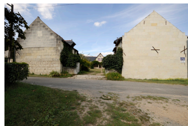
Maison du 35, rue du Port, vue depuis la rue : dépendances d'entrée et corps principal en arrière-plan. Phot. Bruno Rousseau IVR52_20114902421NUCA
