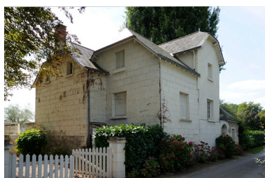
Maison (28, rue du Port). Construite au XIXe siècle du côté sud de la rue du Port, elle fut remaniée au XXe en référence aux résidences de villégiature (toiture débordante en demi-croupe). Phot. Bruno Rousseau IVR52_20114902412NUCA
