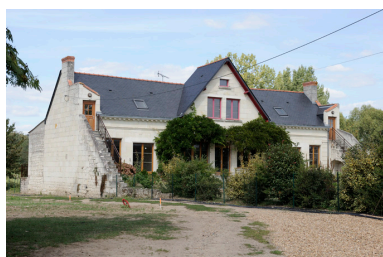
Maison du 35, rue du Port, vue d'ensemble du bâtiment principal. Phot. Bruno Rousseau IVR52_20114902422NUCA
