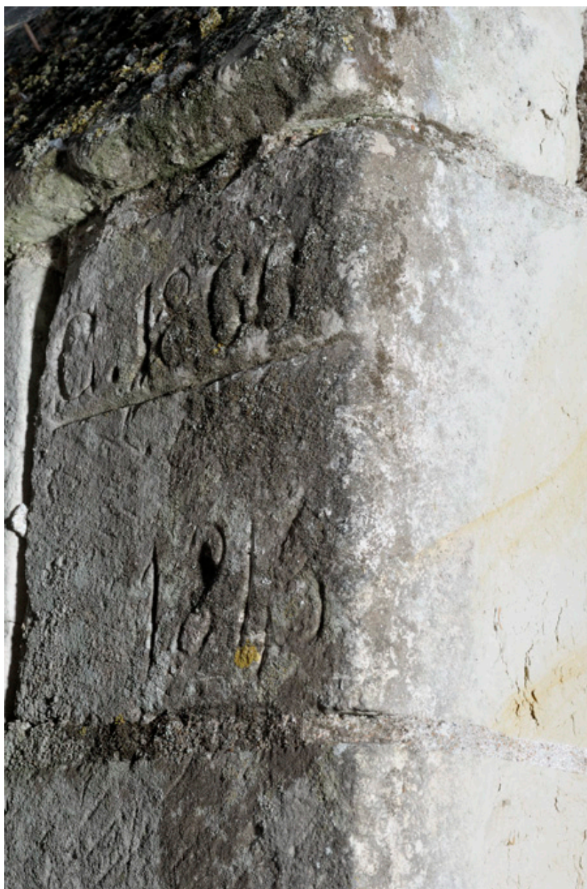
Portail du 5, rue du Port, avec repères de crues. Détail des assises hautes (1866, 1843).
