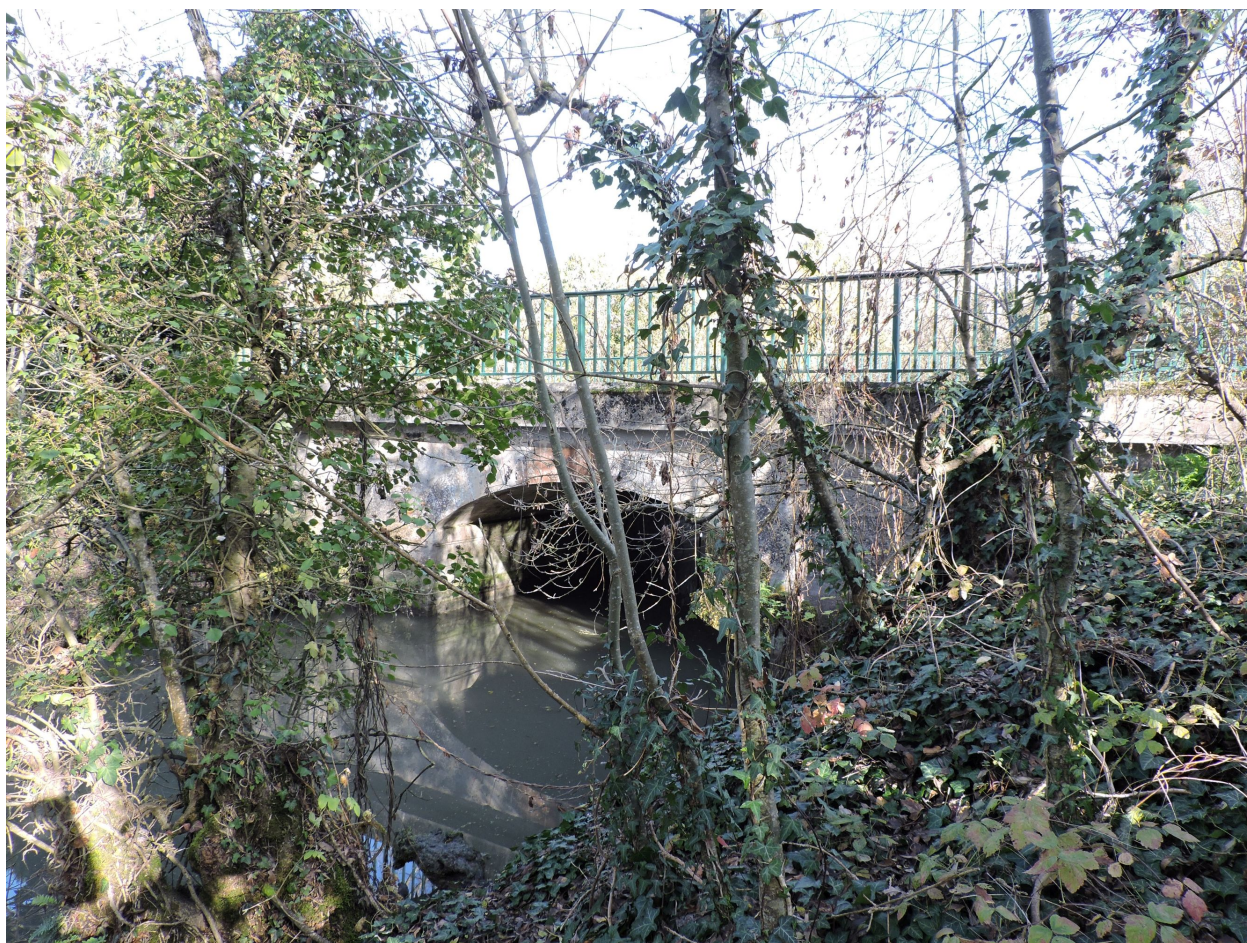
Le pont sur le canal de Vix, côté aval, vu depuis le sud-ouest.
