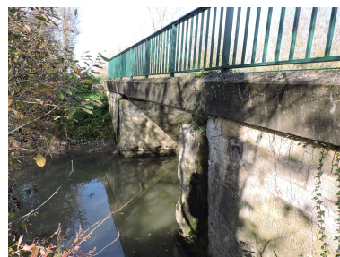
Le pont sur le Contrebot de Vix vu depuis le sud-ouest, côté aval. Phot. Yannis Suire IVR52_20218500706NUCA
