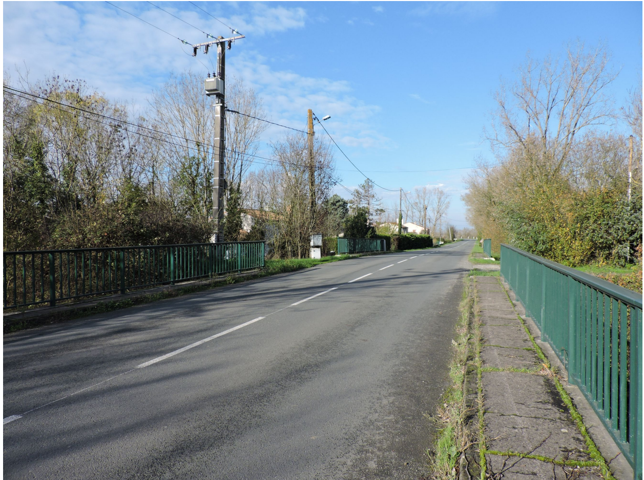
La route D25 franchissant les deux ponts, vue depuis le sud.
