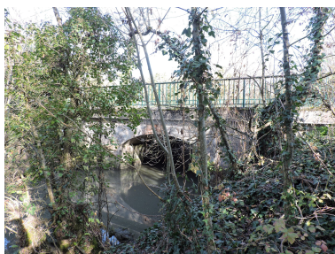
Le pont sur le canal de Vix, côté aval, vu depuis le sud-ouest. Phot. Yannis Suire IVR52_20218500704NUCA
