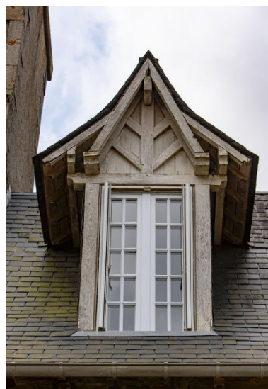
Une lucarne de l'aile est. Phot. Pierre-Bernard Fourny IVR52_20235300931NUCA
