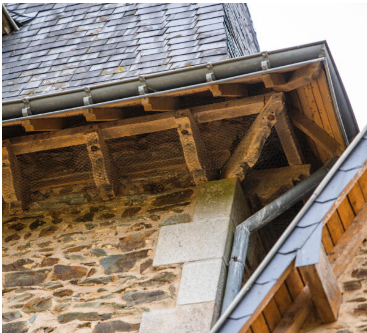
Un détail des supports de débord de toiture.
