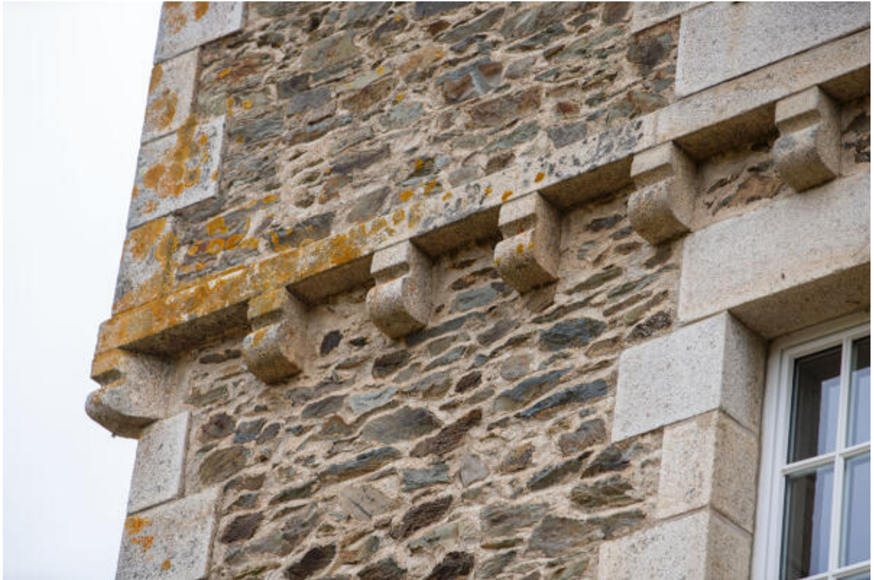
Un détail de l'encorbellement de la tour d'escalier.
