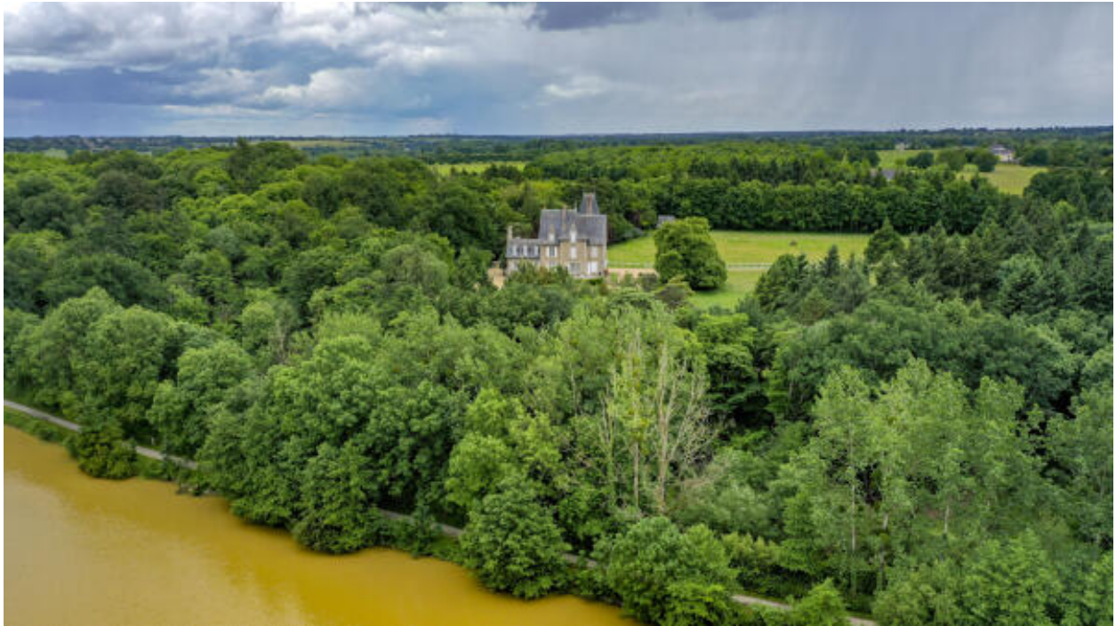
Une vue aérienne du site.
