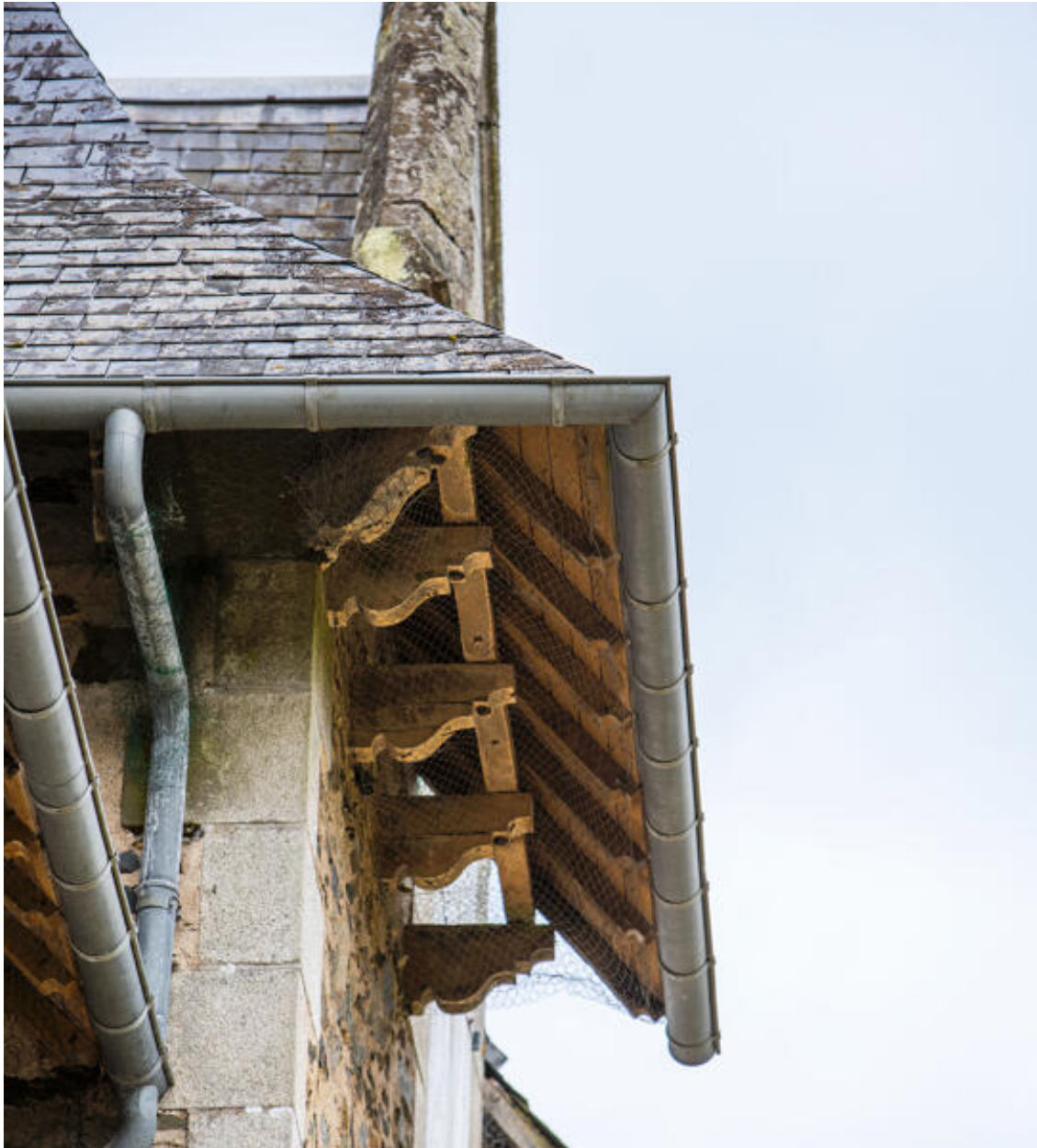
Un détail des supports de débord de toiture.
