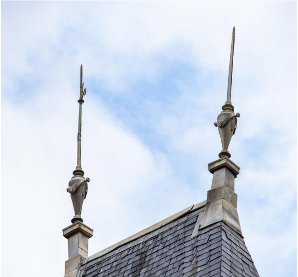
Les épis de faîtage de la tour d'escalier.
