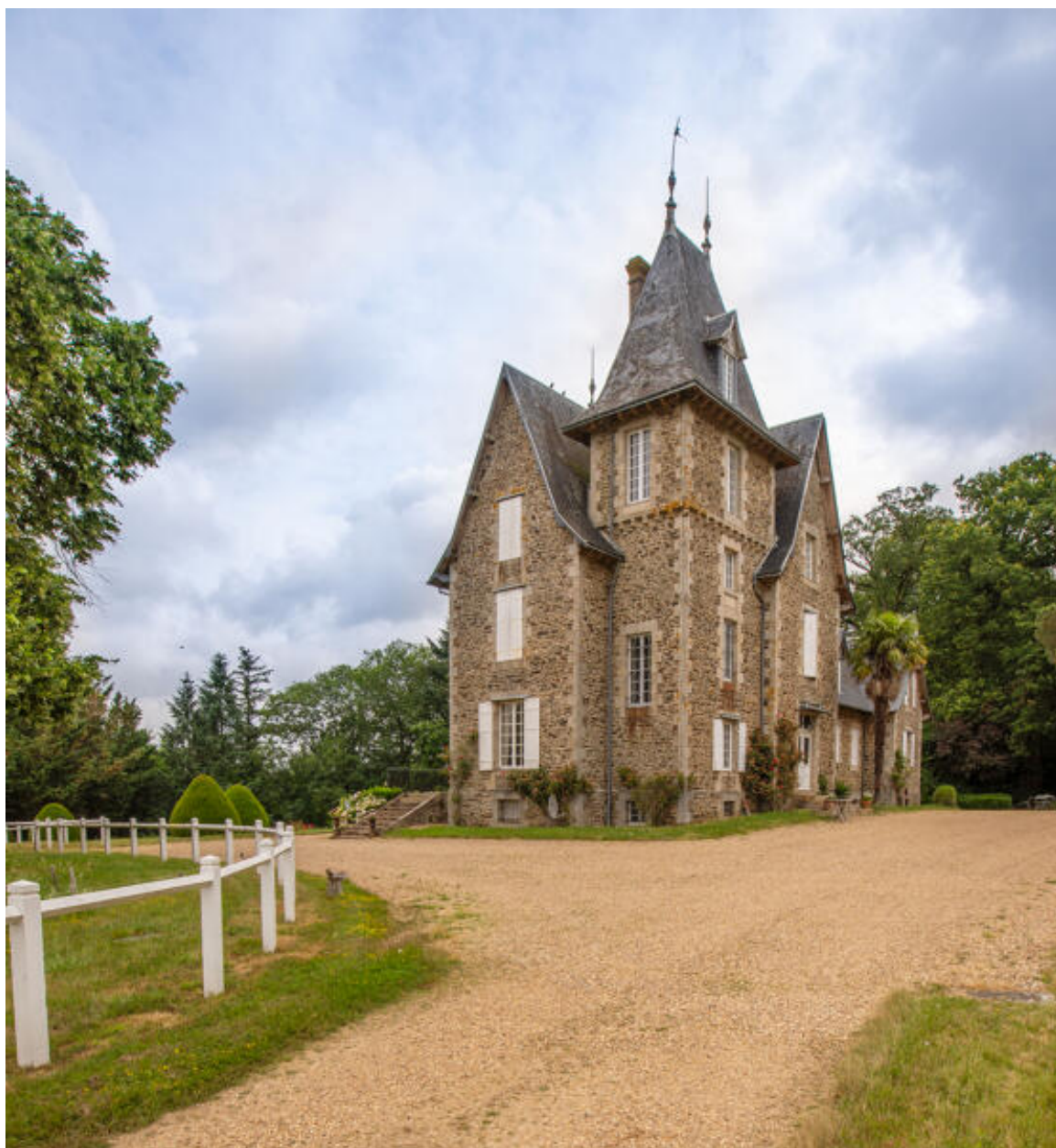
La demeure depuis l'ouest et la tour d'escalier.
