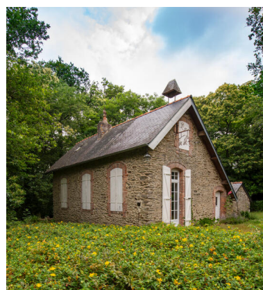
Le logement de jardinier. Phot. Pierre-Bernard Fourny IVR52_20235300907NUCA
