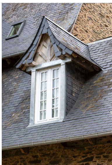
Une lucarne de l'aile est. Phot. Pierre-Bernard Fourny IVR52_20235300925NUCA
