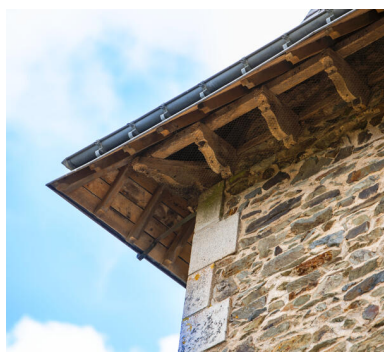
Un détail des supports de débord de toiture. Phot. Pierre-Bernard Fourny IVR52_20235300927NUCA
