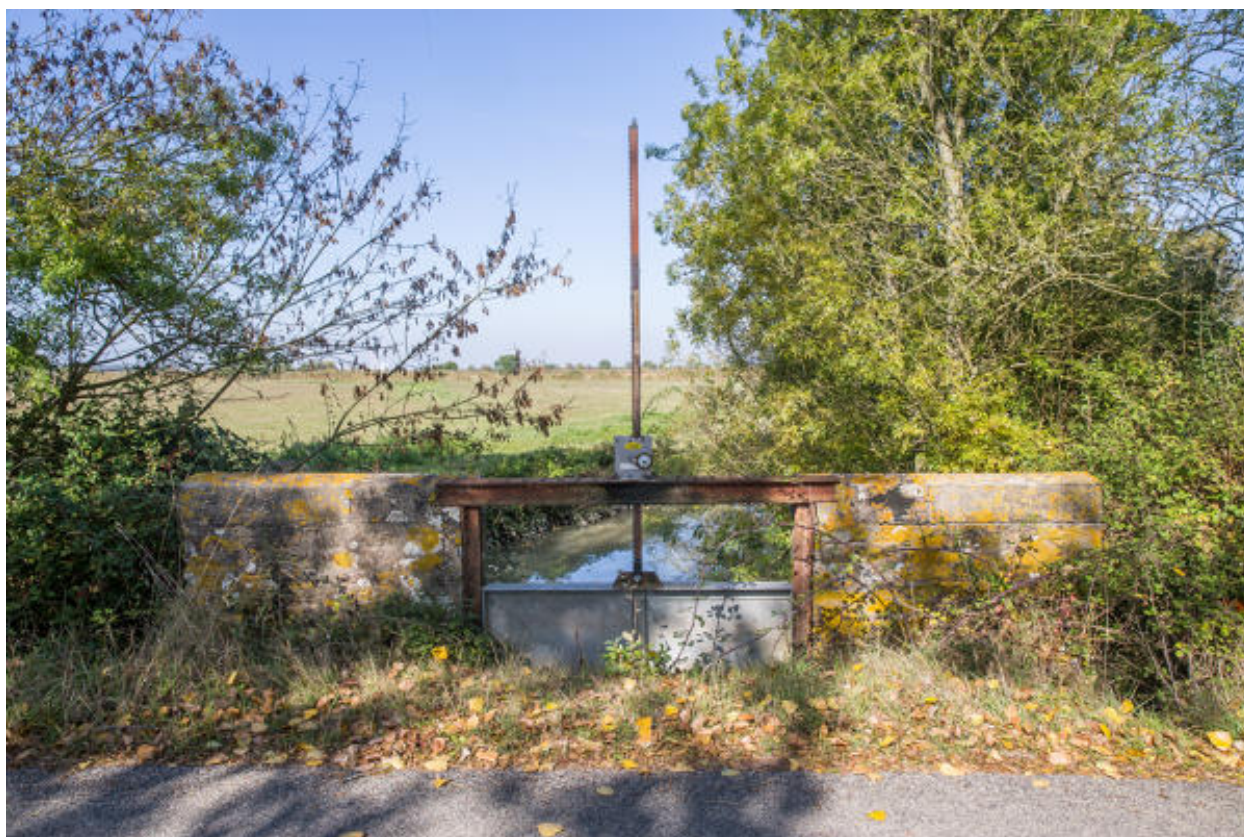
Vanne à l'intersection du canal de la Musse et de l'étier des Bas Cunauds.
