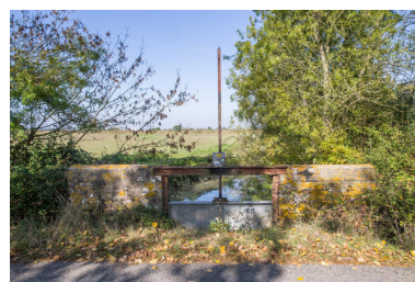
Vanne à l'intersection du canal de la Musse et de l'étier des Bas Cunauds. Phot. Pierre-Bernard Fourny IVR52_20184400688NUCA
