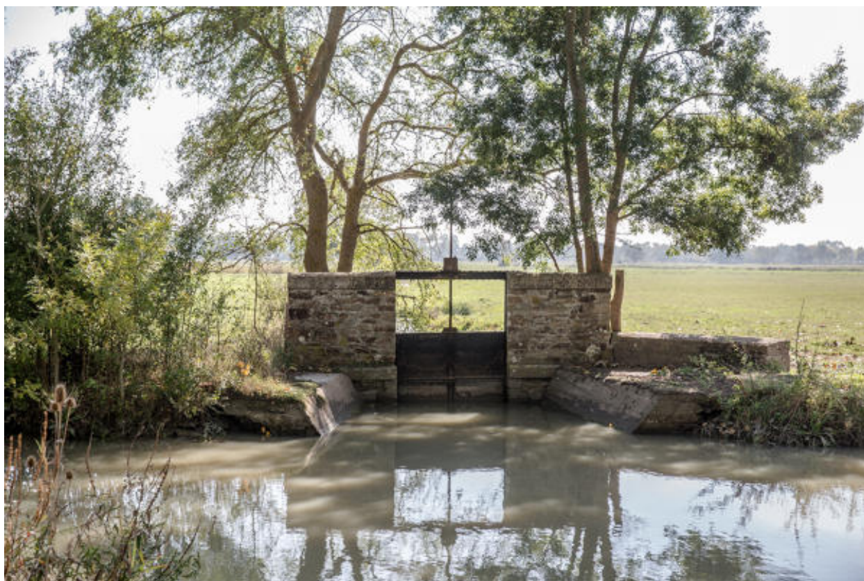
Vanne à l'intersection du canal de la Musse et de l'étier de la Rabattière.
