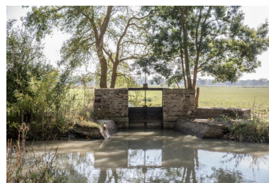
Vanne à l'intersection du canal de la Musse et de l'étier de la Rabatière. Phot. Pierre-Bernard Fourny IVR52_20184400676NUCA
