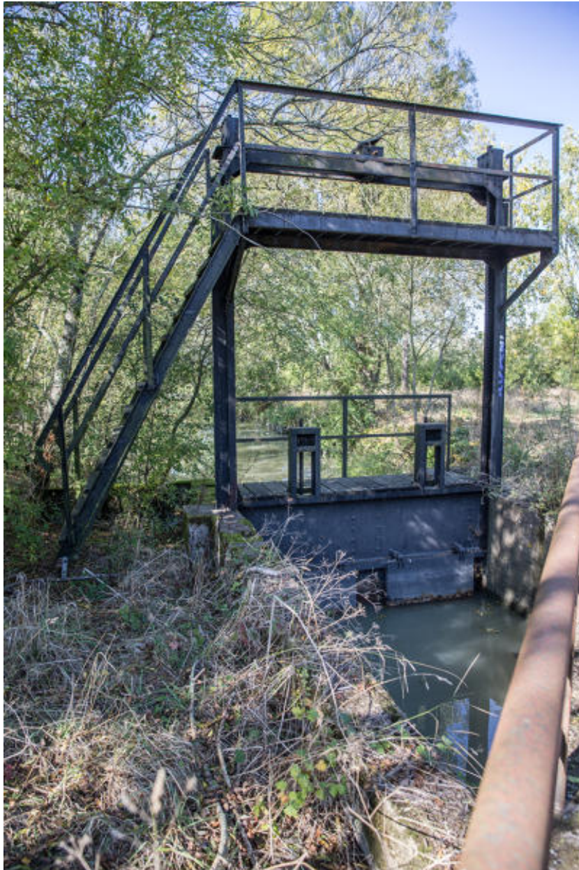
Vannage situé à l'intersection entre l'étier principal de la Musse et l'étier de la route de la Grande Vallée.
