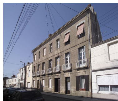
N° 26 rue du Faisan : la façade antérieure. Phot. Denis Pillet IVR52_20034401220NUCA
