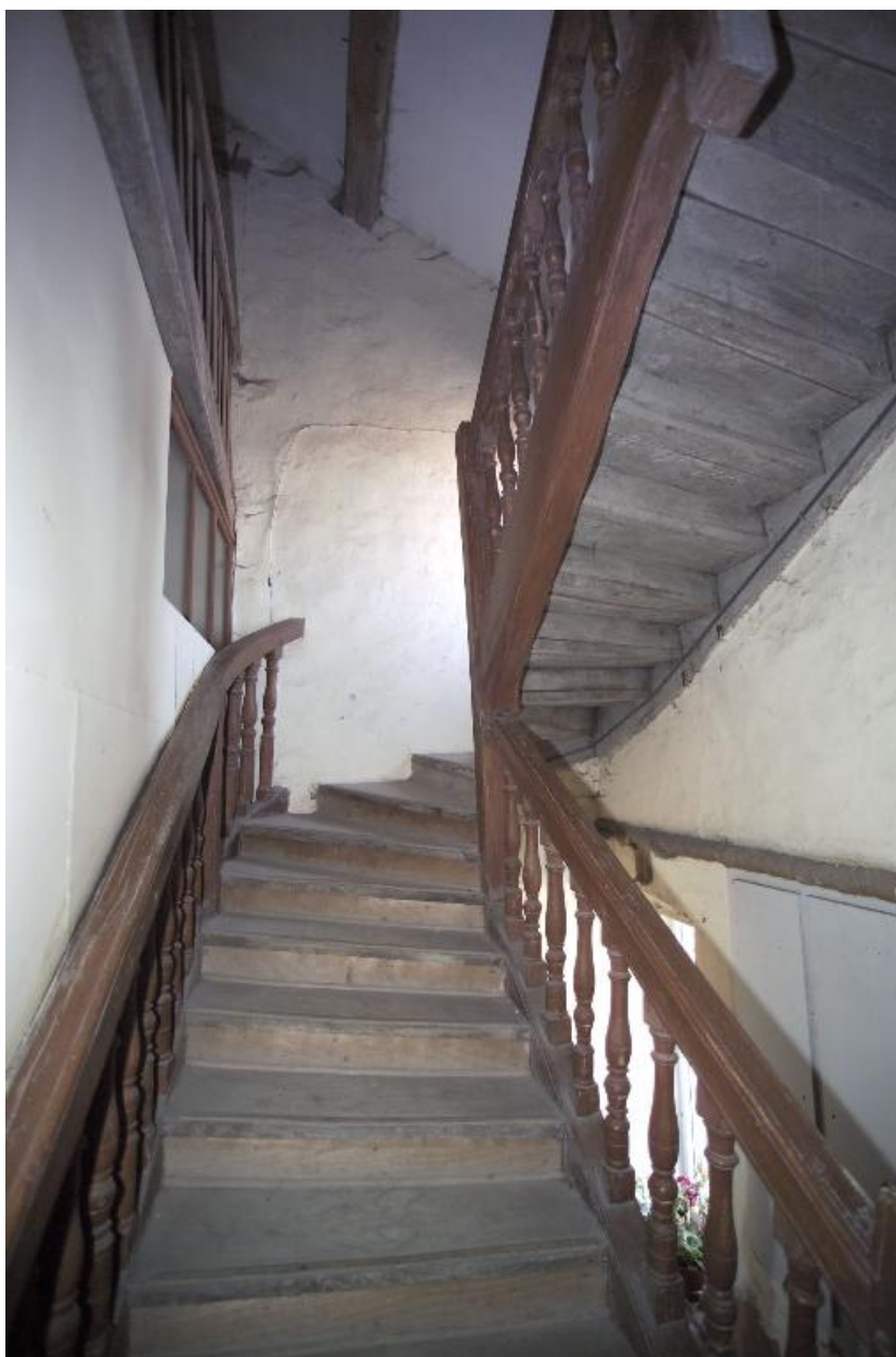
N° 26 rue du Faisan : l'escalier.
