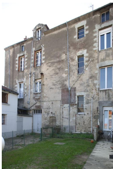
N° 26 rue du Faisan, la façade postérieure. Phot. François Lasa IVR52_20054401382NUCA
