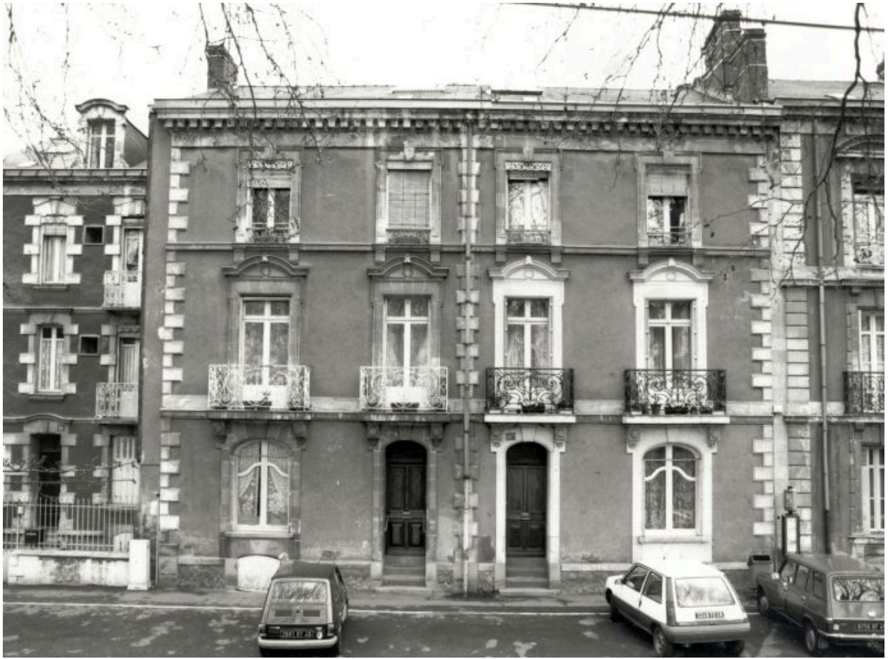
Façade sur rue, en 1993.
