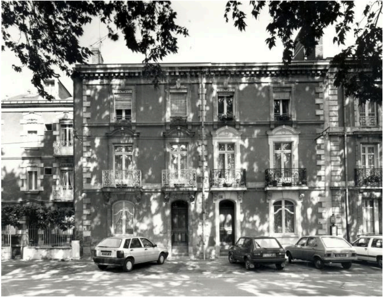
Façade sur rue, en 1991.
