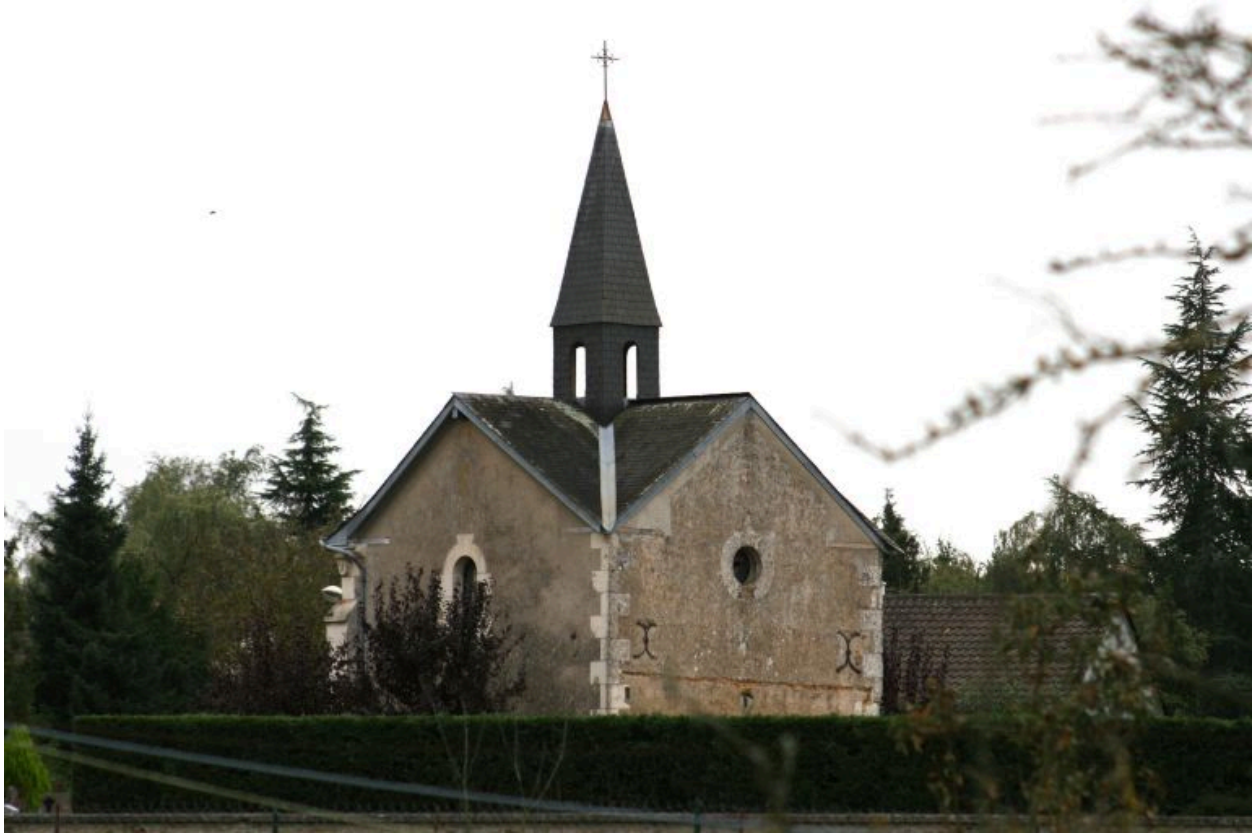
Vue d'ensemble prise depuis la route de La Flèche.
