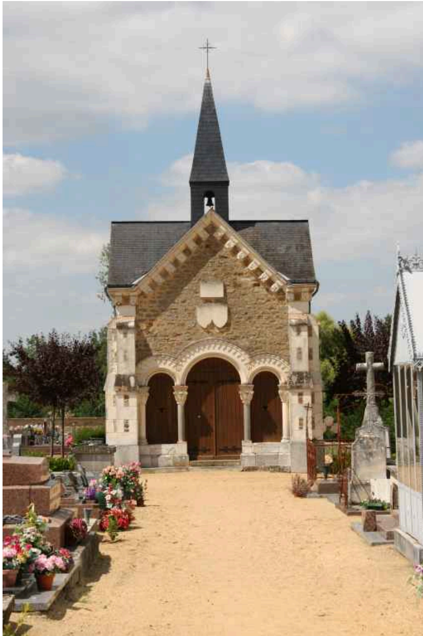
Vue d'ensemble : façade antérieure.
