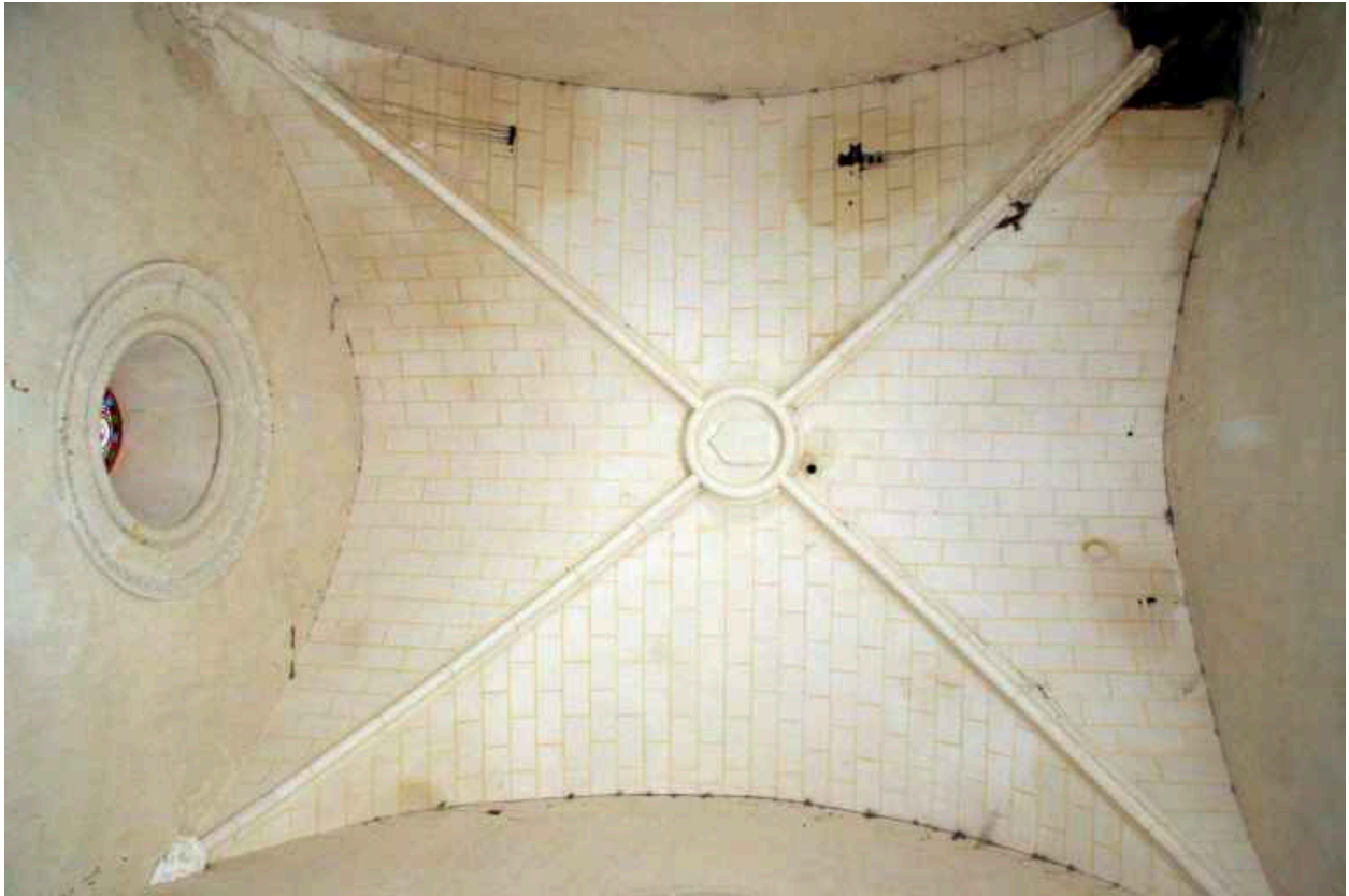
Fausse voûte d'ogives.
