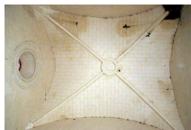
Fausse voûte d'ogives. Phot. Jean-Baptiste Darrasse IVR52_20067207015NUCA
