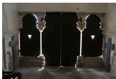
Revers de la façade fermée de volets de bois. Phot. Jean-Baptiste Darrasse IVR52_20067207019NUCA
