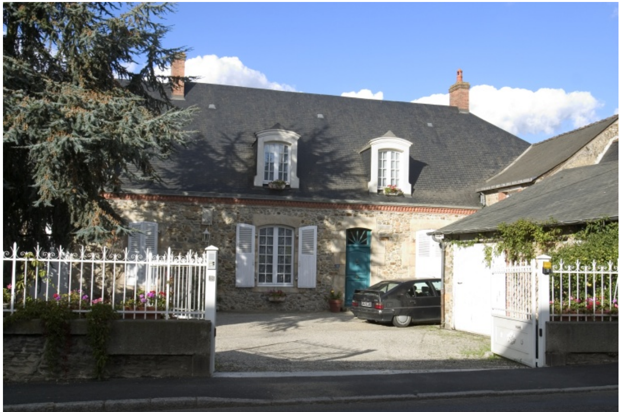
Vue d'ensemble depuis la rue.
