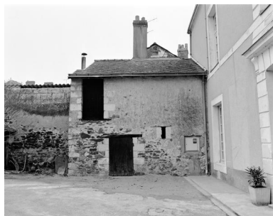
Bâtiment est, façade antérieure. Phot. Bruno Rousseau IVR52_19854902237X
