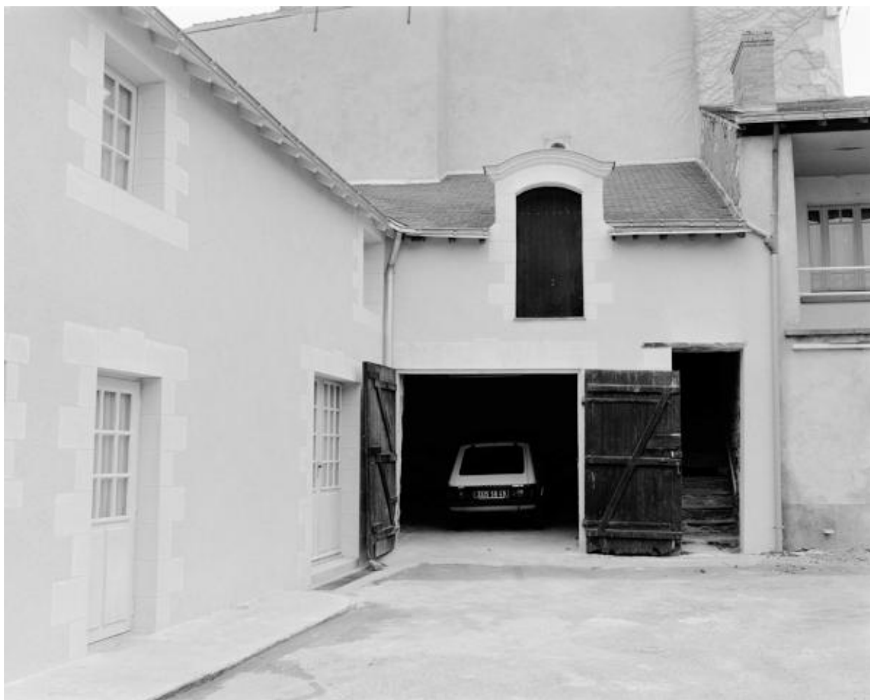
Bâtiment ouest, anciennes écuries.
