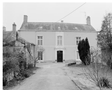
Vue d'ensemble de la façade antérieure. Phot. Bruno Rousseau IVR52_19854902236X
