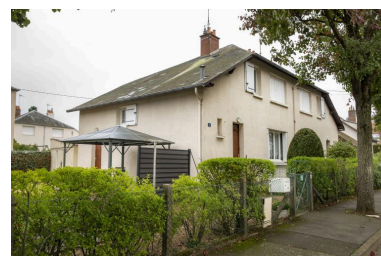
Vue de la façade sur rue d'un pavillon double rue du Cotentin. Phot. Pierre-Bernard Fourny IVR52_20197202568NUCA
