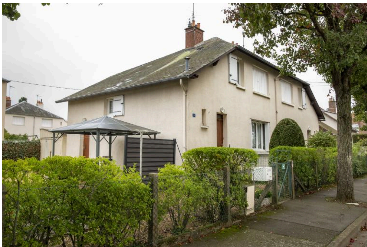
Vue de la façade sur rue d'un pavillon double rue du Cotentin.
