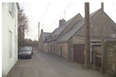
Vue générale de la rue de Bel Air.
