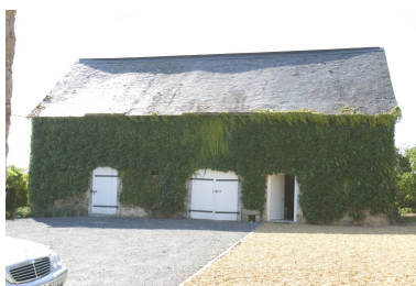
Ancienne ferme ouest : l'étable-grange. Phot. François Lasa IVR52_20045302485NUCA
