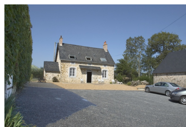
Vue d'ensemble de l'ancienne ferme est : l'étable- grange, le logis, la remise. Phot. François Lasa IVR52_20045302487NUCA
