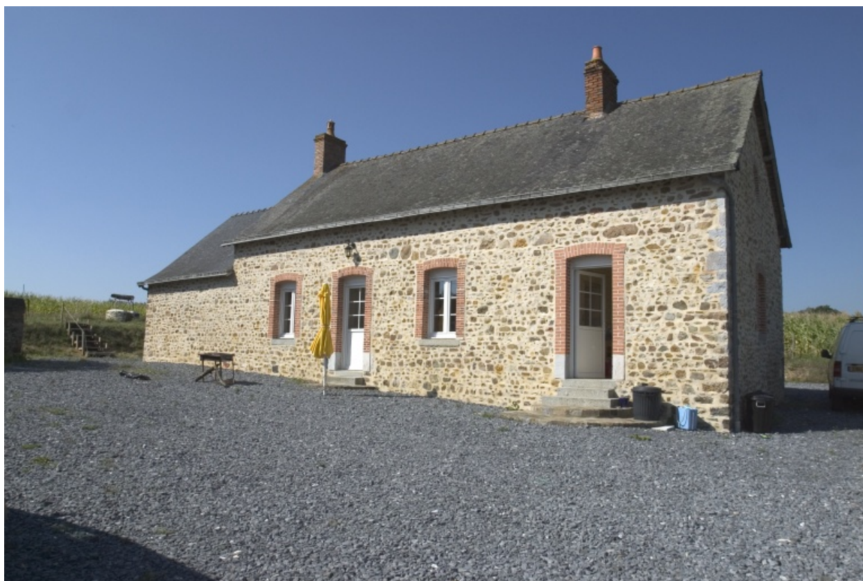
Ancienne ferme ouest : le logis.
