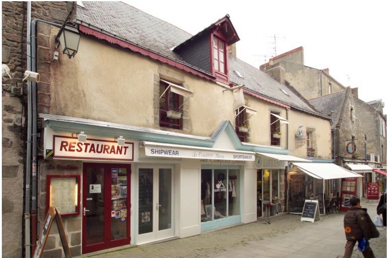
Vue de l'ensemble constitué par les n°5 et 7 rue Saint-Michel.
