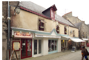
Vue de l'ensemble constitué par les n° 5 et 7 rue Saint-Michel. Phot. Denis Pillet IVR52_20074400388NUCA
