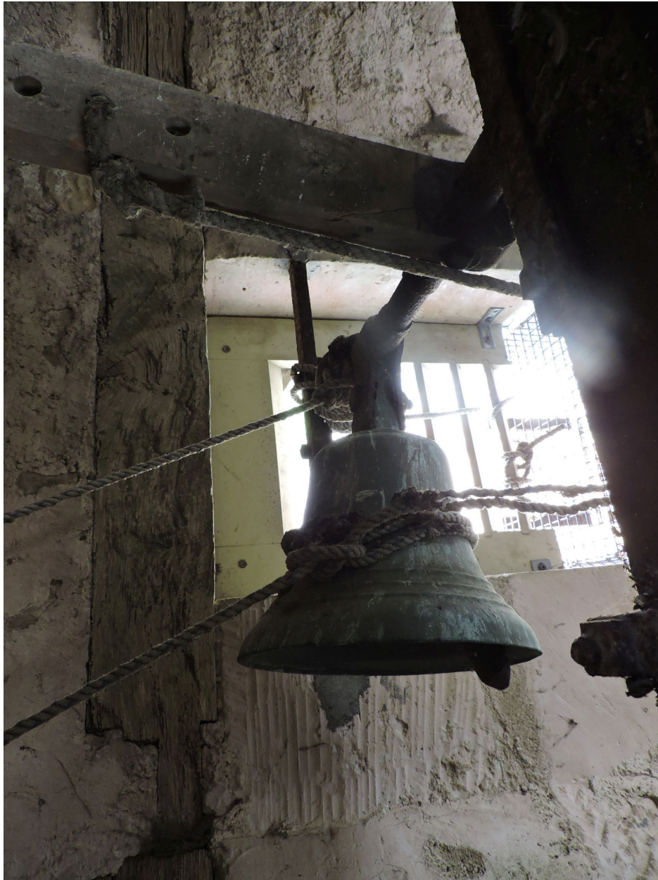
Cloche, vue d'ensemble.
