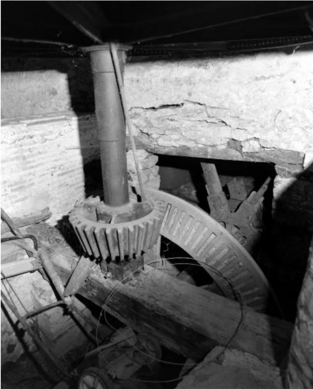
Détail de la transmission du vieux moulin : l'arbre moteur (relié à la roue hydraulique située à l'ouest de l'autre côté du mur), le rouet de fosse, l'axe vertical et son pignon.
