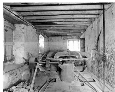
Rez-de-chaussée du nouveau moulin, partie ouest : mécanisme de transmission de la turbine.
