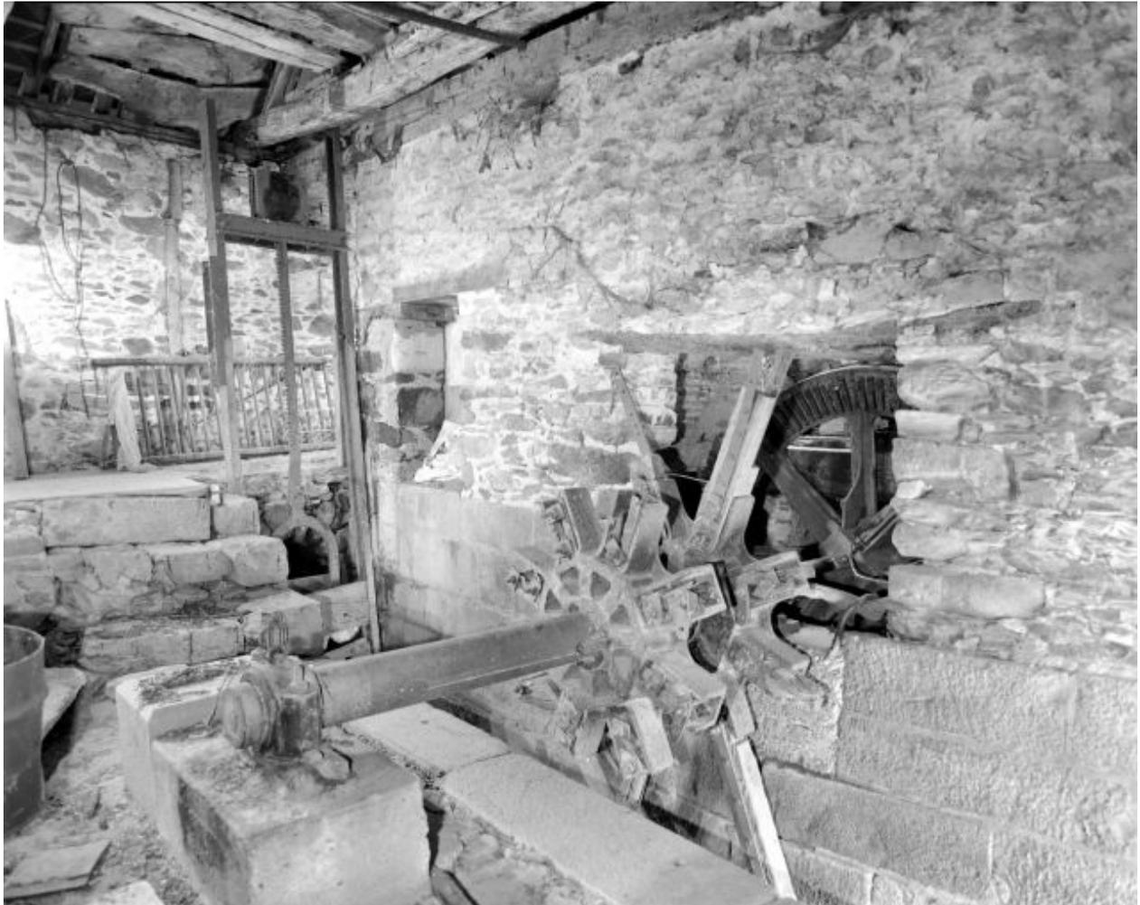
Rez-de-chaussée du vieux moulin, partie ouest : les vestiges de la roue, l'arbre moteur et la vanne d'amont du coursier vus du sud-ouest.
