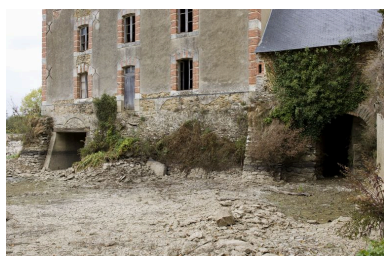
Vue partielle de la façade sud (aval) de l'ancien et du nouveau moulin, avec les sorties des coursiers, pendant les écourues de 2009. Phot. Yves Guillotin IVR52_20095300505NUCA
