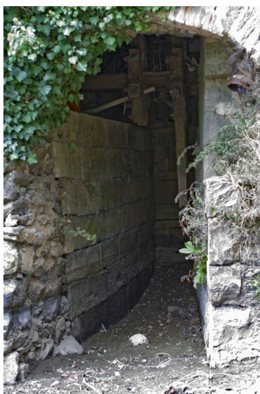
Vue de détail de la façade sud de l'ancien moulin, pendant les écourues de 2009 : la sortie du coursier. Phot. Yves Guillotin IVR52_20095300504NUCA
