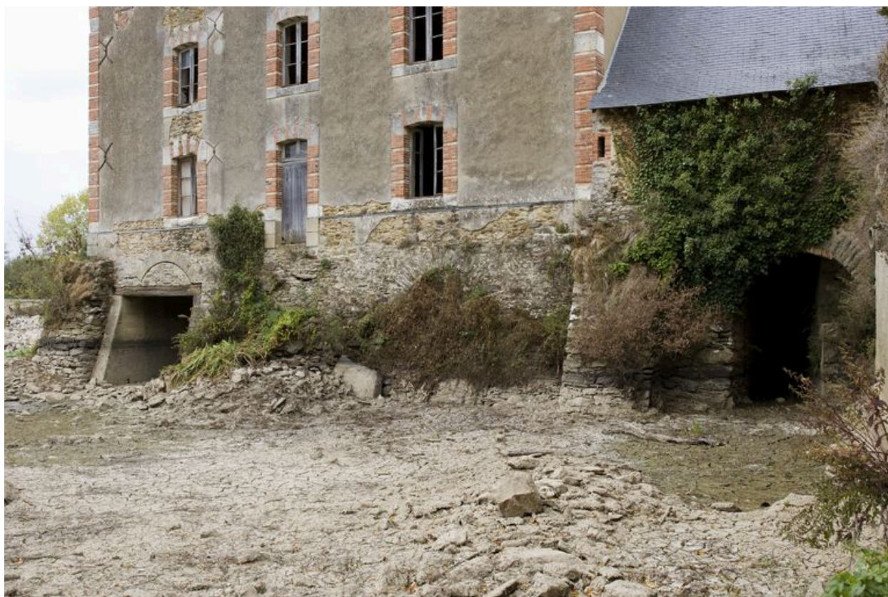
Vue partielle de la façade sud (aval) de l'ancien et du nouveau moulin, avec les sorties des coursiers, pendant les écourues de 2009.
