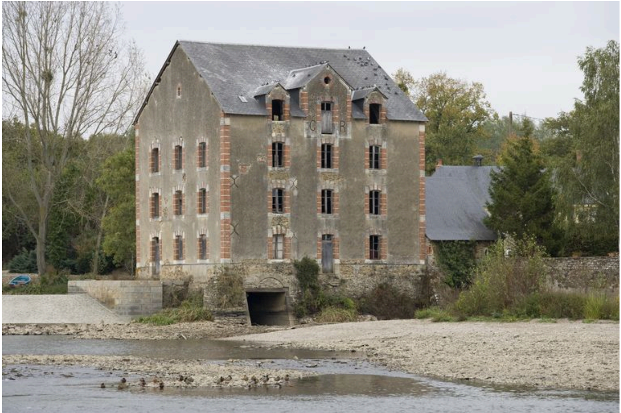
Les façades ouest et sud du nouveau moulin et la façade sud de l'ancien moulin, pendant les écourues de 2009.
