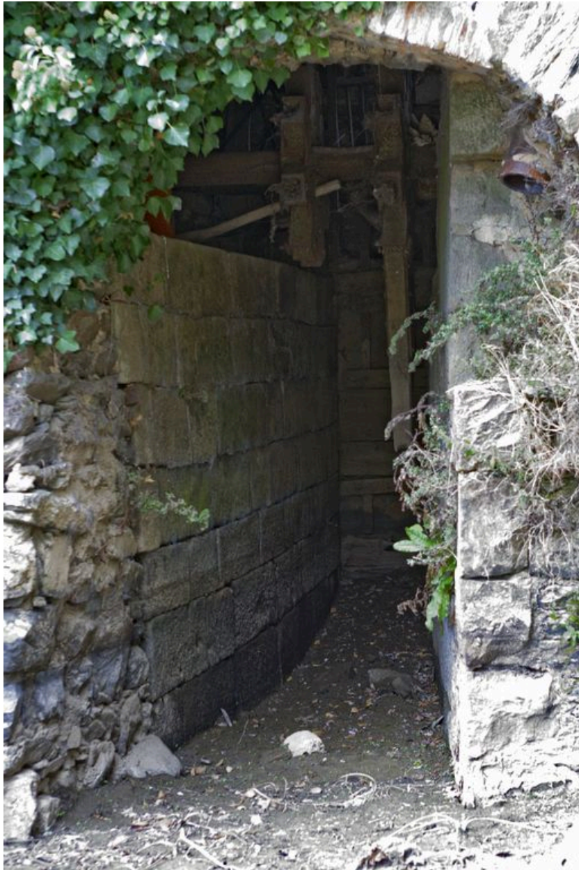
Vue de détail de la façade sud de l'ancien moulin, pendant les écourues de 2009 : la sortie du coursier.
