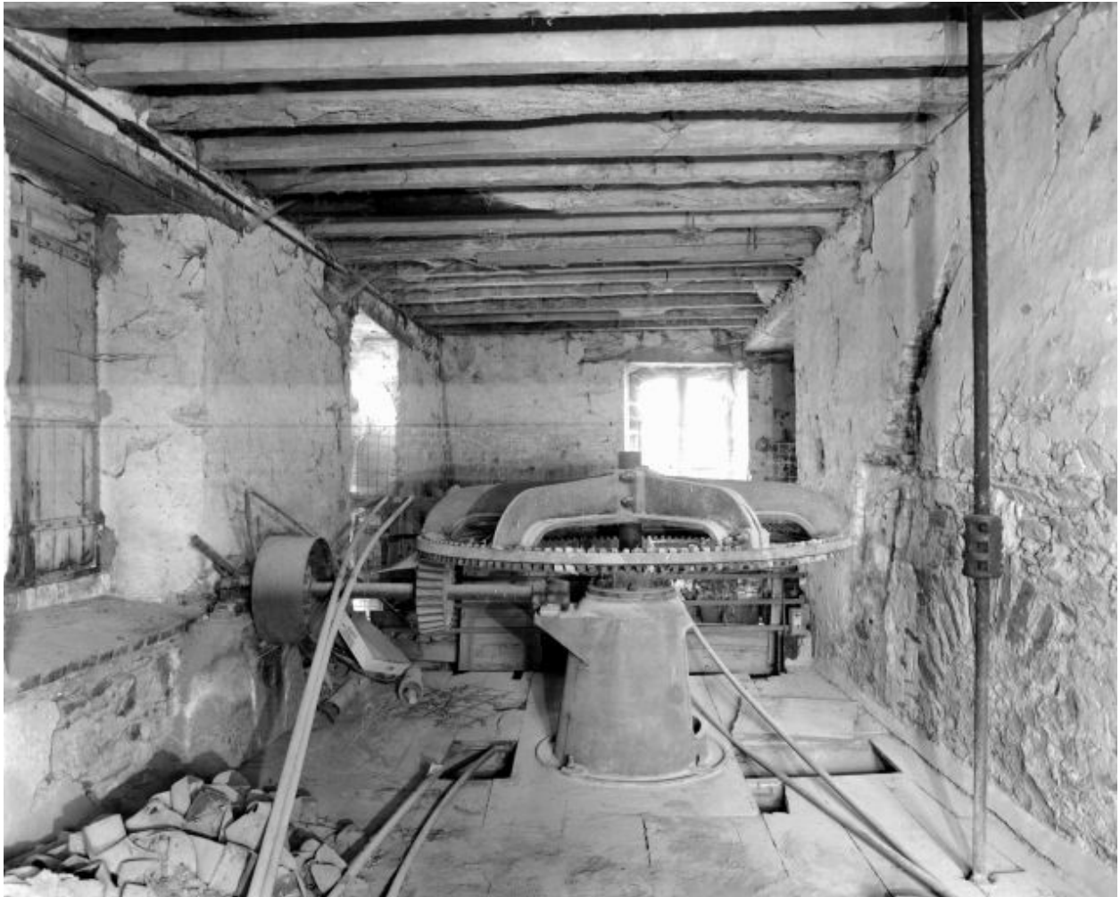
Rez-de-chaussée du nouveau moulin, partie ouest : mécanisme de transmission de la turbine.
