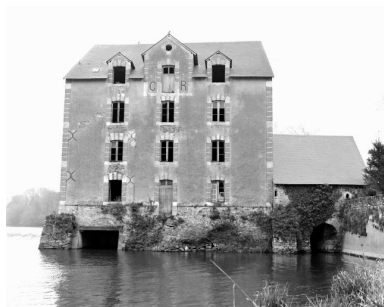
La façade sud (aval) du nouveau et de l'ancien moulin. Phot. François Lasa IVR52_20015300763X
