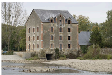
Les façades ouest et sud du nouveau moulin et la façade sud de l'ancien moulin, pendant les écourues de 2009. Phot. Yves Guillotin IVR52_20095300500NUCA
