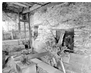
Rez-de-chaussée du vieux moulin, partie ouest : les vestiges de la roue, l'arbre moteur et la vanne d'amont du coursier vus du sud-ouest. Phot. François Lasa IVR52_20015300768X
