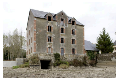
La façade sud (aval) du nouveau et de l'ancien moulin, pendant les écourues de 2009. Phot. Yves Guillotin IVR52_20095300506NUCA
