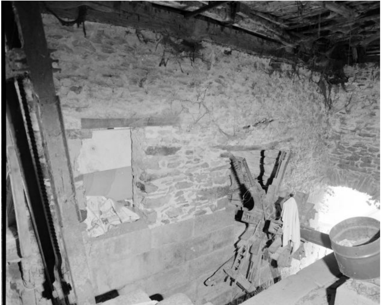
Rez-de-chaussée du vieux moulin, partie ouest : les vestiges de la roue et sa cage vus du nord-ouest.
