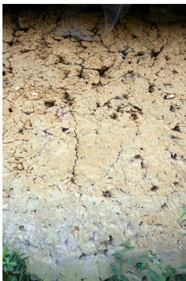
Fournil, élévation postérieure : détail du mur en bauge. Phot. François Lasa IVR52_20077200769NUCA
