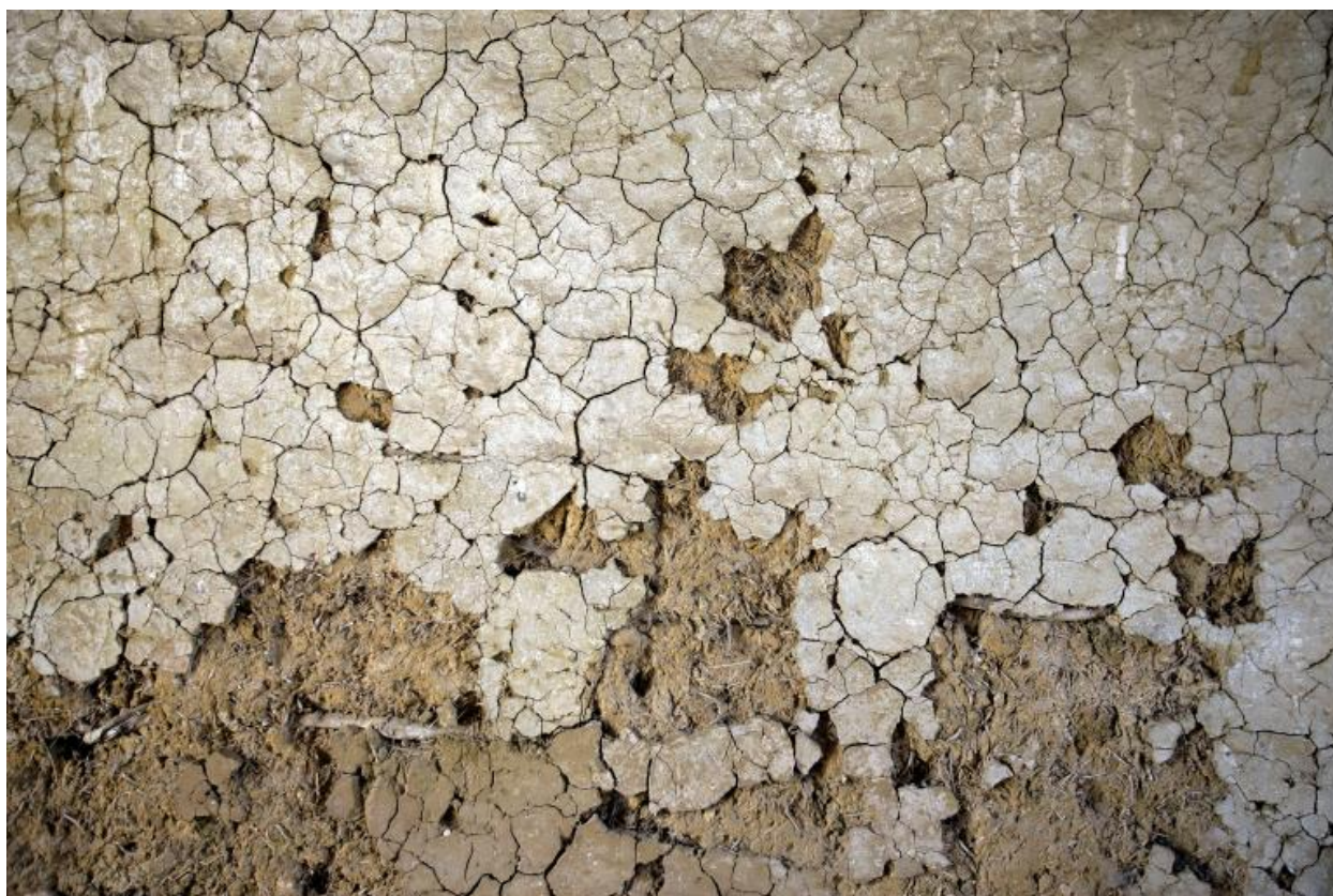
Logis, mur pignon droit : hourdis en torchis avec enduit.
