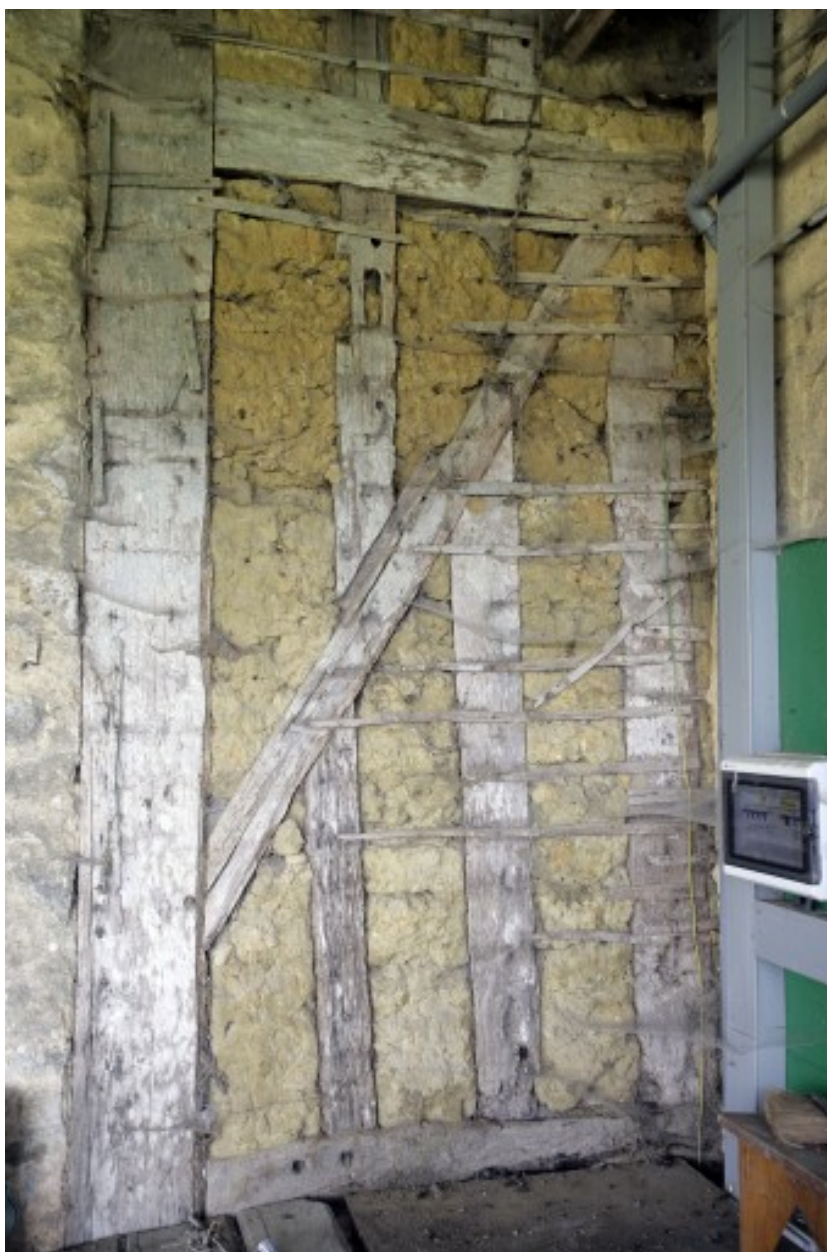
Logis, élévation postérieure : détail.
