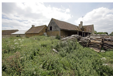
Logis et fournil, élévations postérieures vues depuis le nord. Phot. François Lasa IVR52_20077200764NUCA
