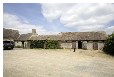
Fournil - porcherie - étables : élévations sur cour. Phot. François Lasa IVR52_20077200763NUCA
