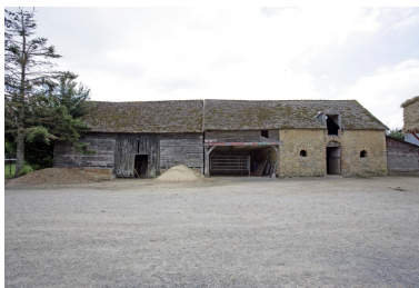
Écurie - charretterie - remise : élévations sur cour. Phot. François Lasa IVR52_20077200770NUCA
