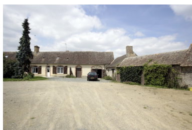
Logis et fournil-porcherie- étables : élévations sur cour. Phot. François Lasa IVR52_20077200762NUCA
