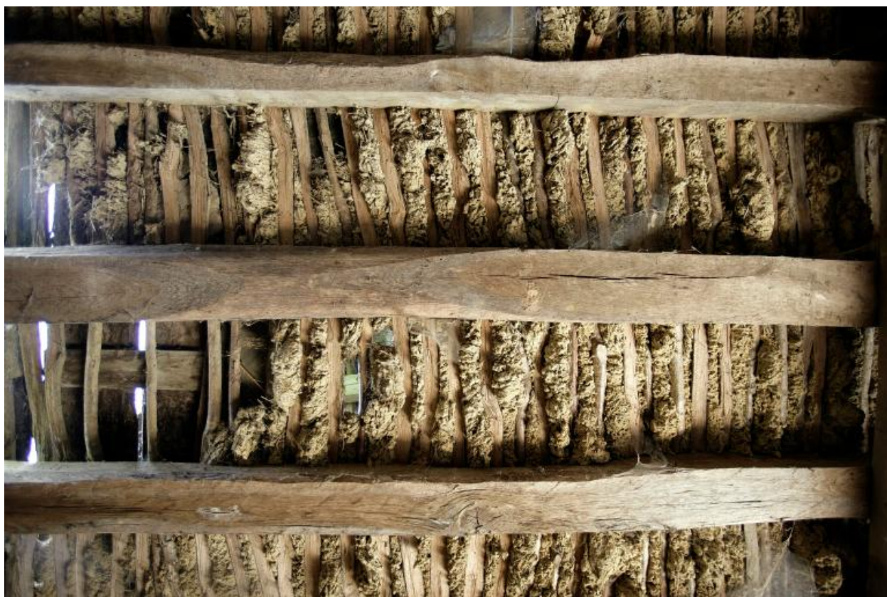
Logis, remise : détail du plafond.
