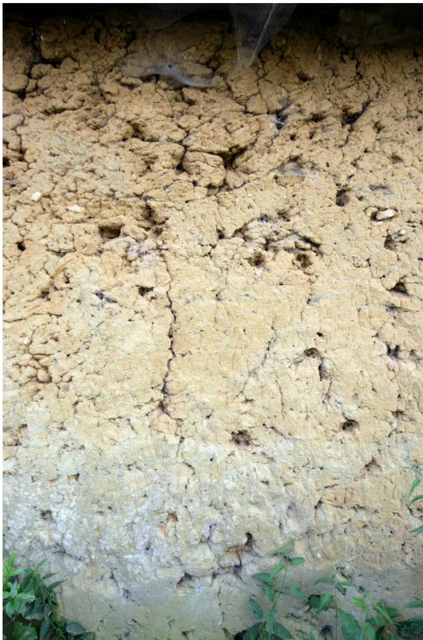
Fournil, élévation postérieure : détail du mur en bauge.
