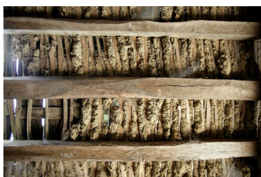
Logis, remise : détail du plafond. Phot. François Lasa IVR52_20077200768NUCA
