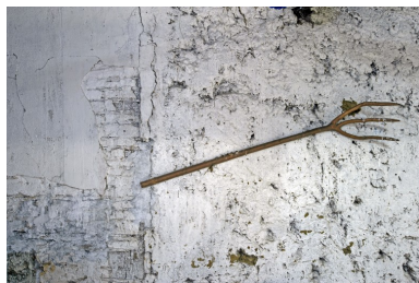
Fournil, intérieur : liaison entre le mur en bauge et le mur en pan de bois du logis. Phot. François Lasa IVR52_20077200772NUCA
