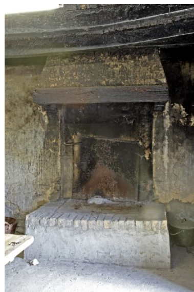
Fournil, cheminée. Phot. François Lasa IVR52_20077200771NUCA
