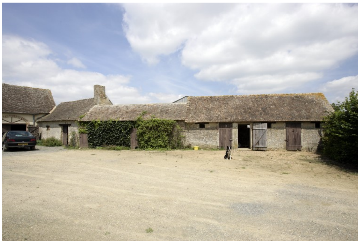
Fournil - porcheries - étables : élévations sur cour.
