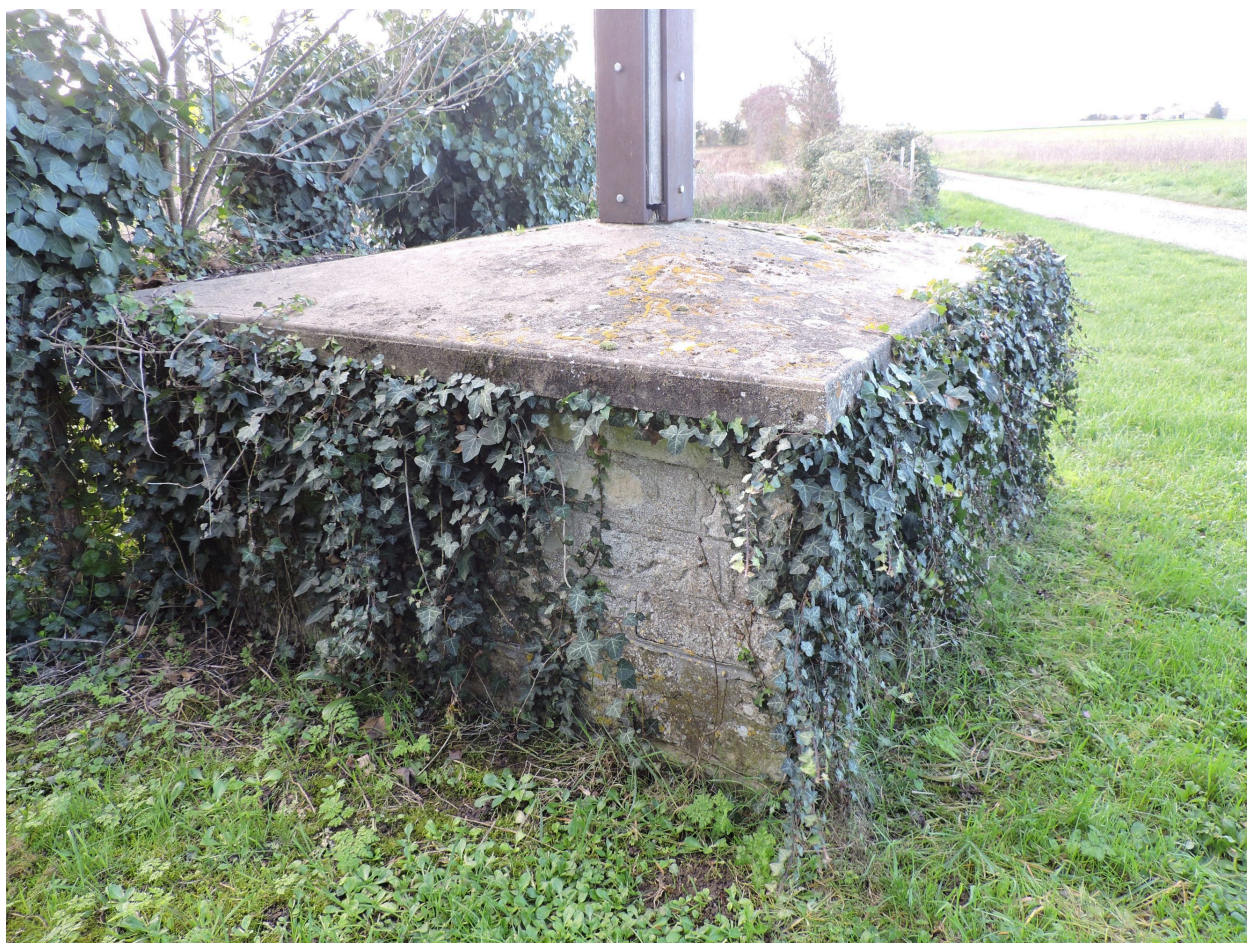
Le socle vu depuis le nord-est.
