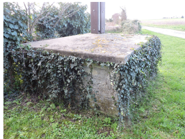
Le socle vu depuis le nord-est. Phot. Yannis Suire IVR52_20218500866NUCA
