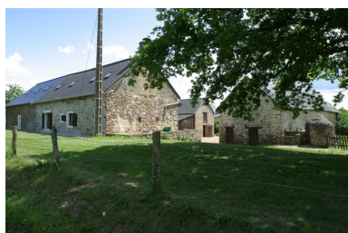
Vue d'ensemble depuis le chemin au nord. Phot. François Lasa IVR52_20035301751NUCA
