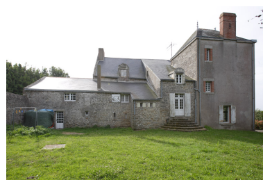
Logis. Vue de la façade postérieure. Phot. Denis Pillet IVR52_20084402079NUCA
