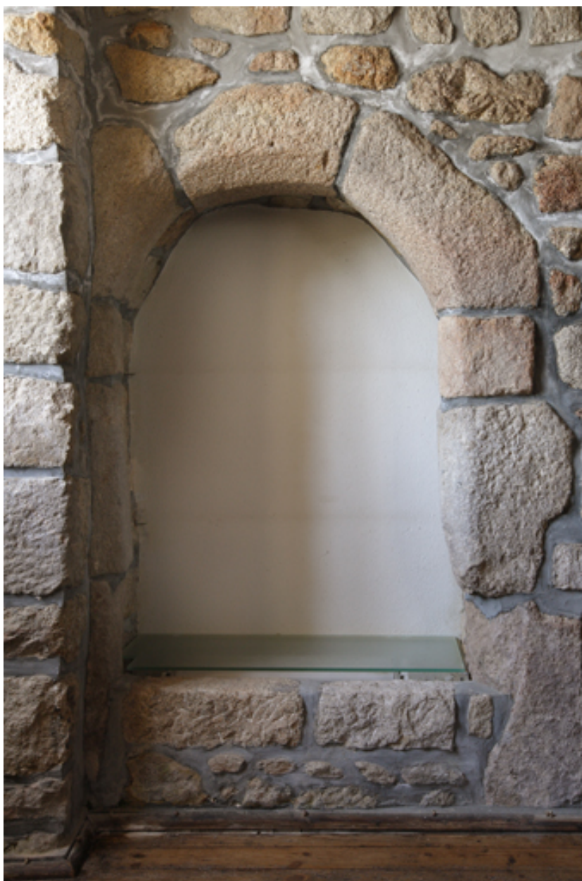
Logis. Rez-de-chaussée. Salle sud. Détail de la niche murale.
