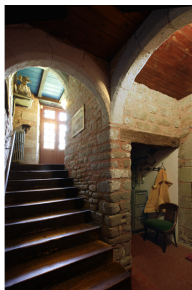
Logis. Rez-de-chaussée. Détail de l'escalier rampe-sur-rampe. Phot. Denis Pillet IVR52_20084401560NUCA
