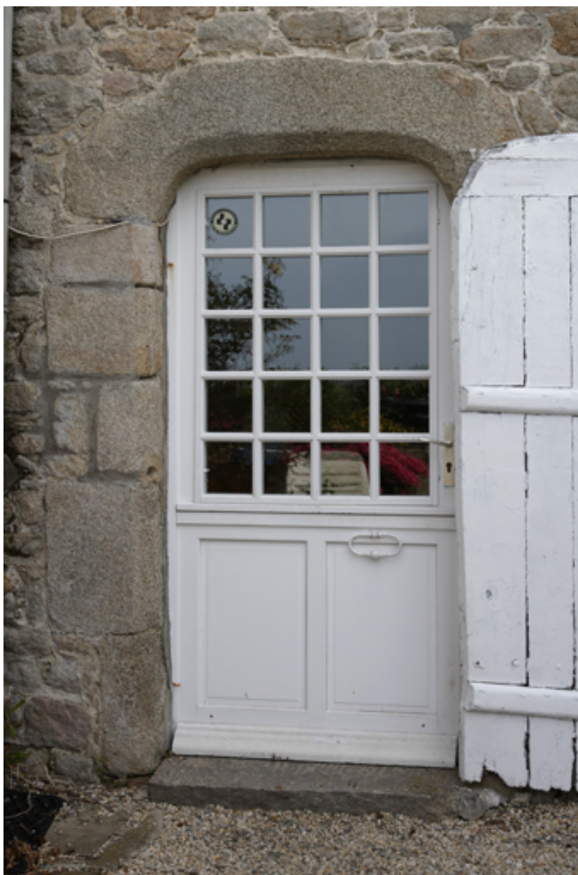
Logis. Pignon sud. Détail de la porte.
