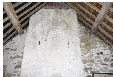
Logis. Comble. Négatif de l'ancienne pente de toit sur la cheminée nord. Phot. Denis Pillet IVR52_20084402097NUCA
