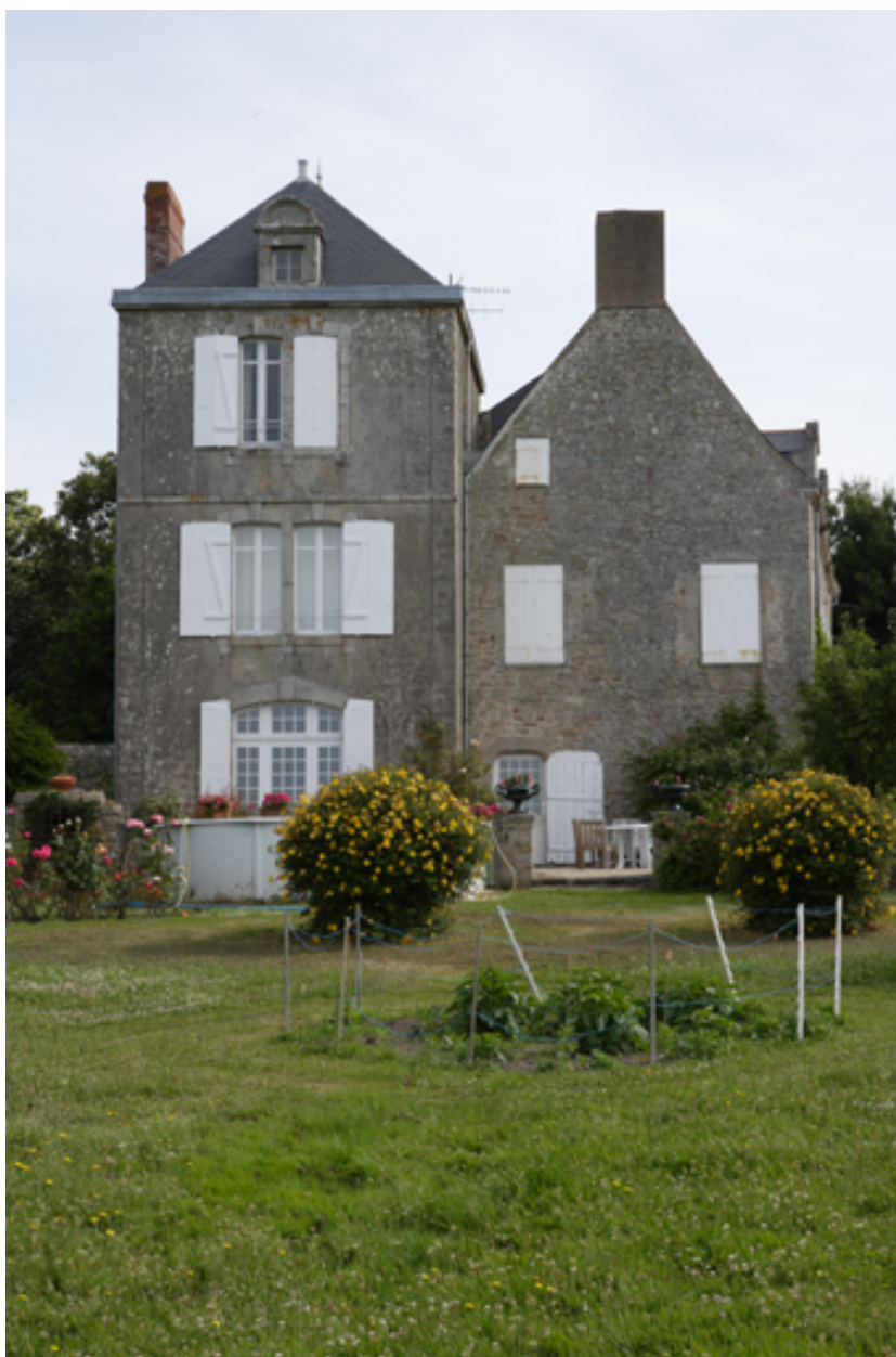
Logis. Vue du pignon sud et du pavillon.
