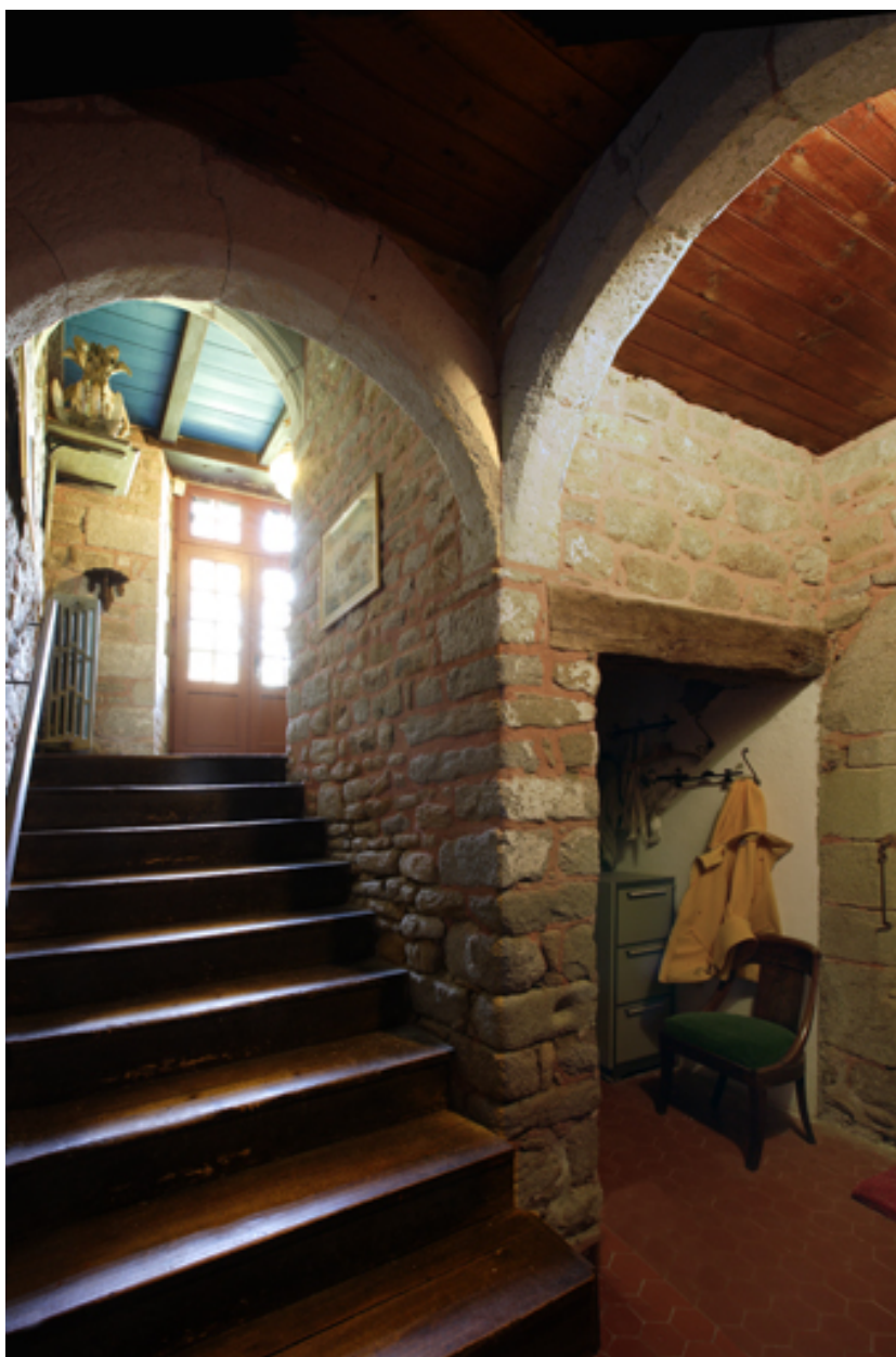
Logis. Rez-de-chaussée. Détail de l'escalier rampe-sur-rampe.
