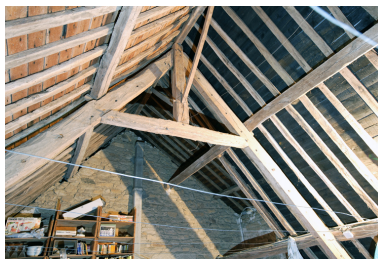
Logis. Comble. Vue de la charpente. Phot. Denis Pillet IVR52_20084401571NUCA
