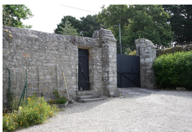
Cour. Détail des portes charretière et piétonnière. Phot. Denis Pillet IVR52_20084402095NUCA
