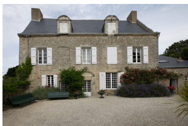
Logis. Vue de la façade antérieure. Phot. Denis Pillet IVR52_20084402076NUCA
