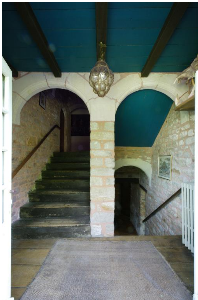
Logis. Cage d'escalier. Vue du premier repos.
