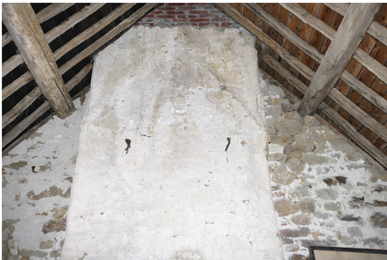
Logis. Comble. Négatif de l'ancienne pente de toit sur la cheminée nord.
