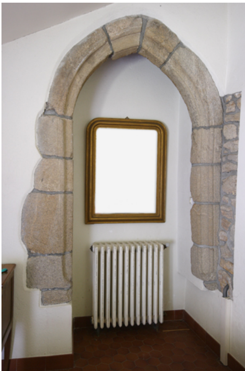
Logis. Premier étage. Détail de la baie en arc brisé sur le mur nord de la chambre nord-ouest.
