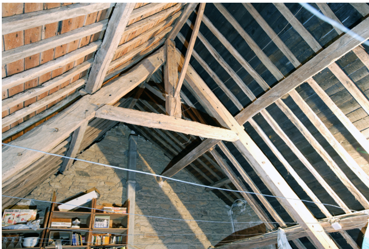
Logis. Comble. Vue de la charpente.
