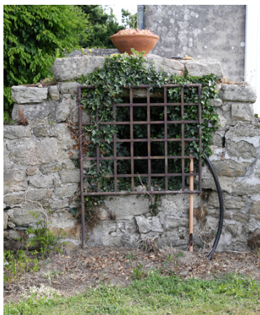
Jardin. Détail du puits. Phot. Denis Pillet IVR52_20084402093NUCA
