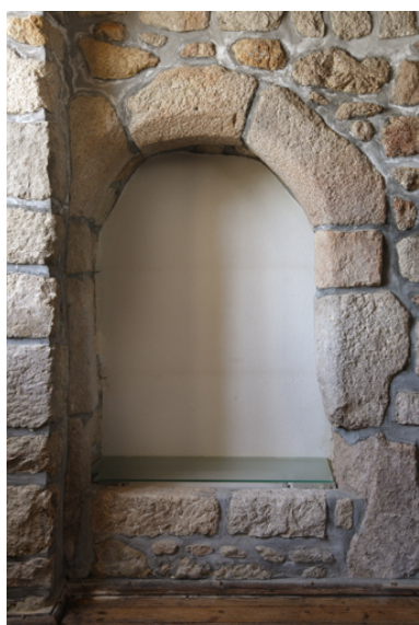
Logis. Rez-de-chaussée. Salle sud. Détail de la niche murale. Phot. Denis Pillet IVR52_20084401563NUCA
