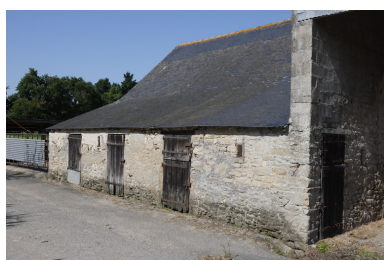
Vue de la porcherie. Phot. Denis Pillet IVR52_20084401821NUCA
