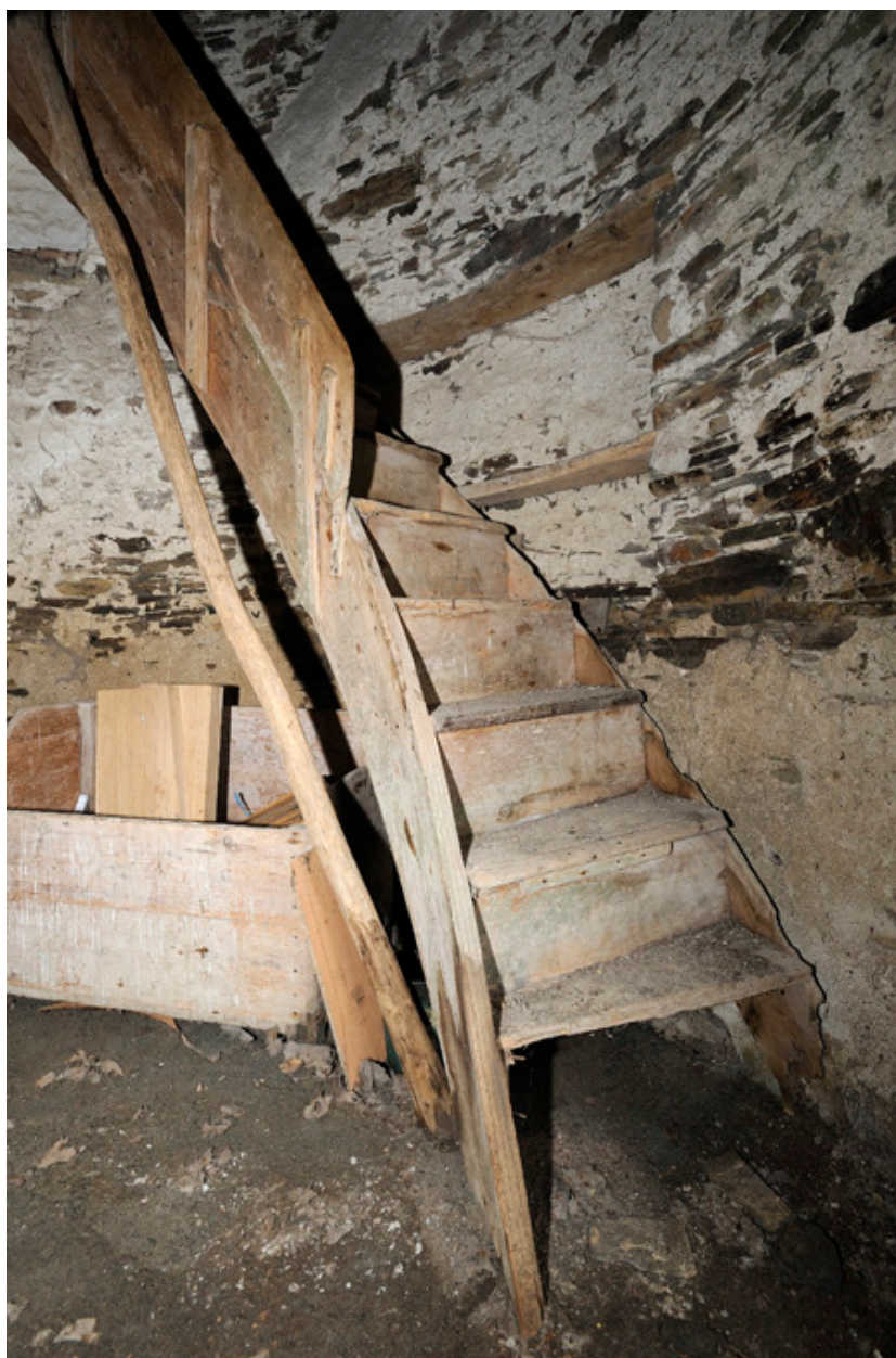
Escalier en bois permettant d'accéder au deuxième étage.
