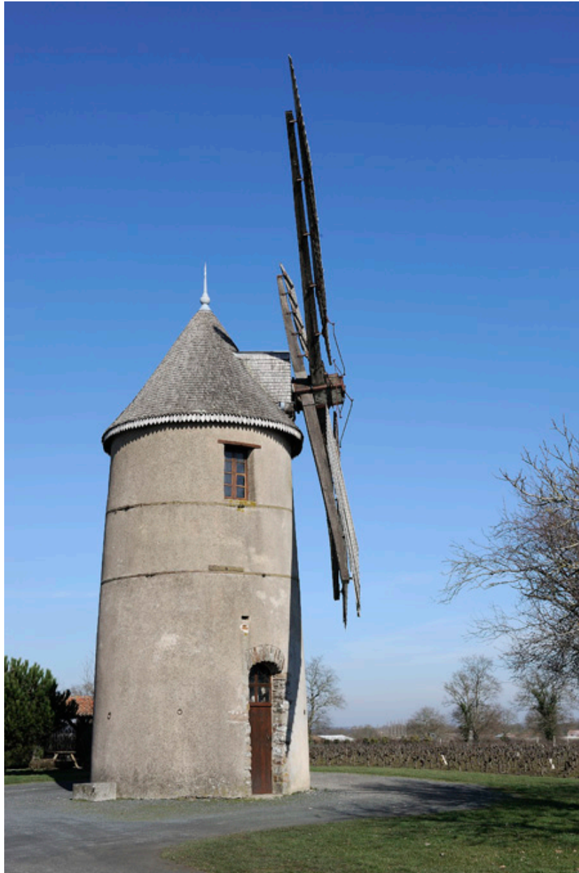
Le moulin Guillou, façade sud-ouest.
