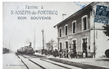
Gare de Saint-Joseph-de Porterie. Phot. Denis Pillet IVR52_20104402374NUCA
