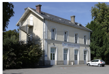
Gare de Sucé-sur-Erdre. Phot. Denis Pillet IVR52_20104402236NUCA
