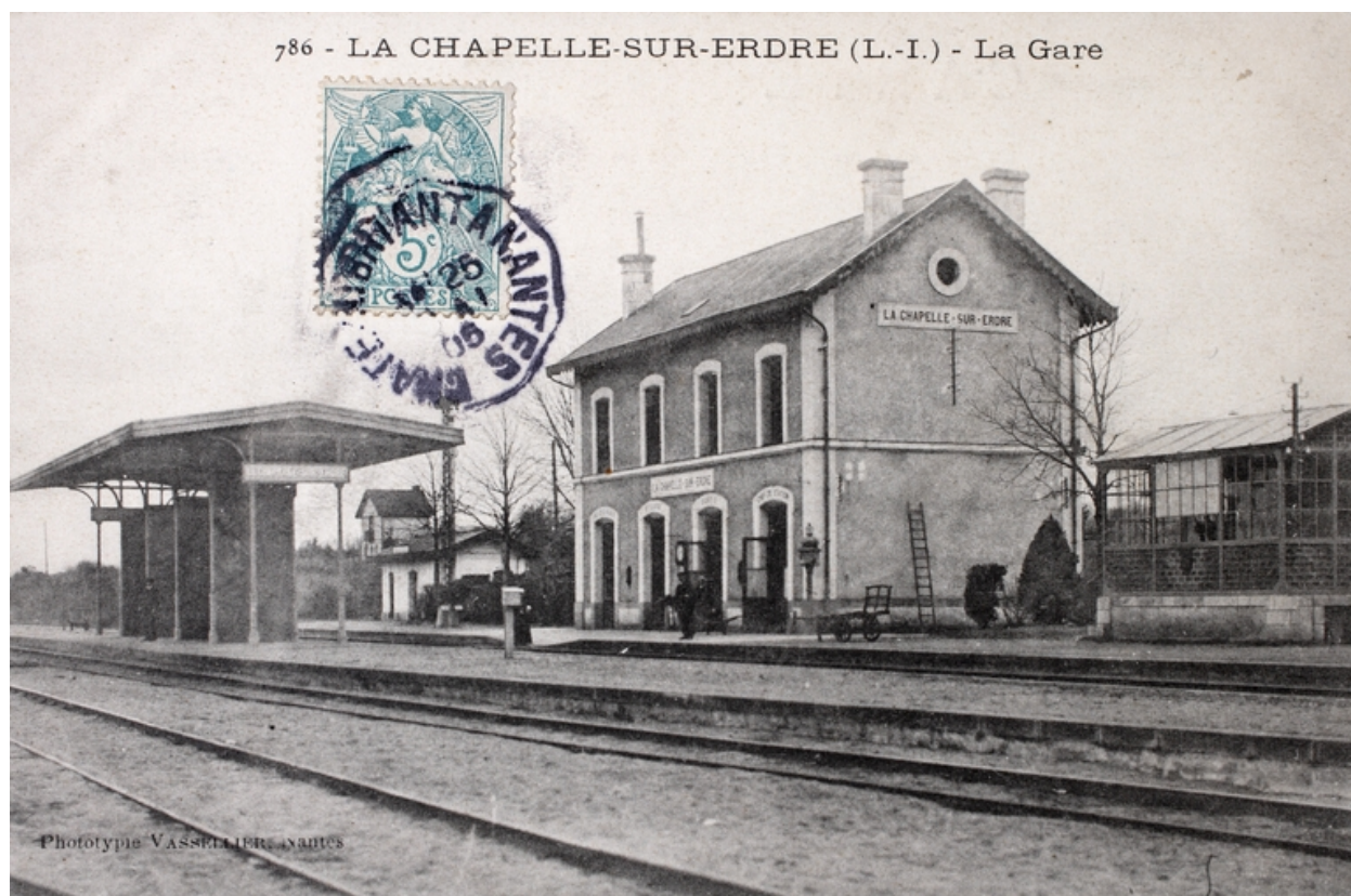
Gare de La Chapelle-sur-Erdre.
