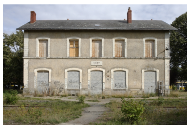
Gare de Nort-sur-Erdre. Phot. Denis Pillet IVR52_20104402176NUCA
