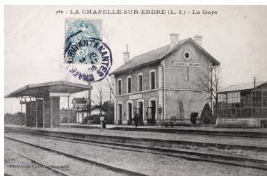
Gare de La Chapelle-sur-Erdre. Phot. Denis Pillet IVR52_20104402319NUCA
