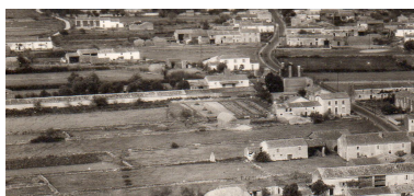
La ferme et le puits, en bas, sur une vue aérienne vers 1950. Phot. Yannis (reproduction) Suire IVR52_20198502393NUCA
