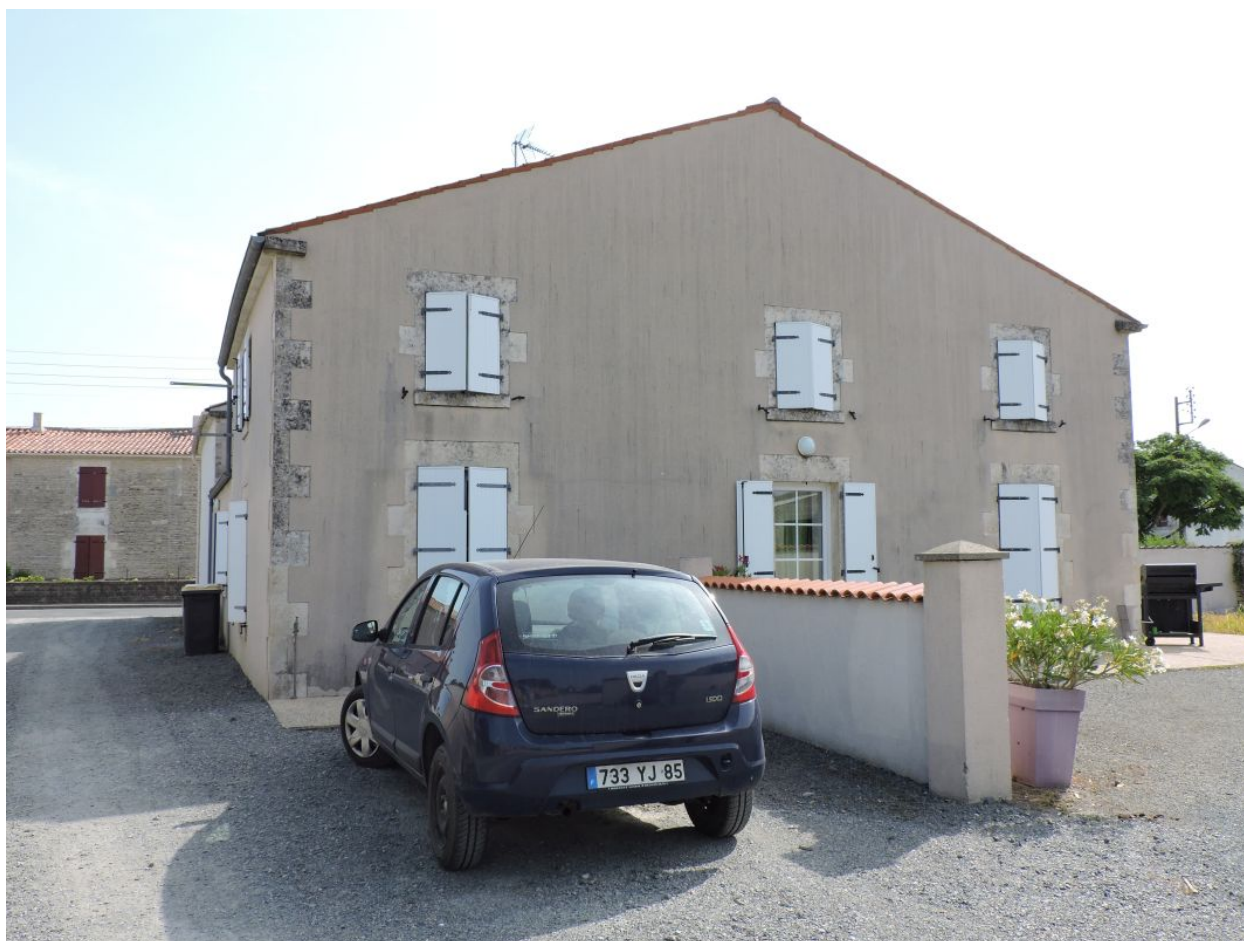
Le logis vu depuis le sud-ouest.
