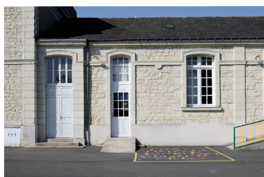
Ecole, façade est : module d'une classe Phot. Bruno Rousseau, Phot. Youenn Communeau
