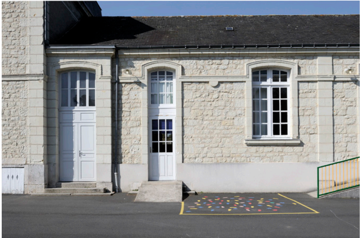
Ecole, façade est : module d'une classe
