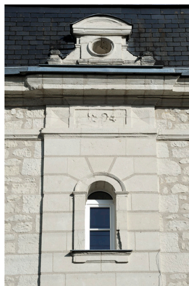
Maison de la directrice : haut de la travée axiale Phot. Bruno Rousseau, Phot. Youenn Communeau IVR52_20114900675NUCA
