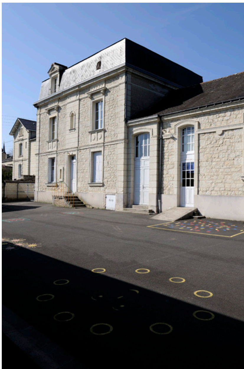
Maison de la directrice, vue depuis la cour
