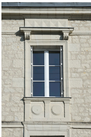
Maison de la directrice : baie de l'étage Phot. Bruno Rousseau, Phot. Youenn Communeau IVR52_20114900674NUCA
