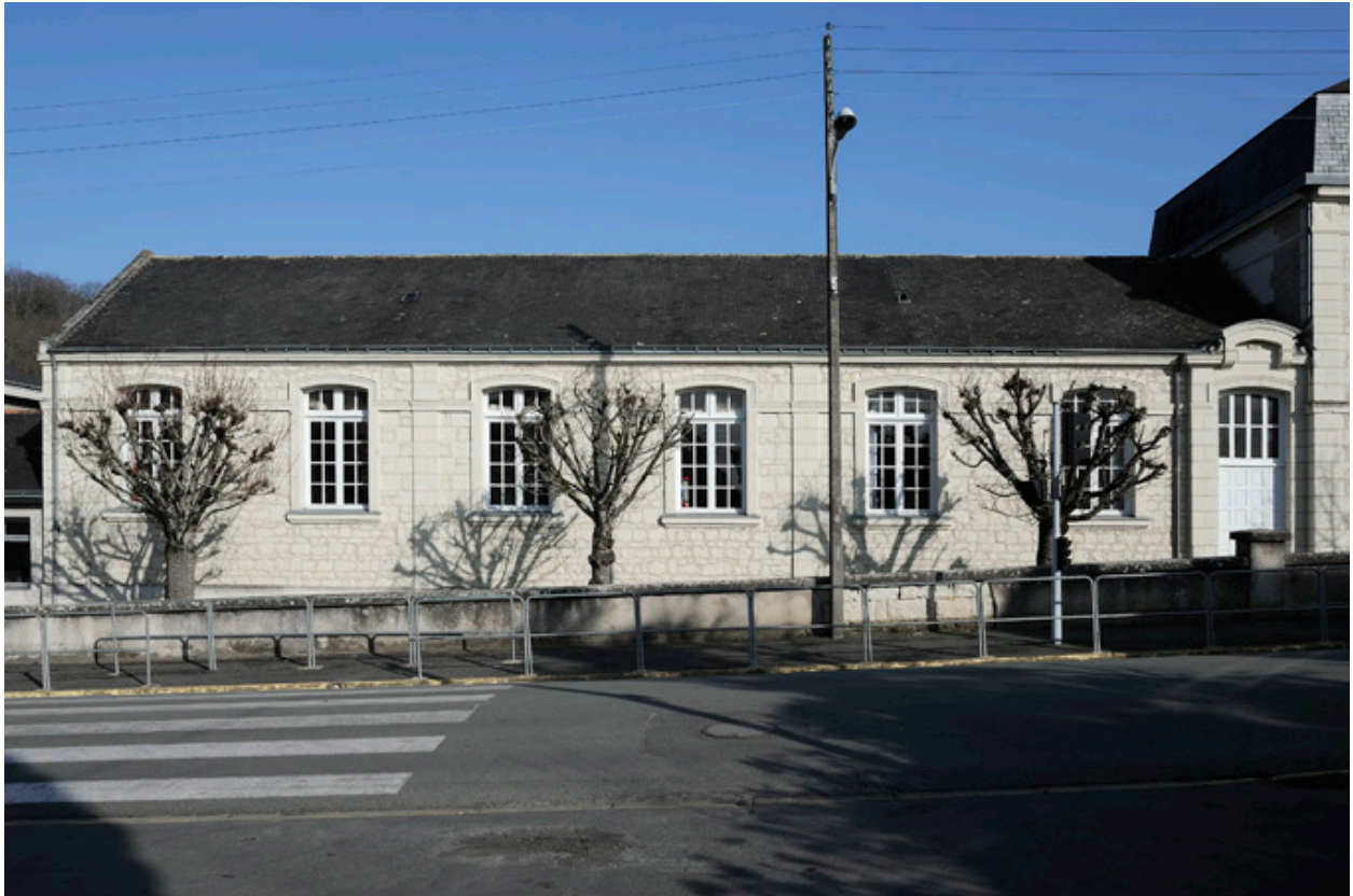
Ecole, façade ouest
