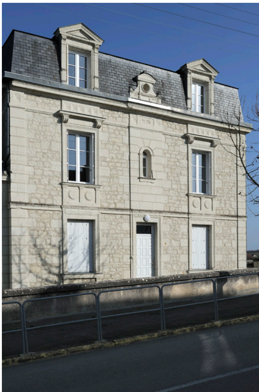
Maison de la directrice : façade principale
