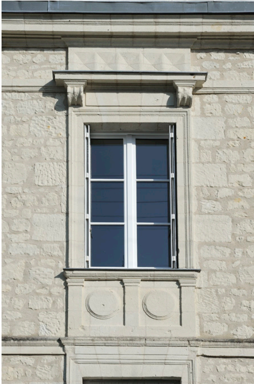
Maison de la directrice : baie de l'étage
