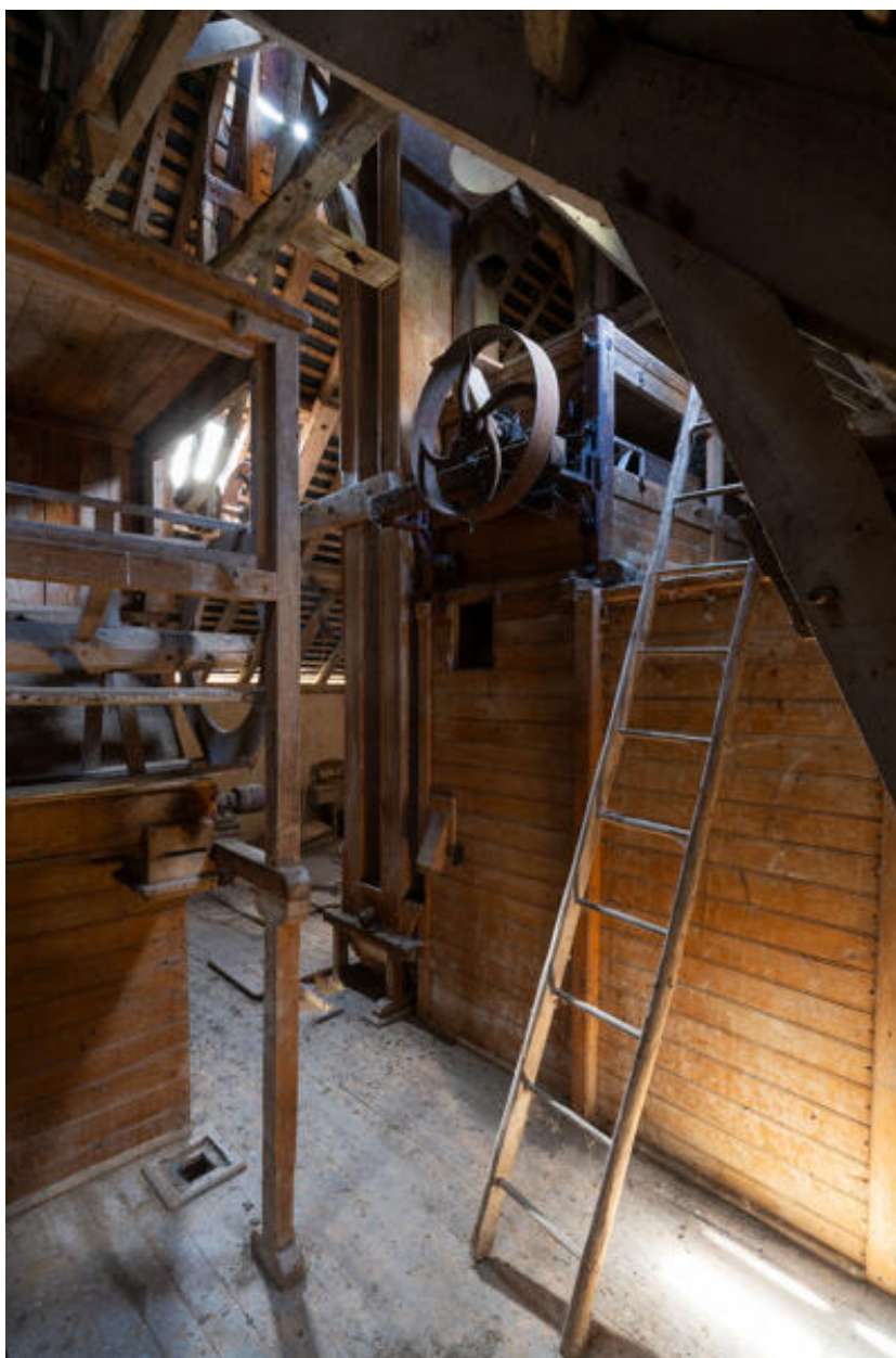
Machines du moulin : comble.
