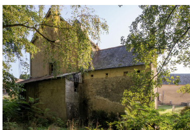
Logis, aile abritant les machines et cage de la roue, vue depuis l'ouest. Phot. Jeanne Minier IVR52_20257200678NUCA
