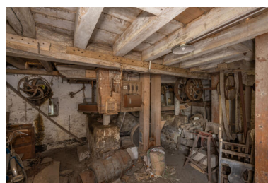
Machines du moulin : rez-de-chaussée. Phot. Jeanne Minier IVR52_20257200691NUCA
