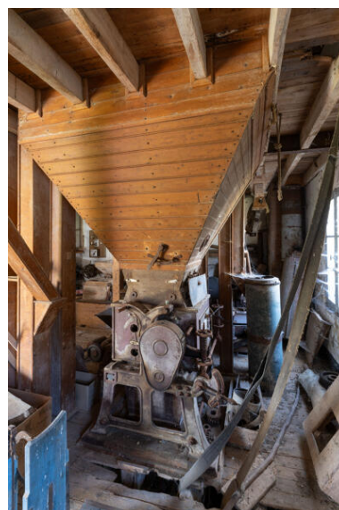
Machines du moulin, premier étage : broyeur. Phot. Jeanne Minier IVR52_20257200687NUCA
