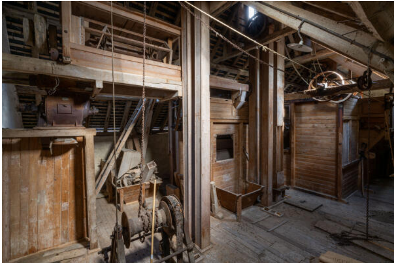
Machines du moulin : comble.
