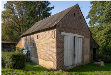
Remise. Phot. Jeanne Minier IVR52_20257200676NUCA
