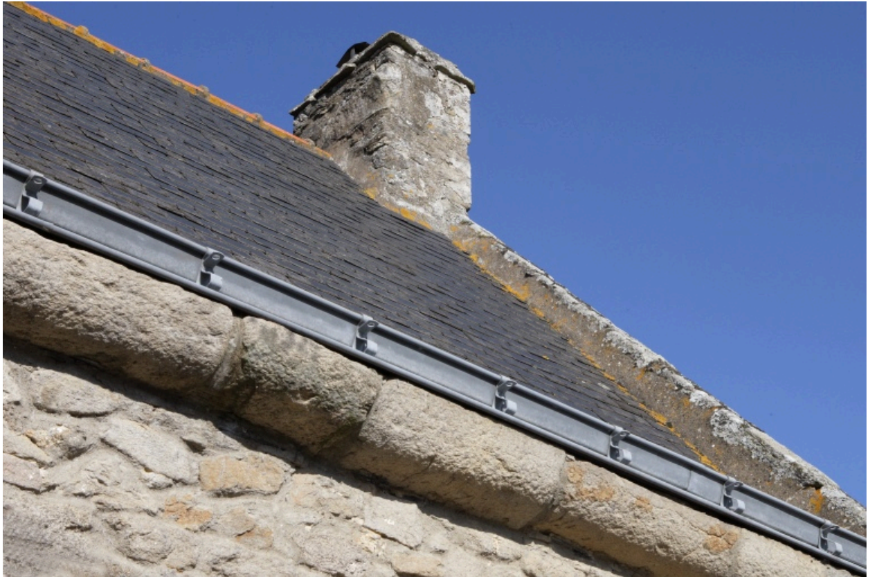
Détail de la corniche en quart-de-rond (7 rue Folie).
