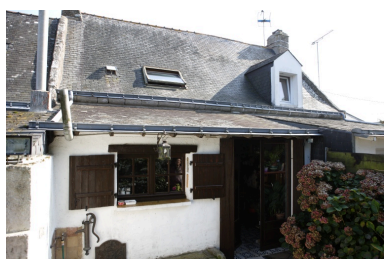
Vue de la façade arrière du n° 7 rue Folie. Phot. Denis Pillet IVR52_20074401349NUCA
