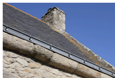
Détail de la corniche en quart-de-rond (7 rue Folie). Phot. Denis Pillet IVR52_20074401321NUCA
