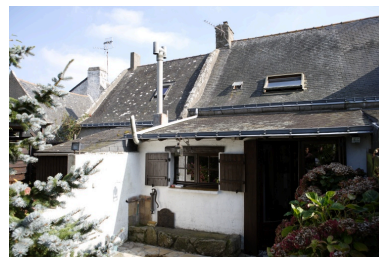
Vue de la façade arrière de la rangée. Phot. Denis Pillet IVR52_20074401348NUCA
