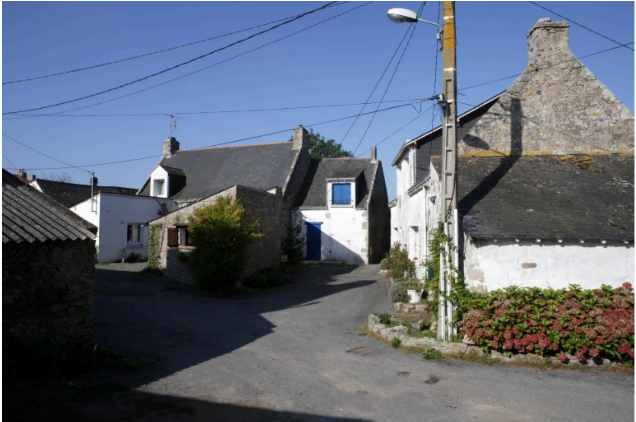
Vue d'ensemble de la rangée depuis l'est.
