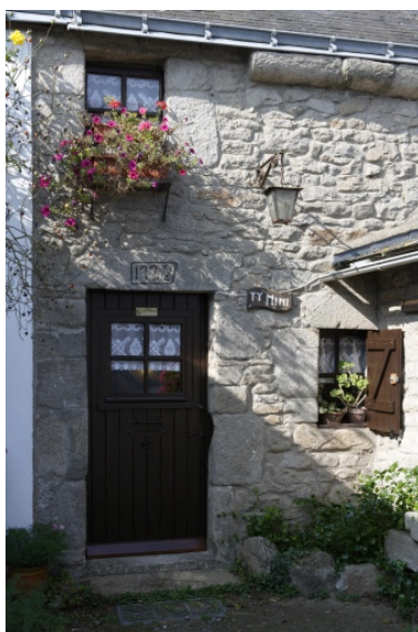
Détail de la façade sur rue du n° 7 rue Folie et de la porte datée 1732. Phot. Denis Pillet IVR52_20074401345NUCA
