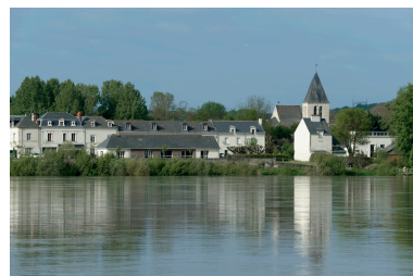
L'extension occidentale du bourg de Montsoreau, le long de la route de Loire et l'église Saint-Pierre de Rest. Phot. Bruno Rousseau IVR52_20134900567NUCA
