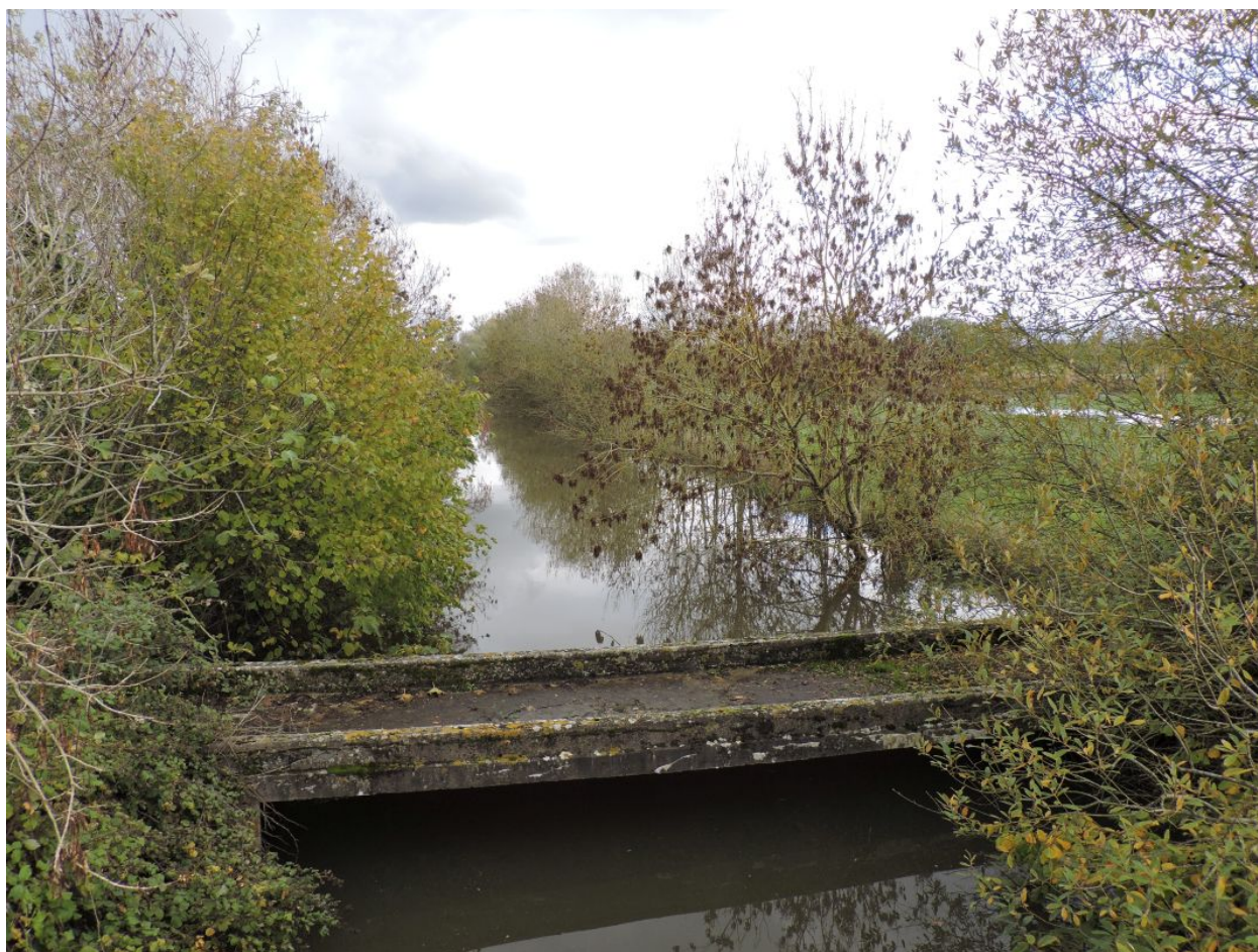
Ancienne passerelle en amont des ponds, sur le Contrebot de Vix.
