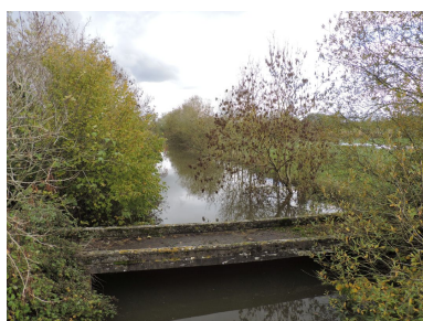
Ancienne passerelle en amont des ponts, sur le Contrabot de Vix. Phot. Yannis Suire IVR52_20198503184NUCA
