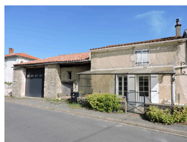
L'ancien logement, à droite, et les dépendances qui le prolongent. Phot. Yannis Suire IVR52_20198503285NUCA
