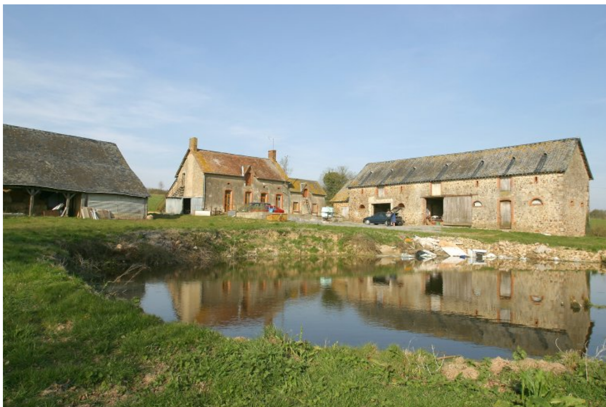
La ferme. Vue d'ensemble depuis le sud-ouest.
