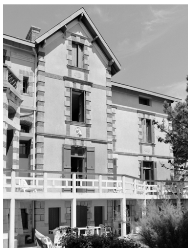
Elévation face à la mer, côté est. Phot. Denis Pillet
