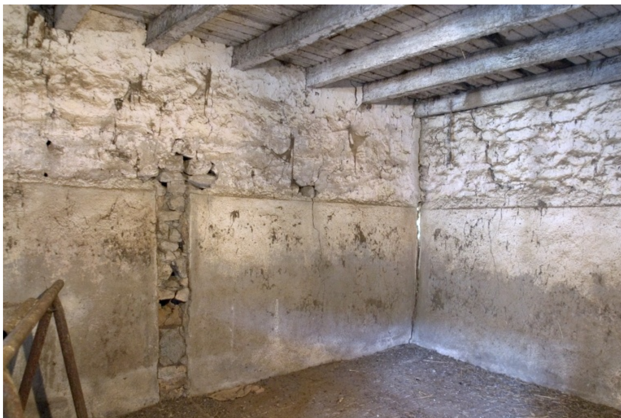
Rez-de-chaussée de l'ancienne "grange" : murs sud et ouest.
