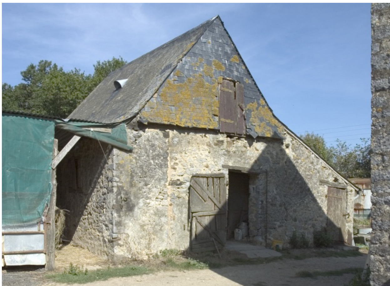
L'ancienne "grange" vue depuis le sud-est.
