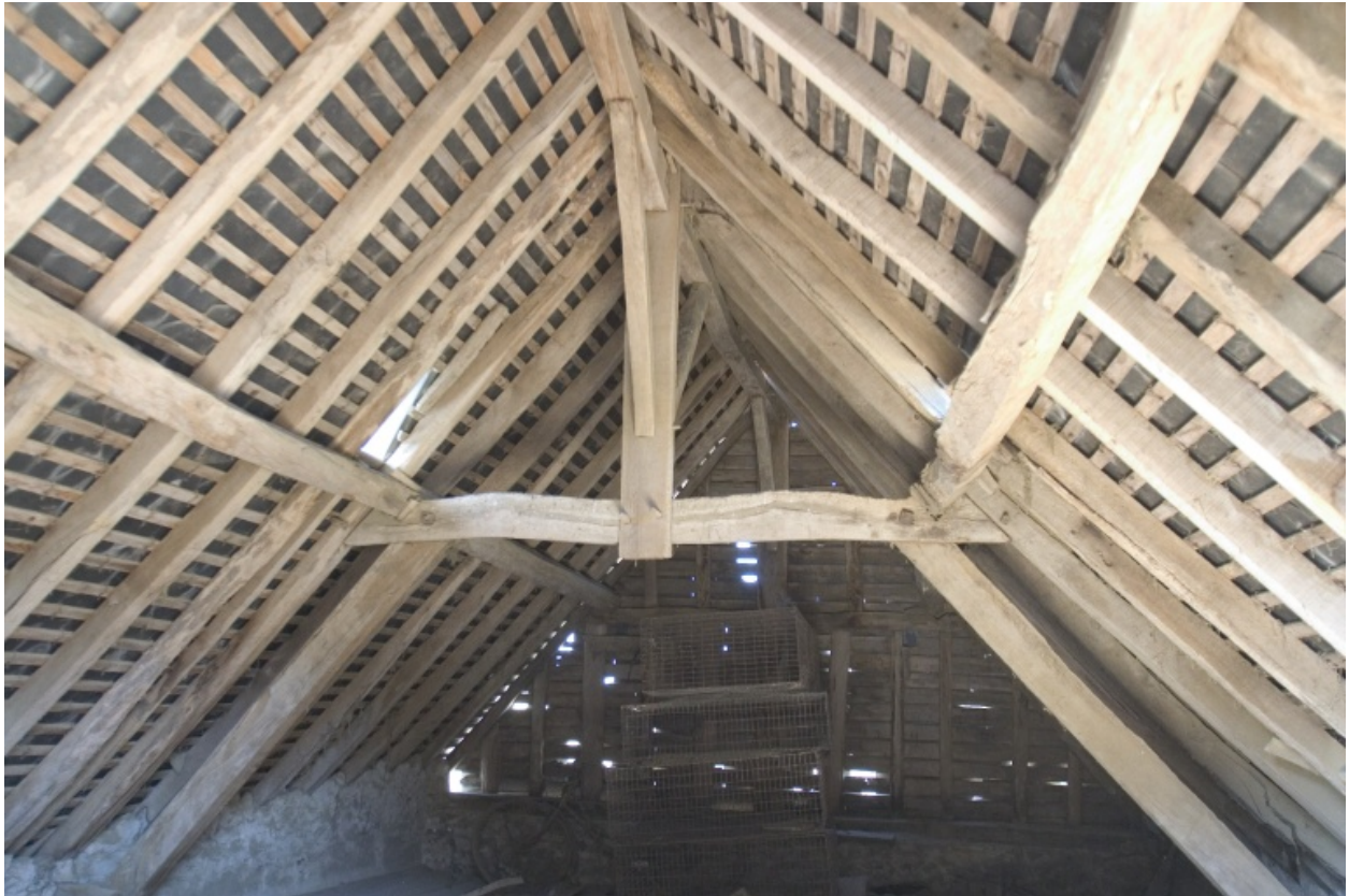
La charpente de l'ancienne "grange".
