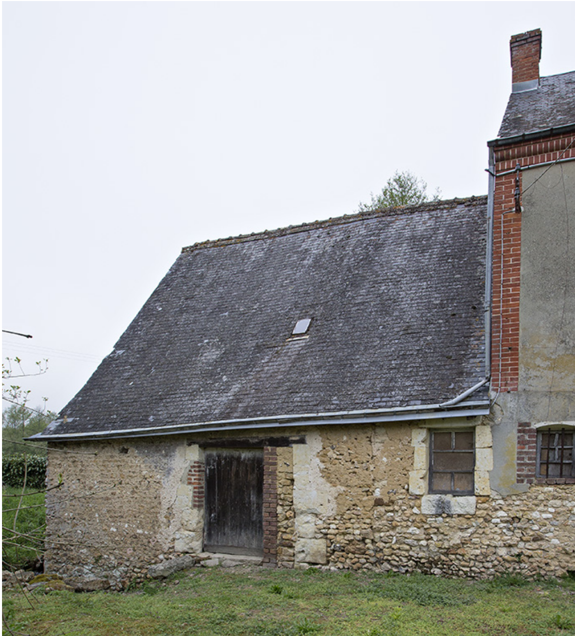
La meunerie, façade sur cour.
