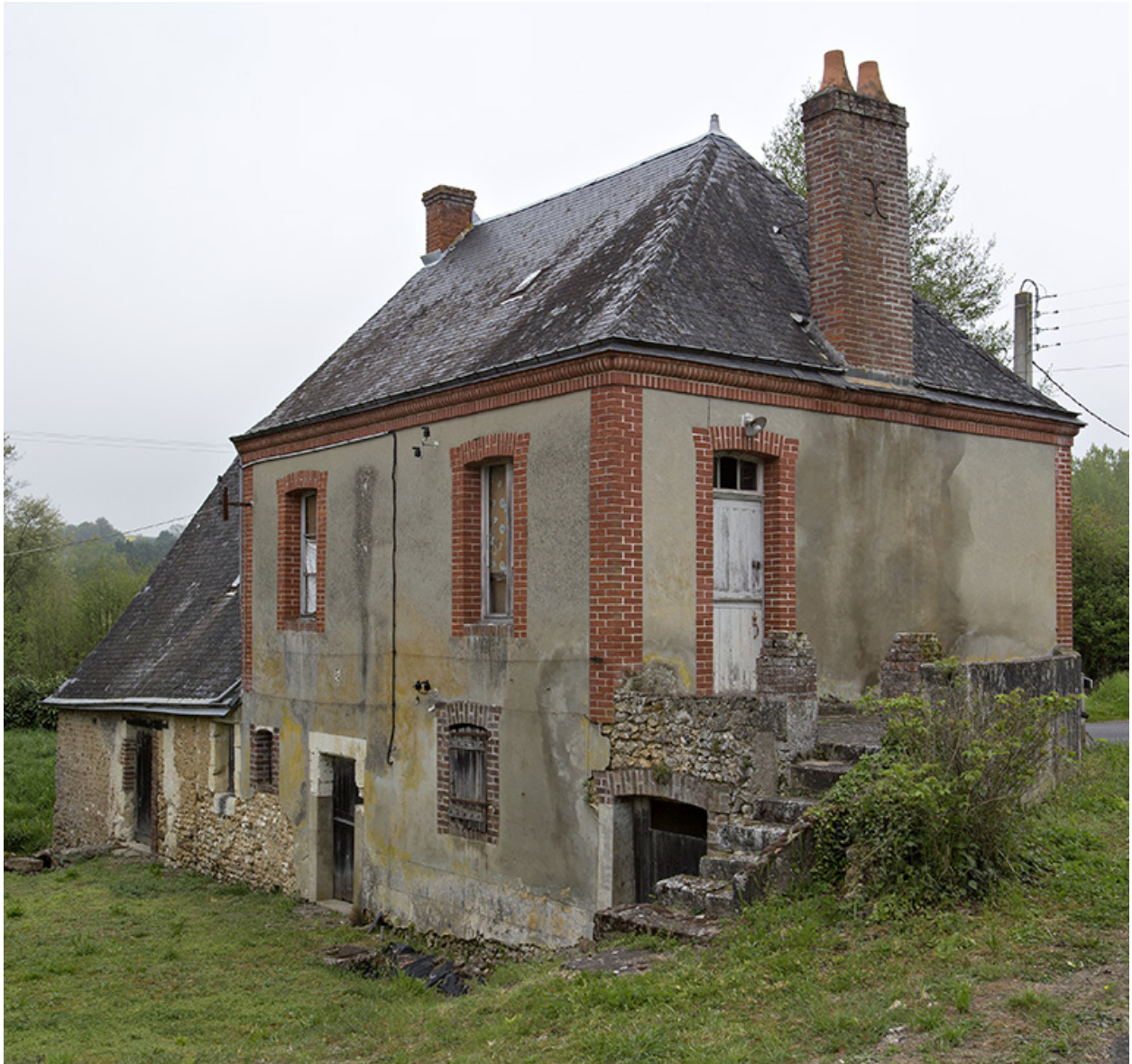
La meunerie et la maison, de volume.
