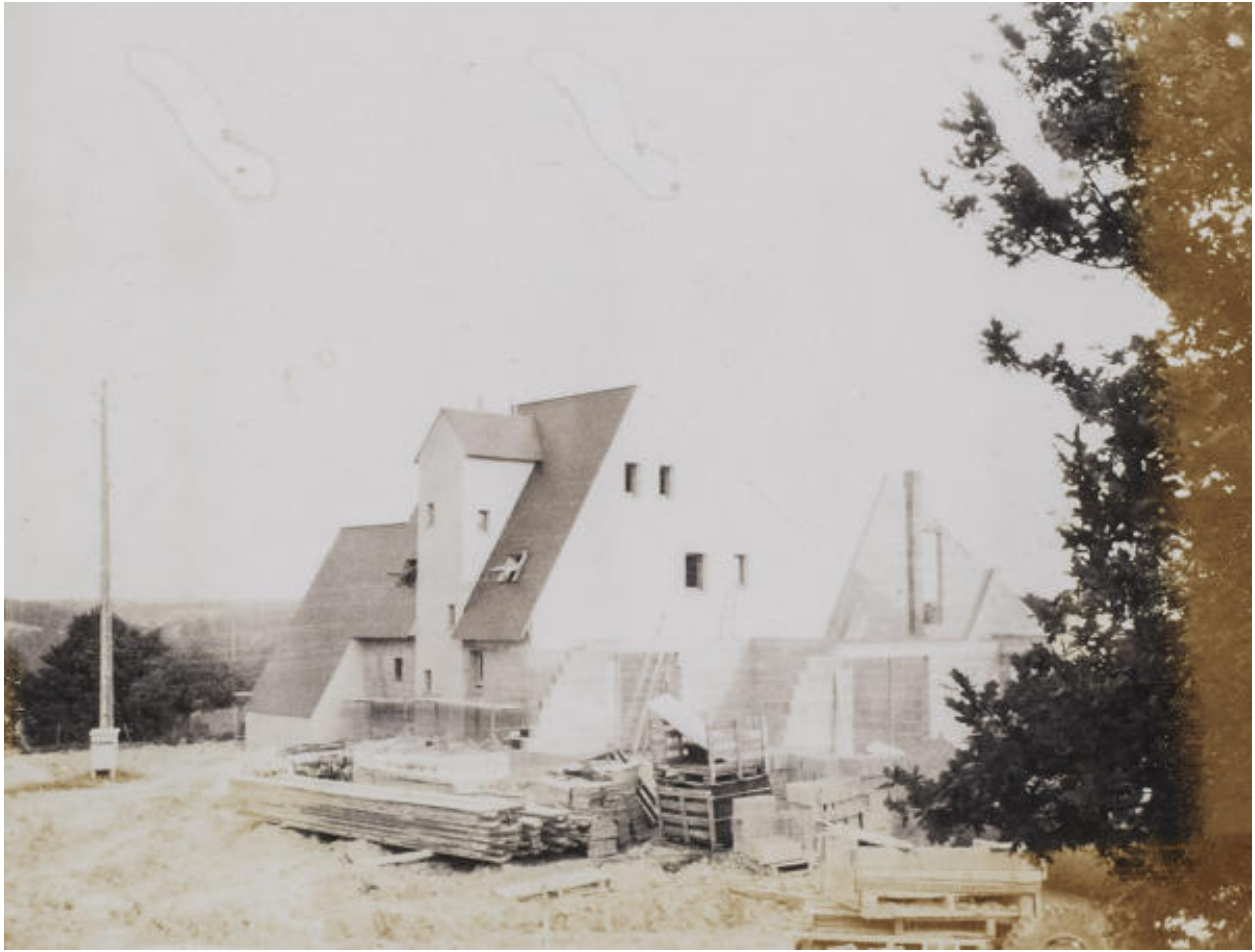
La maison en construction, 1978.
