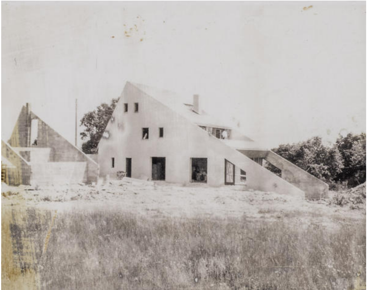
La maison en construction, 1978.
