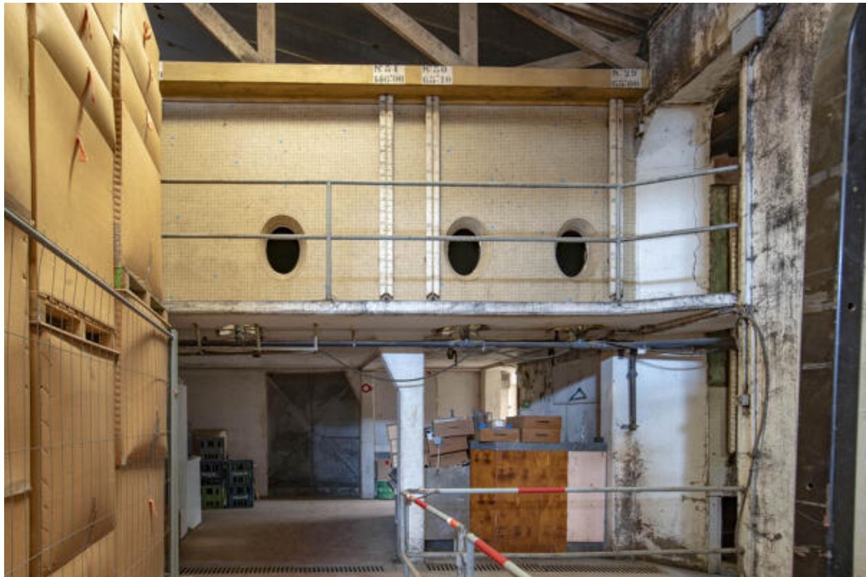
Cuves aériennes sur pilotis.
