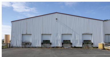
Le dernier magasin construit et ses quais. Phot. Pierre-Bernard Fourny IVR52_20224400340NUCA
