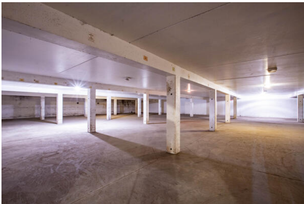
Zone de stockage des bouteilles, semi-enterrée.
