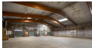
Les quais d'expédition. Phot. Pierre-Bernard Fourny IVR52_20224400344NUCA
