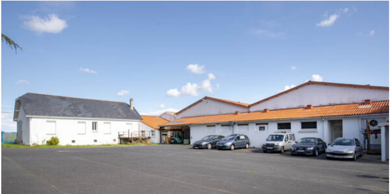
Bureaux et magasins, vue du sud.
