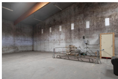
Monte-charge, opérant entre la zone de stockage des bouteilles et les quais d'expédition. Phot. Pierre-Bernard Fourny IVR52_20224400345NUCA
