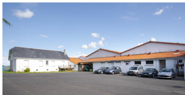
Bureaux et magasins, vue du sud. Phot. Pierre-Bernard Fourny IVR52_20224400341NUCA
