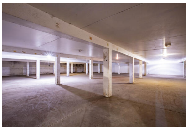
Zone de stockage des bouteilles, semi-enterrée. Phot. Pierre-Bernard Fourny IVR52_20224400343NUCA
