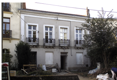
La façade antérieure depuis le quai. Phot. Denis Pillet IVR52_20034401337NUCA
