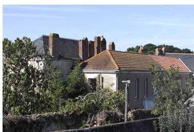
Au premier plan, le corps secondaire vu depuis l'impasse des Caillebottes. Phot. Denis Pillet IVR52_20034401420NUCA
