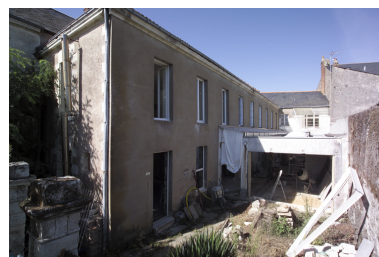
La maison vue depuis le jardin. Phot. Denis Pillet IVR52_20034401101NUCA
