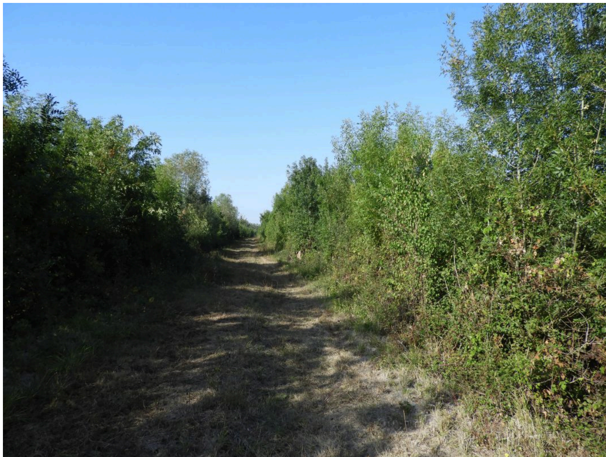
La digue entre la Bonde des Jourdain et la Simarie, en direction de l'ouest.
