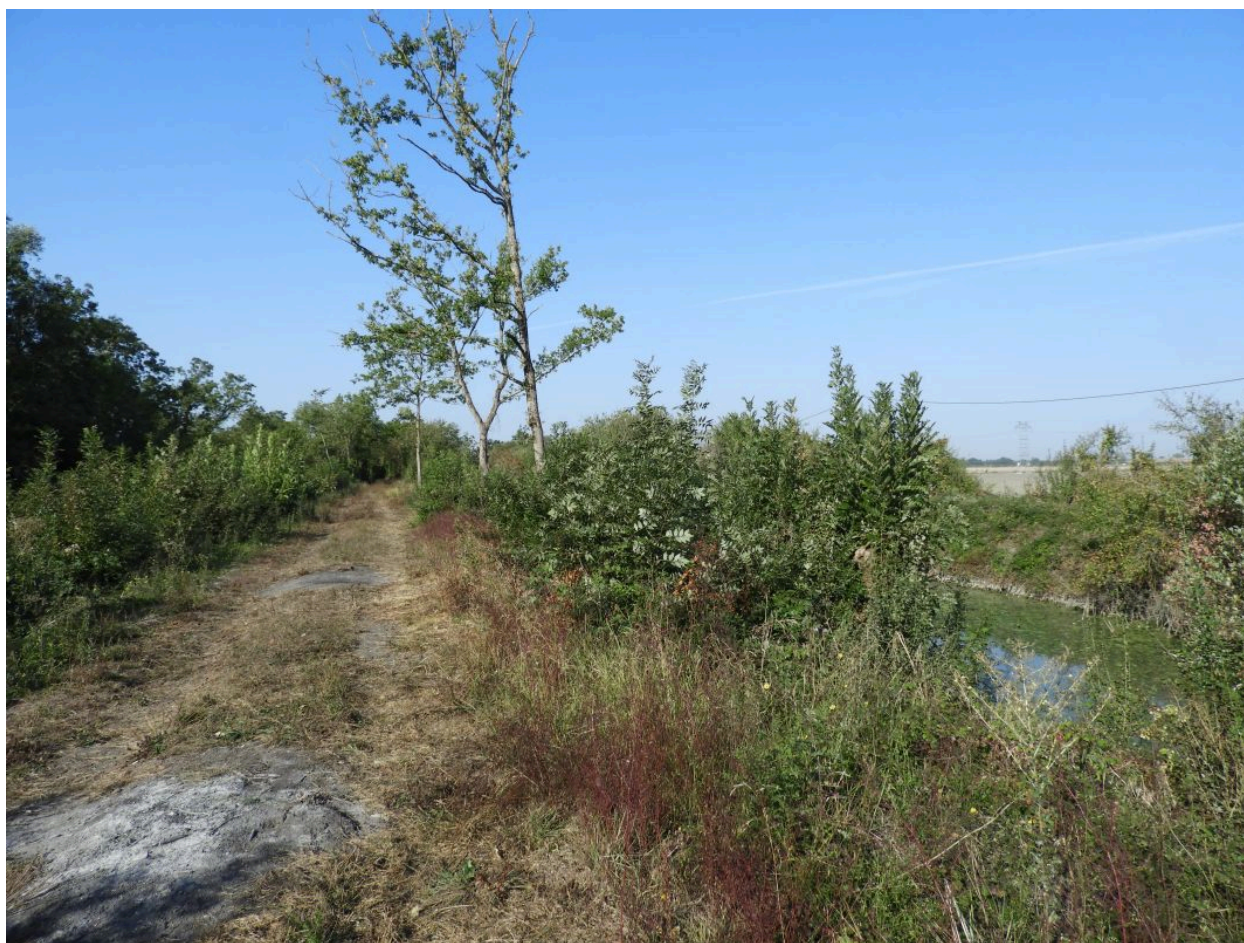
La digue entre la Bonde des Jourdain et la Simarie, en direction de l'ouest, avec le canal de Vix à droite.
