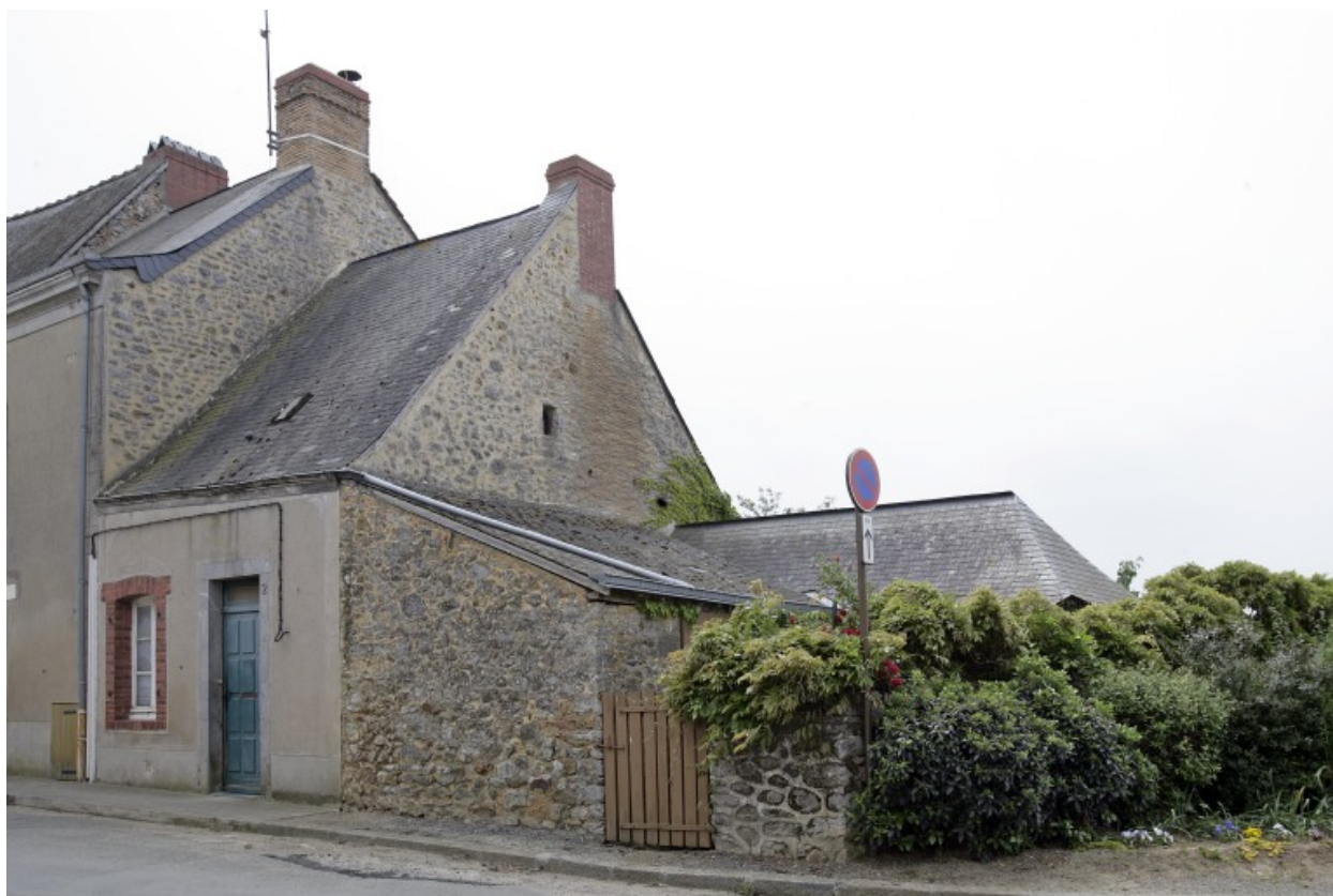
Le corps en rez-de-chaussée de la maison et les dépendances contigües vues depuis la rue au nord.
