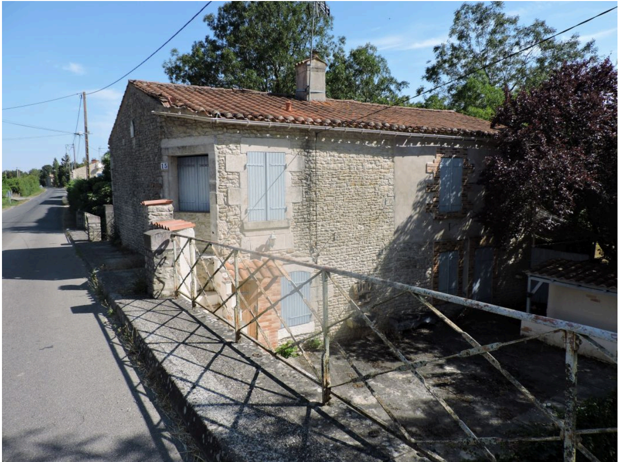
La maison vue depuis le pont sur le canal de Vix qui la surplombe, au sud-ouest.
