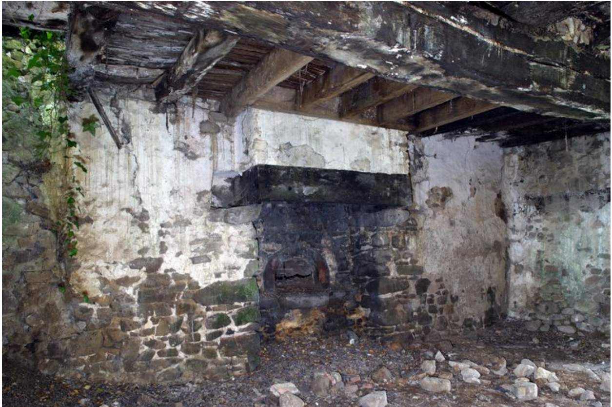
Rez-de-chaussée, pièce sud : vue d'ensemble depuis le nord-ouest.
