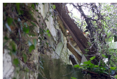
Etage : détail du mur est. L'extrémité du poteau sud est coupée sous la sablière. Phot. François Lasa IVR52_20055301571NUCA
