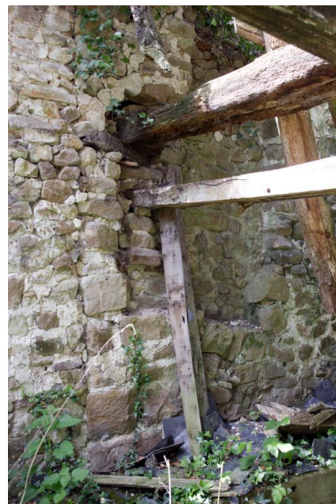
Intérieur de l'étable, mur sud : jonction des maçonneries de l'ancien logis et de l'étable. Phot. François Lasa IVR52_20055301578NUCA
