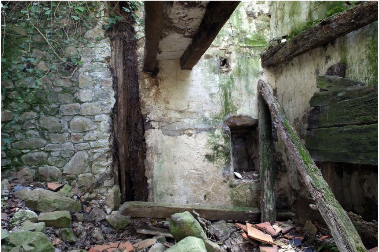
Rez-de-chaussée, pièce nord : le mur est.
