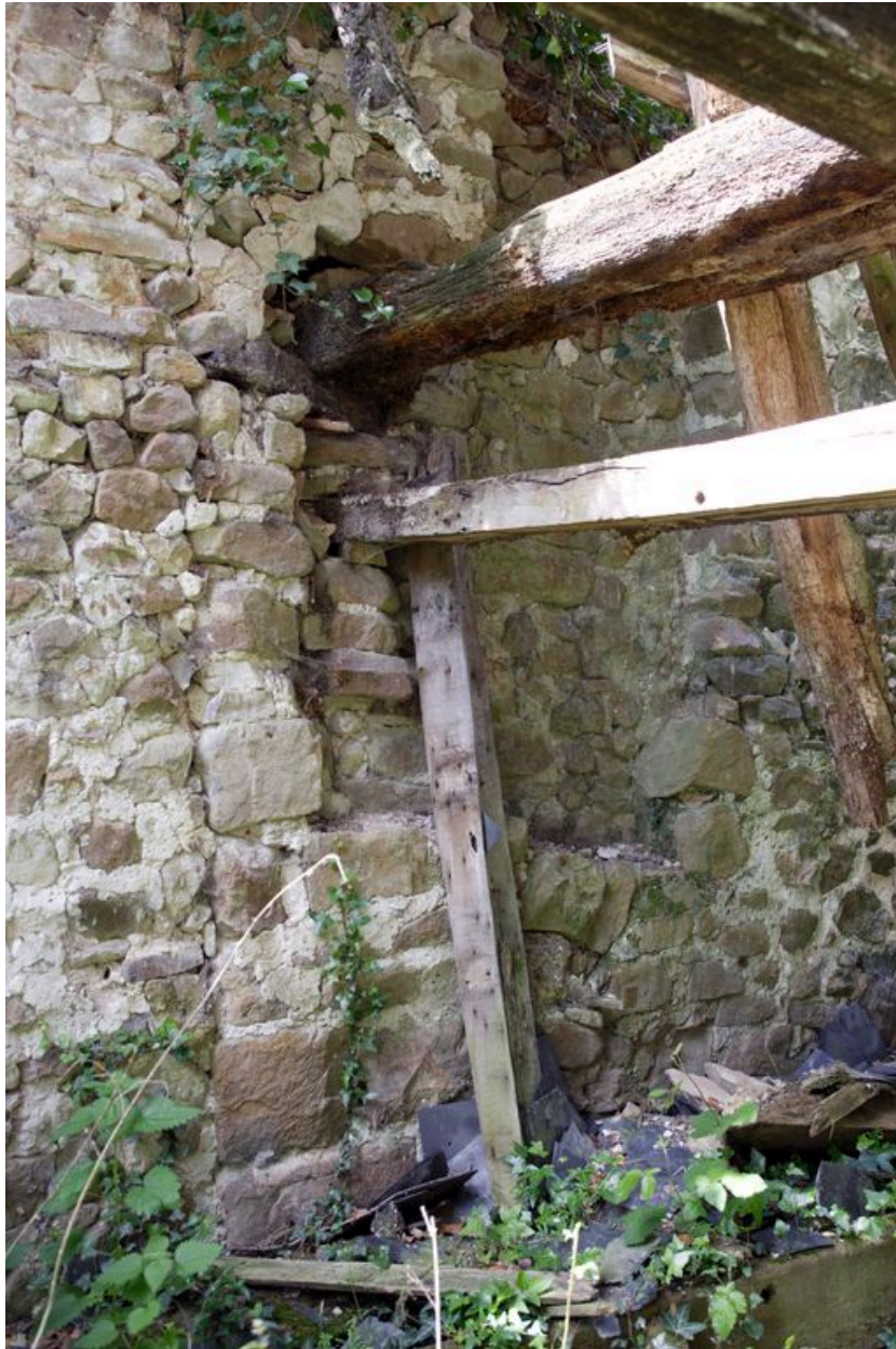
Intérieur de l'étable, mur sud : jonction des maçonneries de l'ancien logis et de l'étable.
