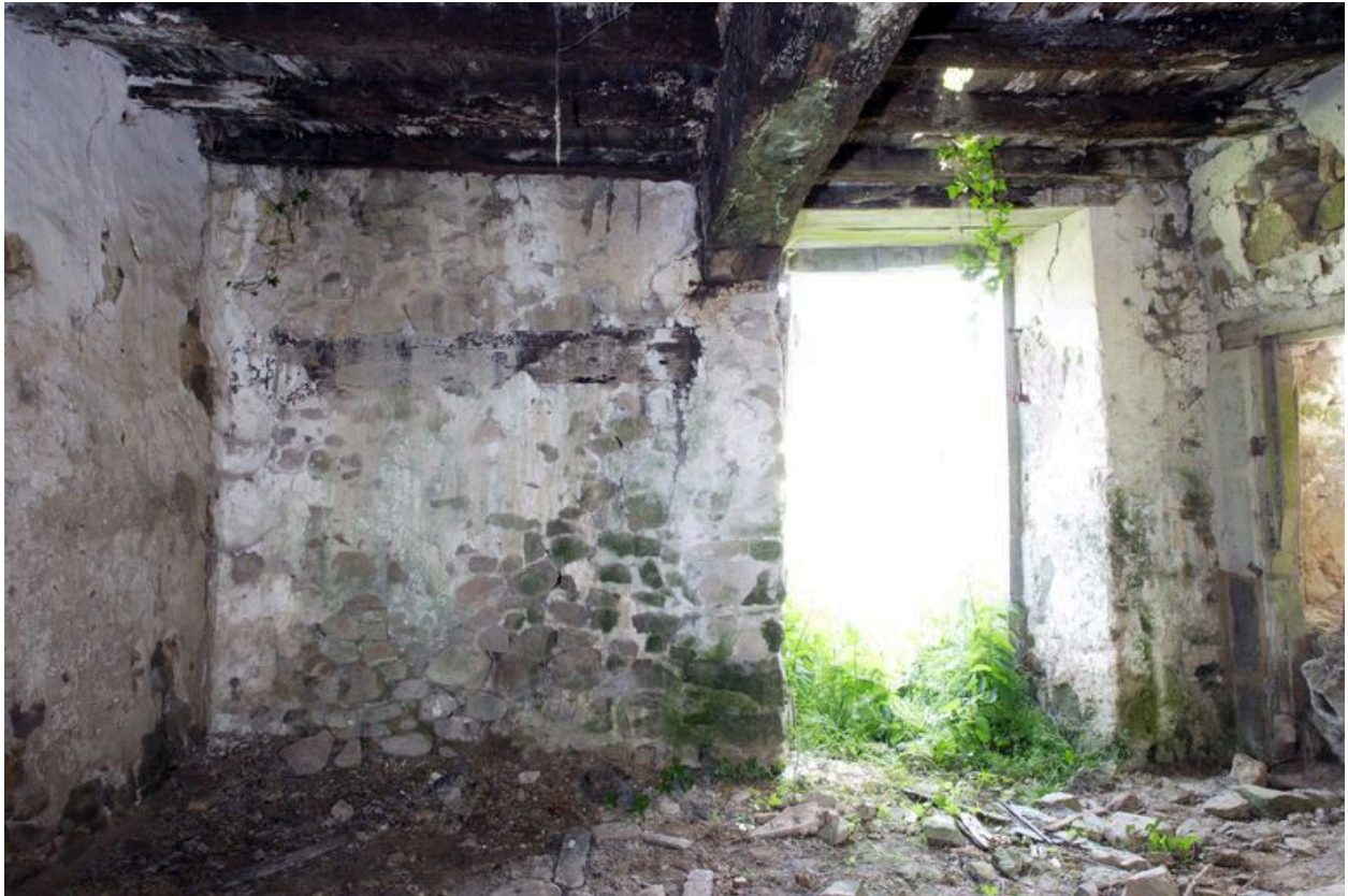
Rez-de-chaussée, pièce sud : le mur ouest.
