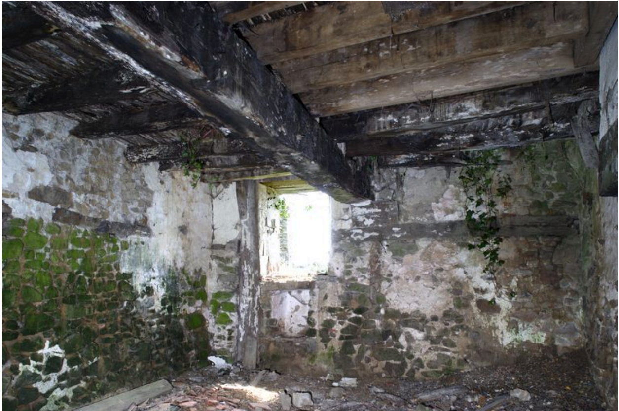
Rez-de-chaussée, pièce sud : le mur est.
