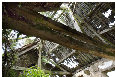
La charpente vue depuis le nord. Phot. François Lasa IVR52_20055301570NUCA
