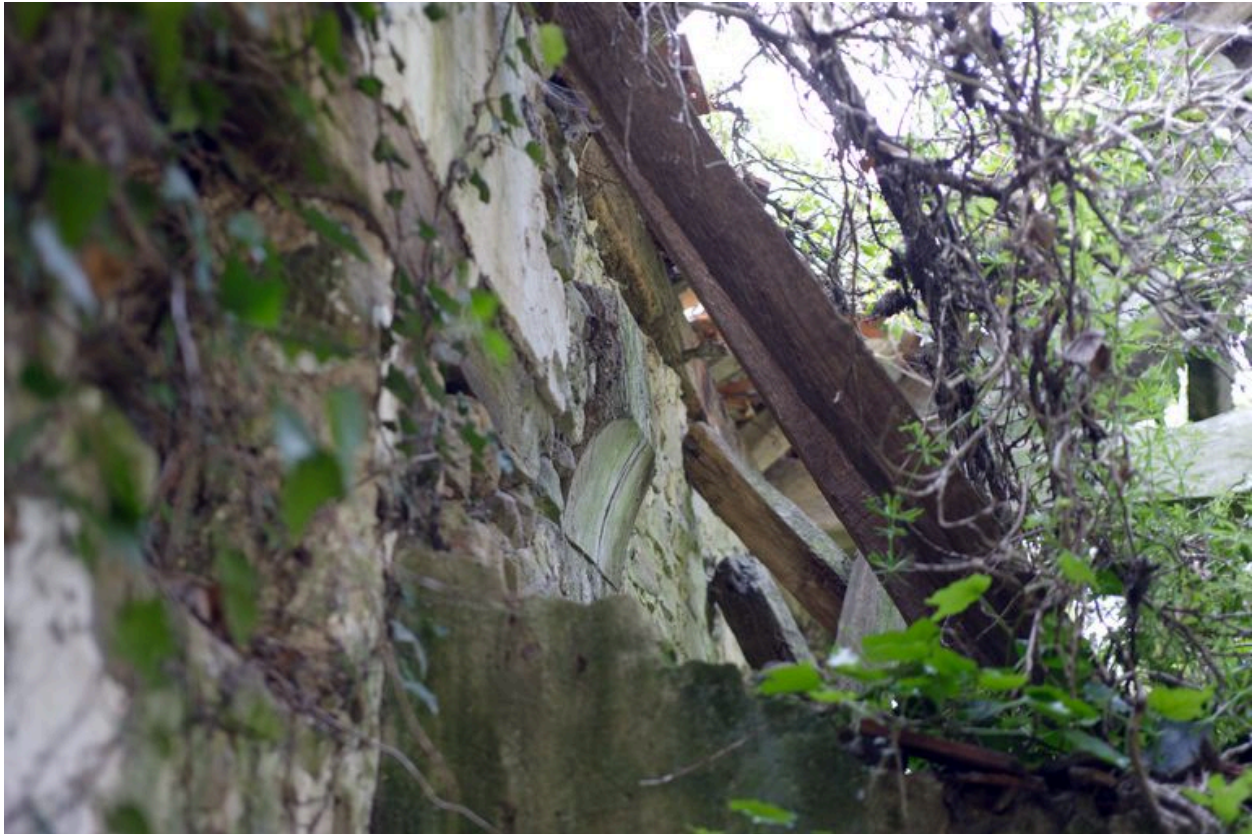
Etage : détail du mur est. L'extrémité du poteau sud est coupée sous la sablière.
