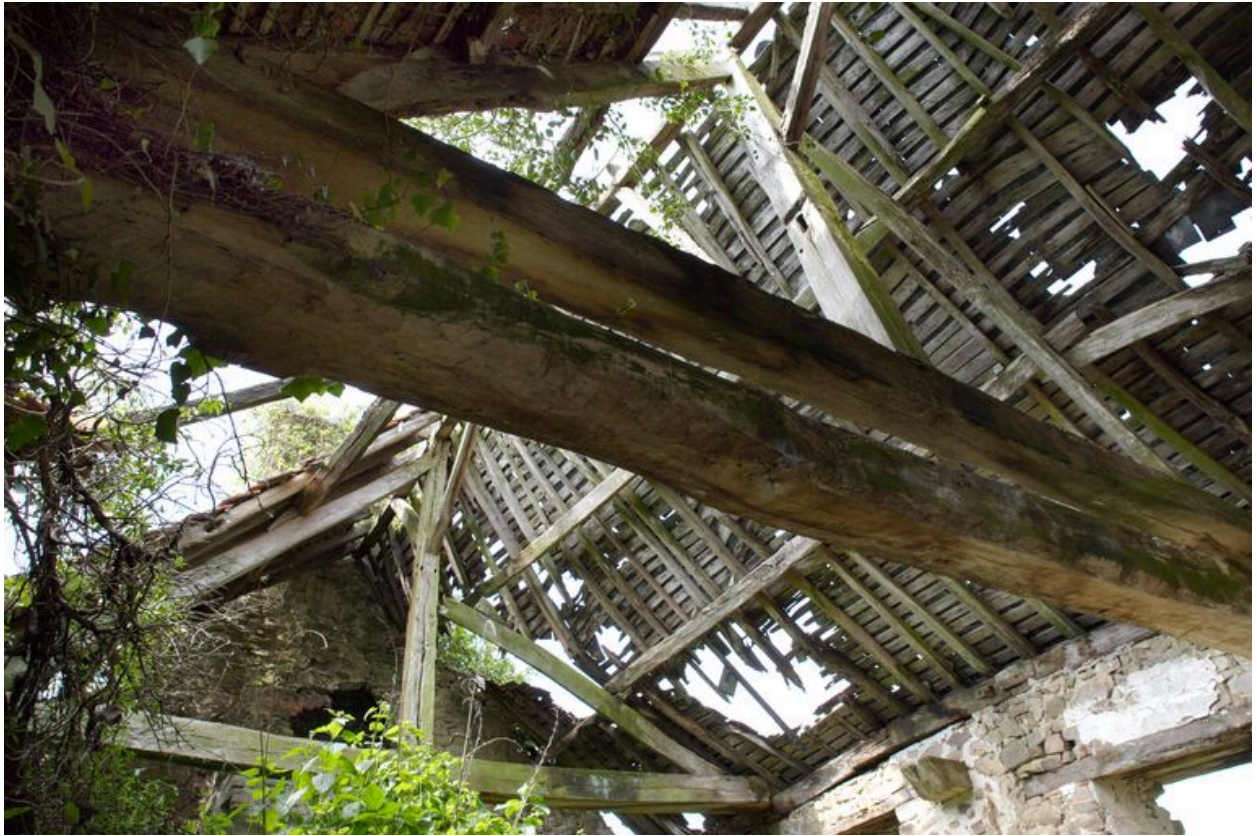
La charpente vue depuis le nord.
