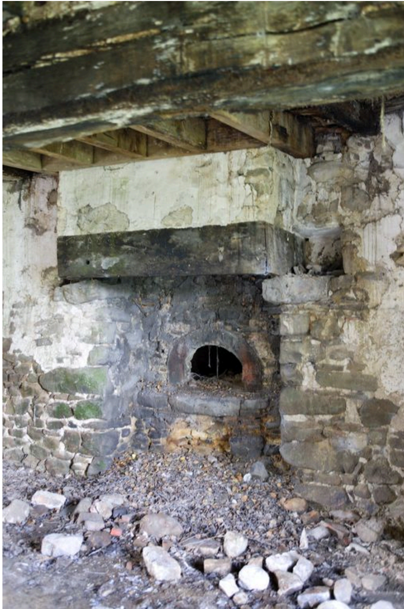
Rez-de-chaussée, pièce sud : la cheminée.
