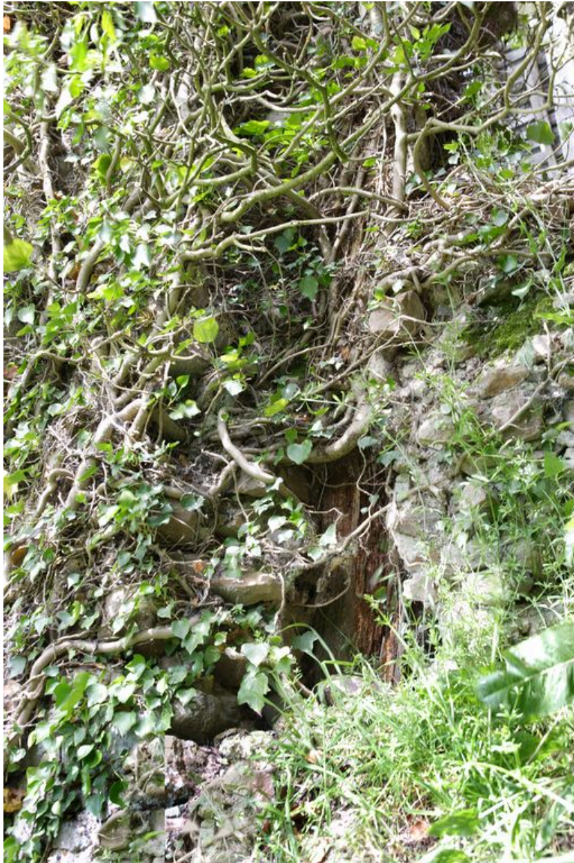
Détail du mur est de l'ancien logis : arétier nord de la partie centrale.
