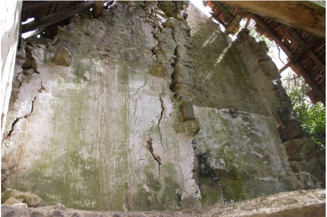
Etage : le pignon nord et les vestiges de la cheminée.
