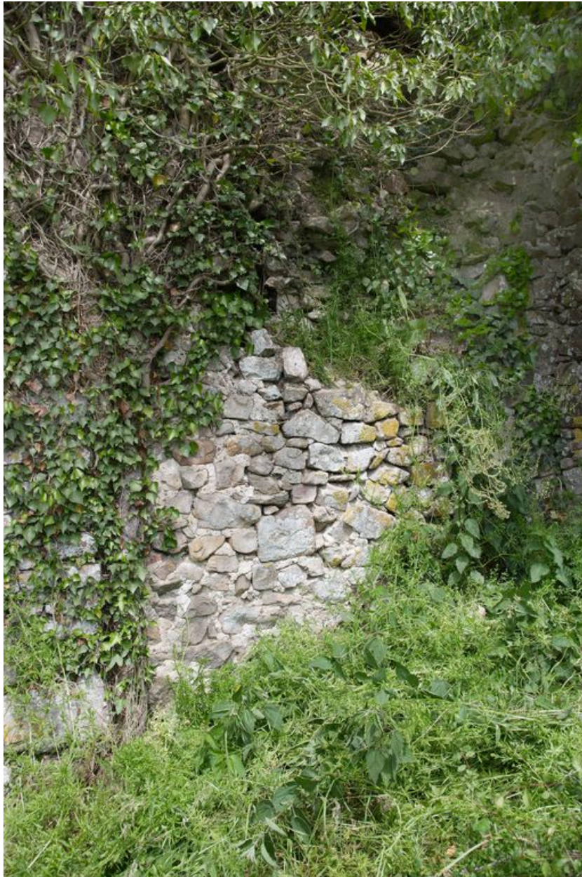
Détail du mur est de l'ancien logis : reprise de maçonnerie (ou arétier nord de la partie centrale????) sur la partie nord.
