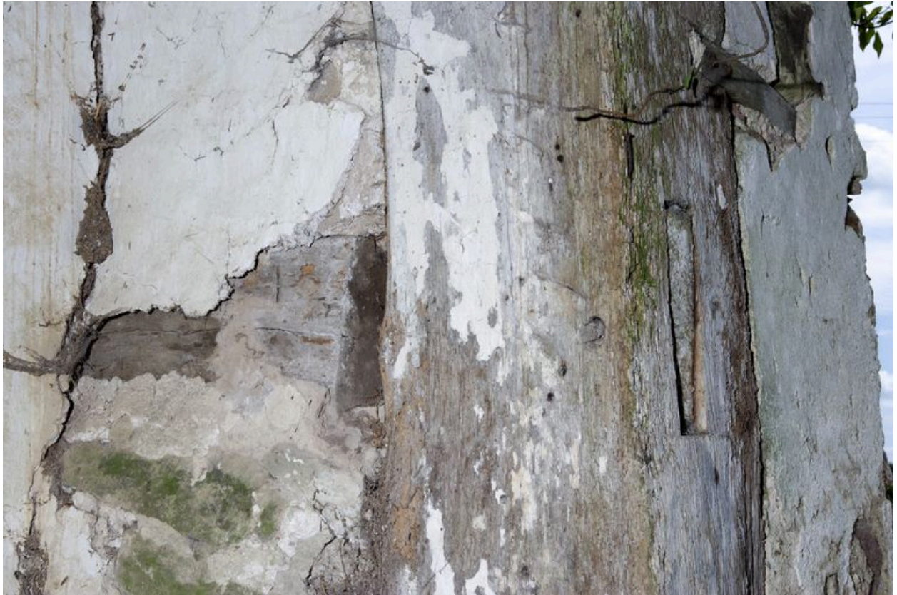
Rez-de-chaussée, pièce sud, mur est : détail de l'assemblage du poteau et de la poutre inférieure.
