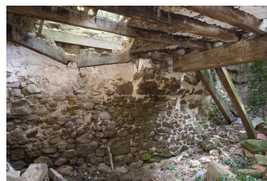
Rez-de-chaussée, pièce nord : le mur nord (?) Phot. François Lasa IVR52_20055301568NUCA
