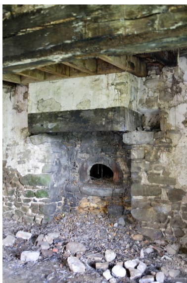
Rez-de-chaussée, pièce sud : la cheminée. Phot. François Lasa IVR52_20055301572NUCA
