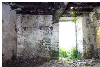
Rez-de-chaussée, pièce sud : le mur ouest. Phot. François Lasa IVR52_20055301565NUCA
