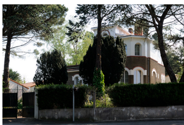
Maison d'Eugène Hy, industriel, Saint-Macaire-en-Mauges. Phot. Bruno Rousseau, Phot. Youenn Communeau IVR52_20114901318NUCA
