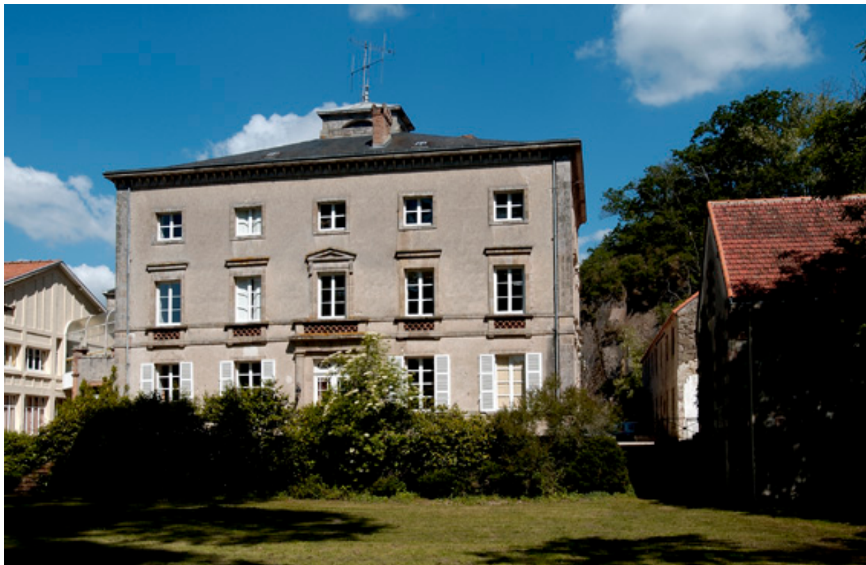
Logement patronal de l'usine textile dite filature de Gallard, façade sud (sur le parc).
