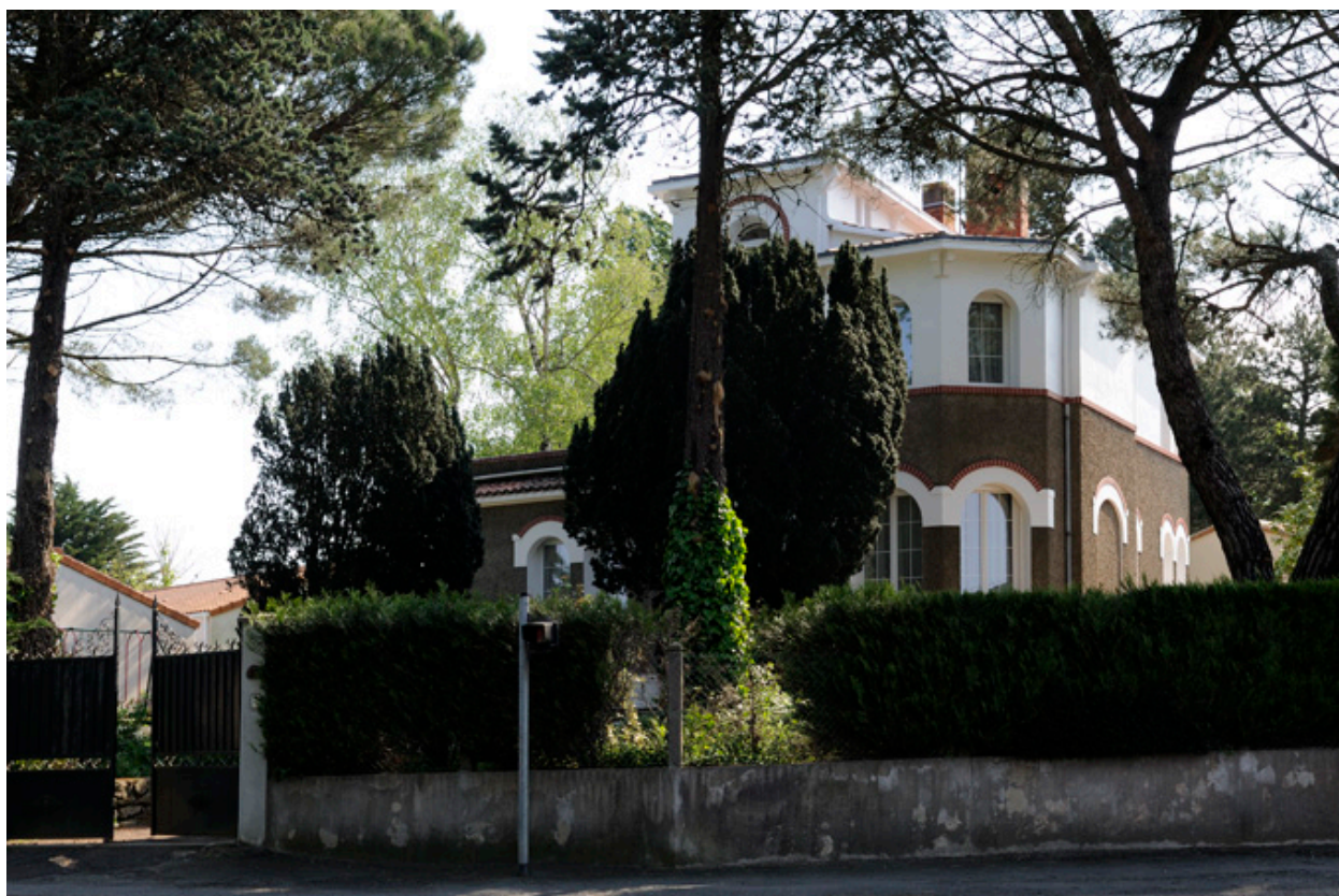
Maison d'Eugène Hy, industriel, Saint-Macaire-en-Mauges.
