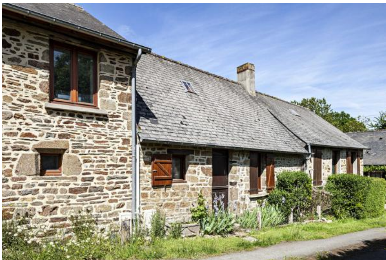
Maison possédant des vestiges de structures à poteaux porteurs, la Beslinière.
