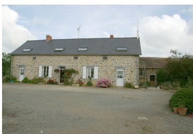
Le logis et la porcherie-bergerie. Phot. François Lasa IVR52_20035302269NUCA
