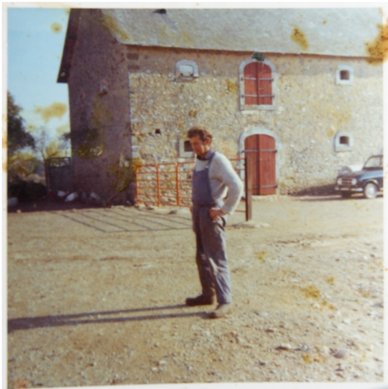
Photographie, 1966. La partie nord de l'étable-grange avant sa démolition.
