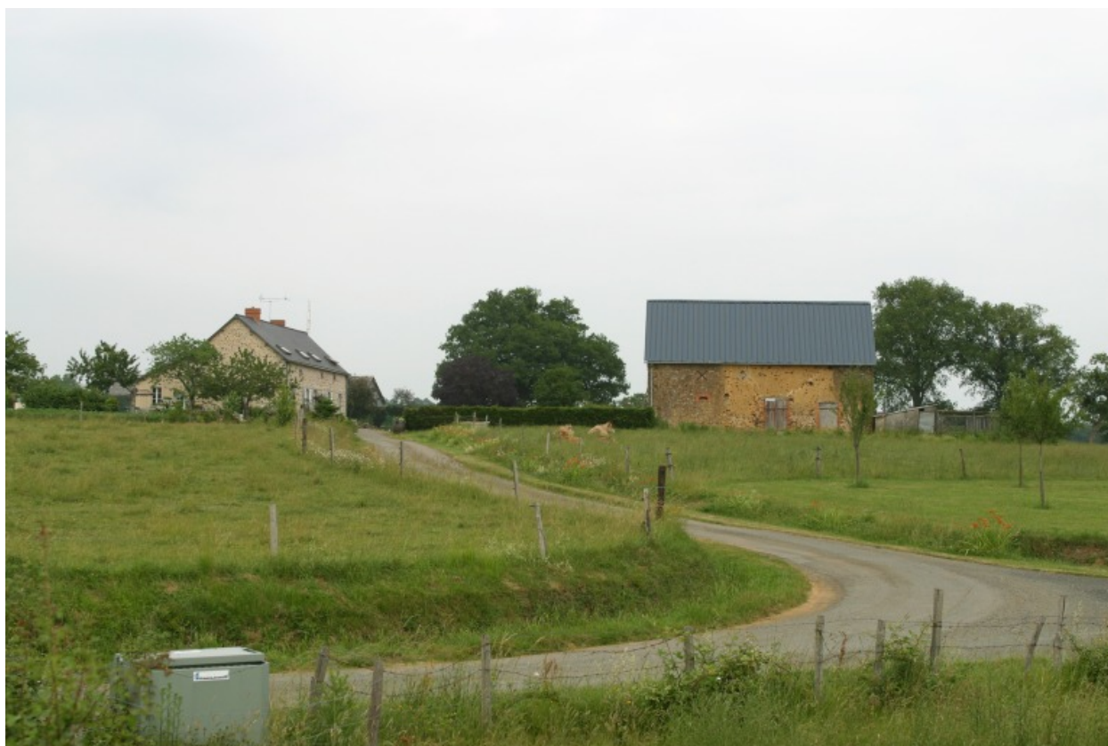
Vue d'ensemble depuis la route de Thorigné au sud-ouest : le logis, la remise.
