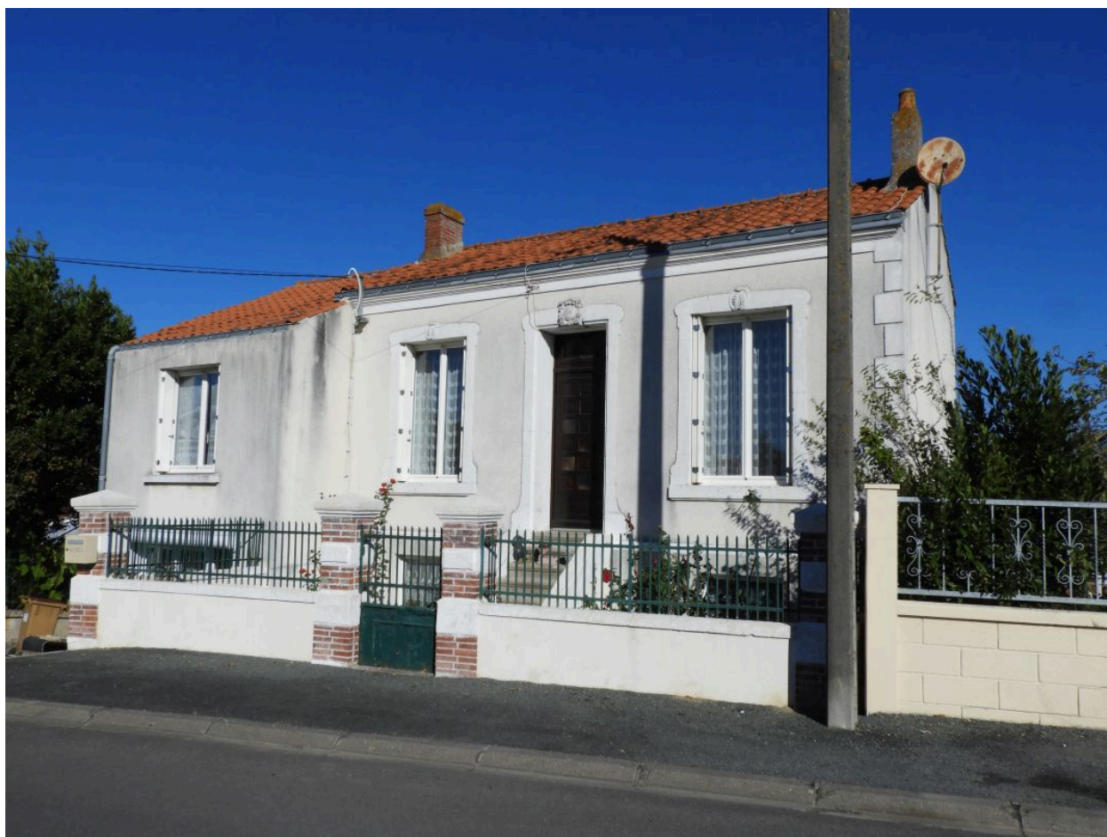
La maison vue depuis le sud-est.
