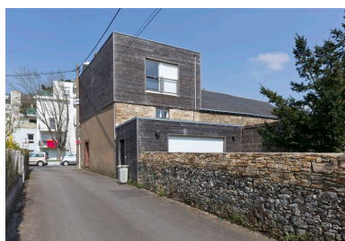
Arrière des dépendances transformées en maison. Phot. Denis Pillet IVR52_20134401418NUCA
